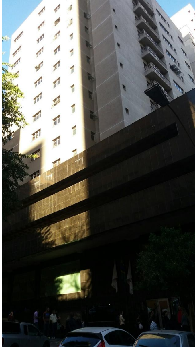
Edifício Rua Mato Grosso, nº 468
