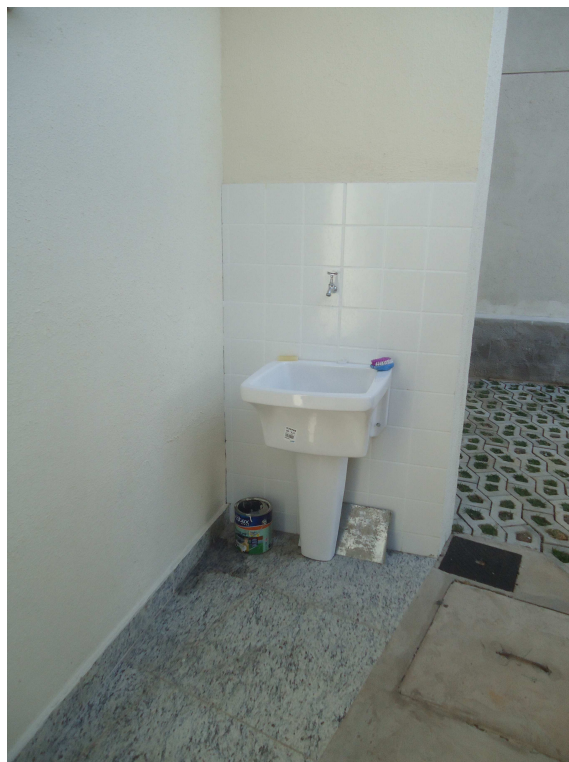
TANQUE DATA: MAIO/2016
