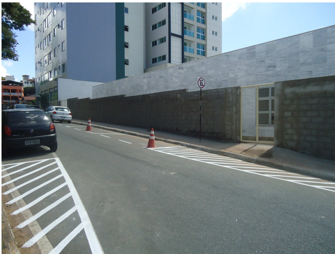
CALÇADA EXTERNA E PORTÕES DATA: ABRIL/2016
