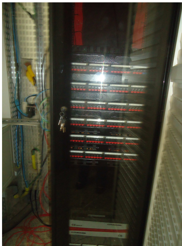
RACK E PATCH PANEL DATA: MAIO/2016
