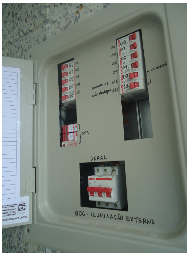
QUADRO ELÉTRICO DATA: ABRIL/2016
