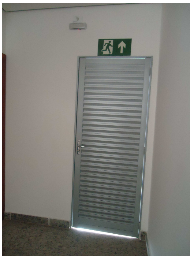
PORTA METÁLICA PRÉDIO/ESTACIONAMENTO DATA: ABRIL/2016
