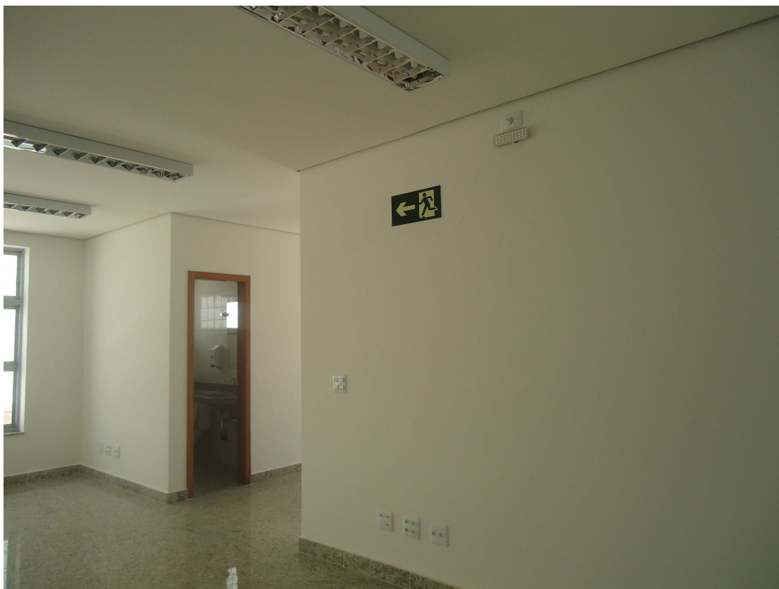
INSTALAÇÕES DE COMBATE A INCÊNDIO E ACABAMENTO INTERNO DATA: ABRIL/2016
