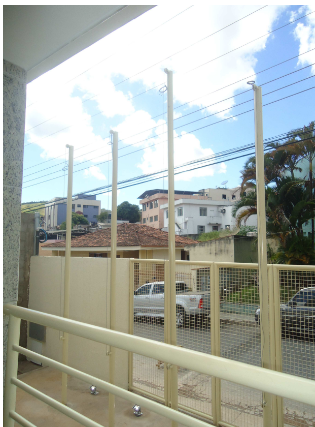
GRADIL, MASTROS, GUARDA-CORPO DATA: ABRIL/2016
