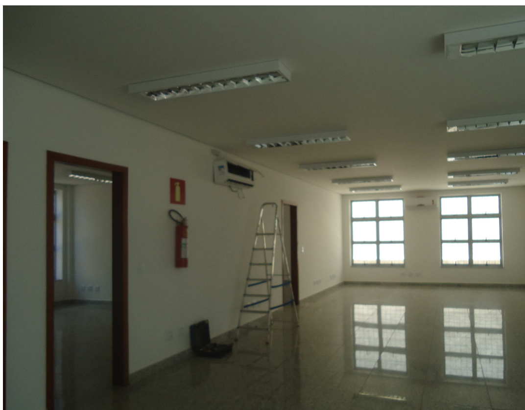
INSTALAÇÕES DE COMBATE A INCÊNDIO E ACABAMENTO INTERNO E INSTALAÇÃO AR CONDICIONADO DATA: ABRIL/2016
