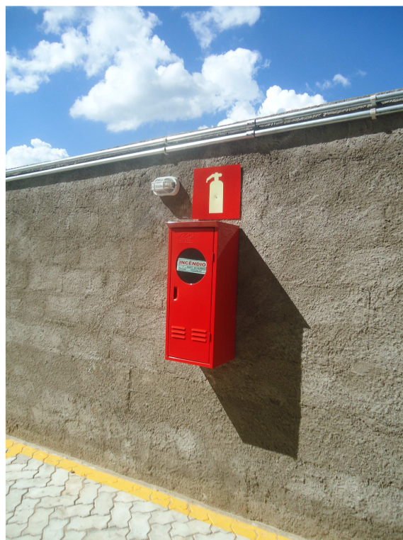
INSTALAÇÕES DE COMBATE A INCÊNDIO DATA: MAIO/2016
