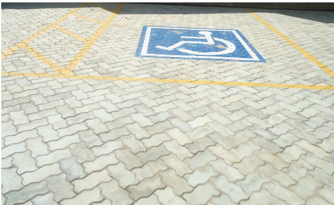
PISO INTERTRAVADO E PINTURA VAGAS DATA: MAIO/2016
