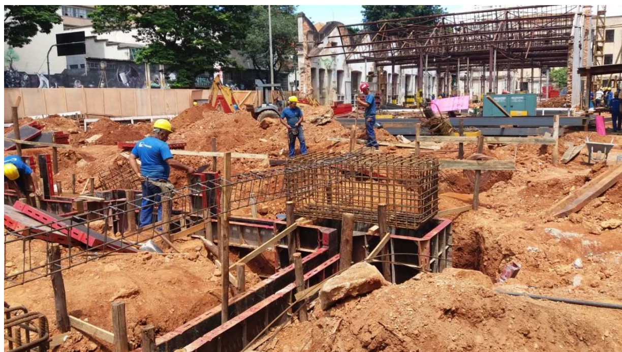
AÇO E FORMA APLICADOS - FUNDAÇÃO BLOCO 01 DATA: DEZEMBRO/2016
