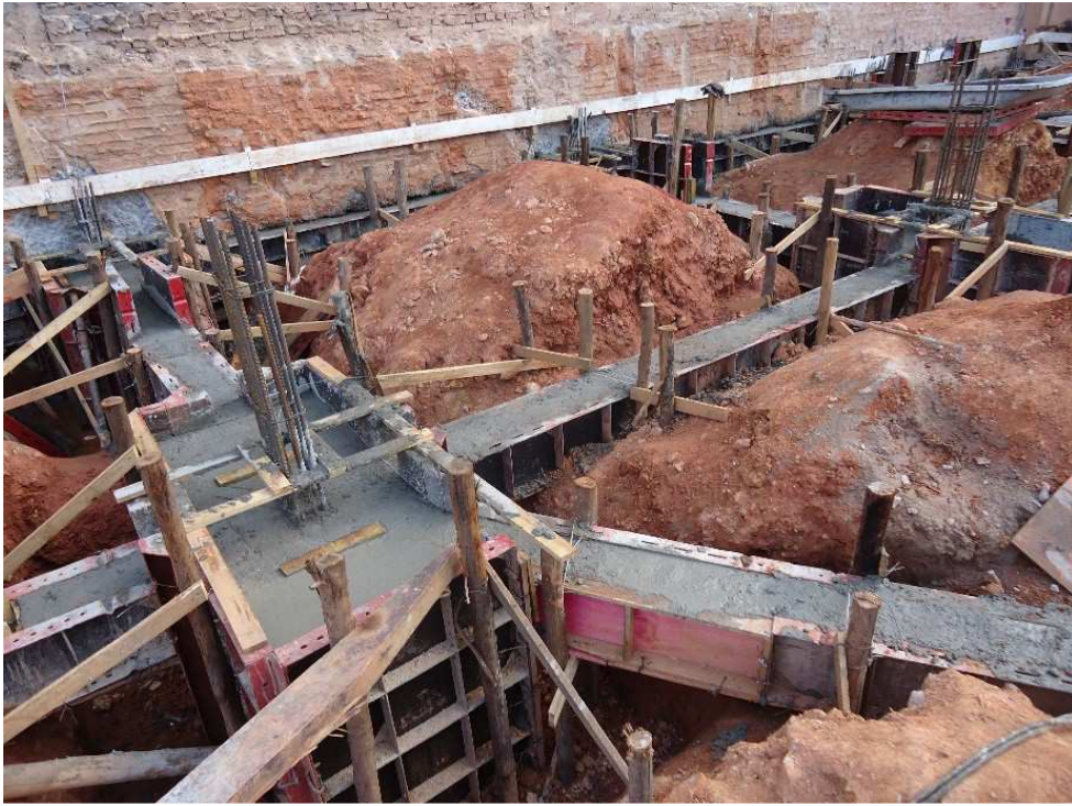
CONCRETO, AÇO E FORMA APLICADOS - FUNDAÇÃO BLOCO 01 DATA: DEZEMBRO/2016
