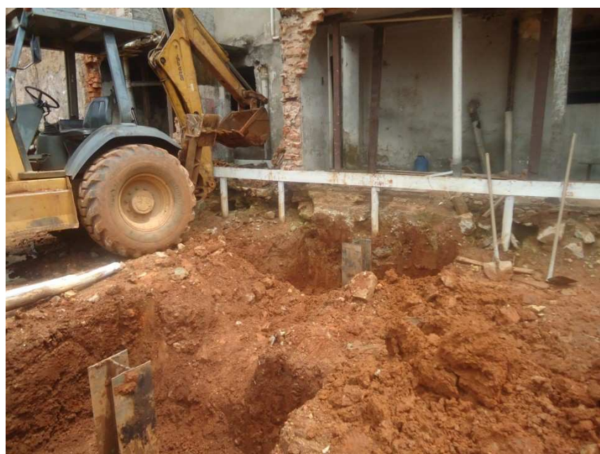
ESCAVAÇÃO BLOCOS DE FUNDAÇÃO
