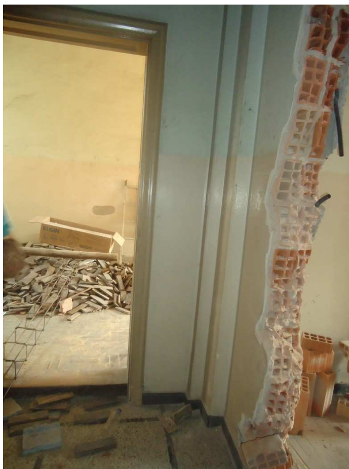
DEMOLIÇÕES MÁRIO WERNECK
