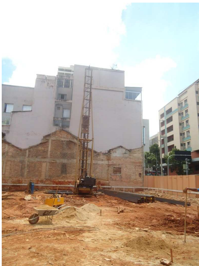
CRAVAÇÃO DE ESTACA BLOCO 01 DATA: DEZEMBRO/2016
