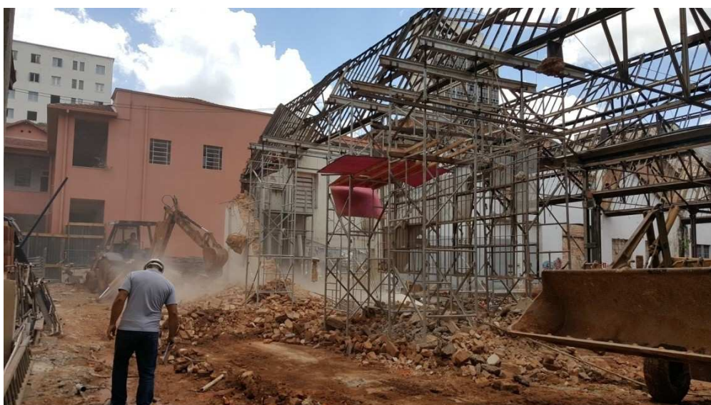
DEMOLIÇÃO COMPLETA PAREDE LATERAL OFICINA CRISTIANO OTONI DATA: DEZEMBRO/2016
