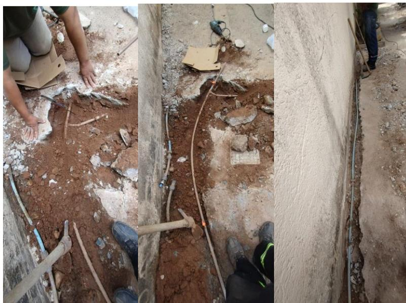
Partindo deste ponto foi instalado outro registro no ramal predial, antes da parede e depois da caixa de passagem de esgoto.
