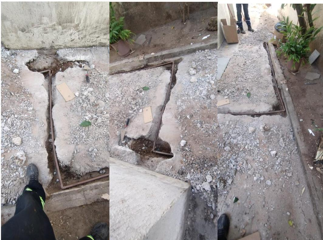
Vazamento oculto detectado entre o padrão e caixa, próximo a rede de drenagem e dentro da caixa de passagem da rede esgoto.
