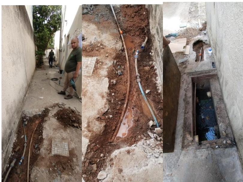
Foi instalado um registro próximo ao padrão para verificar se havia vazamento no local, visto que a terra estava úmida no local. De fato, foi detectado um pequeno vazamento próximo, mas não o suficiente para justificar o consumo fora do normal.
