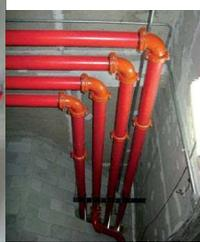
Figura 1 – Sistema ranhurado permite acoplamento mecânico de tubos, conexões e válvulas
