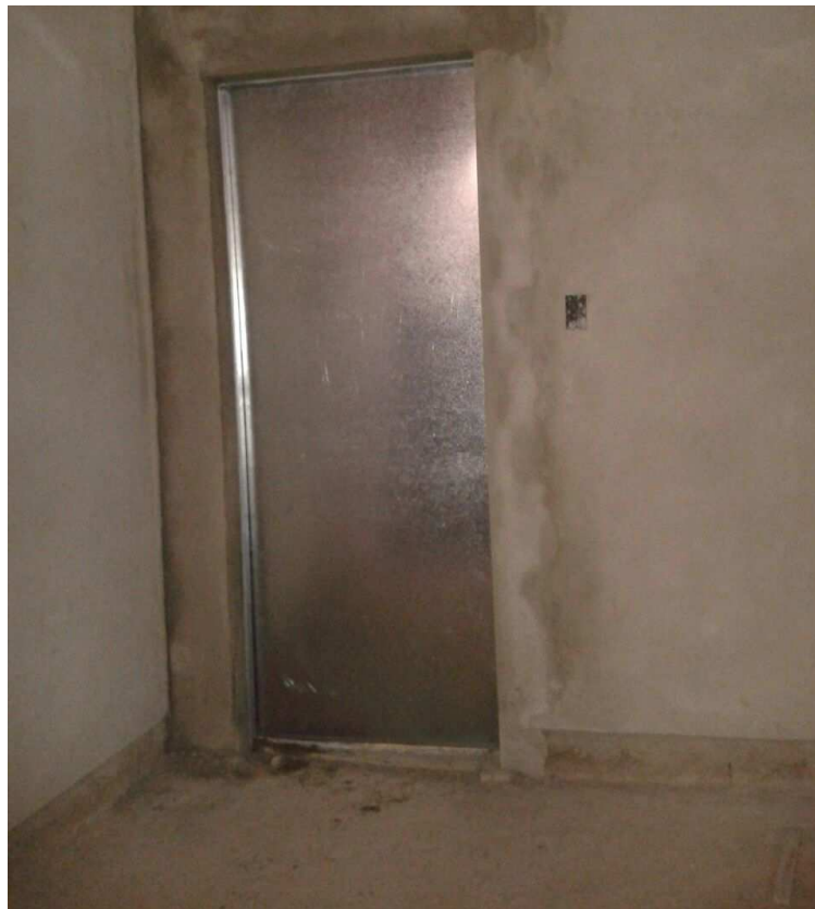
INSTALAÇÕES DE COMBATE A INCÊNDIO - PORTA CORTA-FOGO DATA: NOVEMBRO/2016
