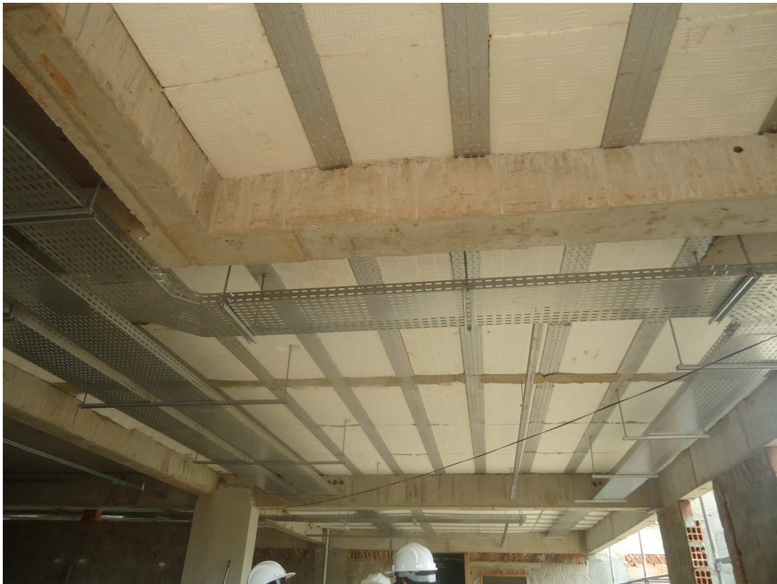
ELETROCALHAS, PERFILADOS E VERGALHÕES DATA: NOVEMBRO/2016
