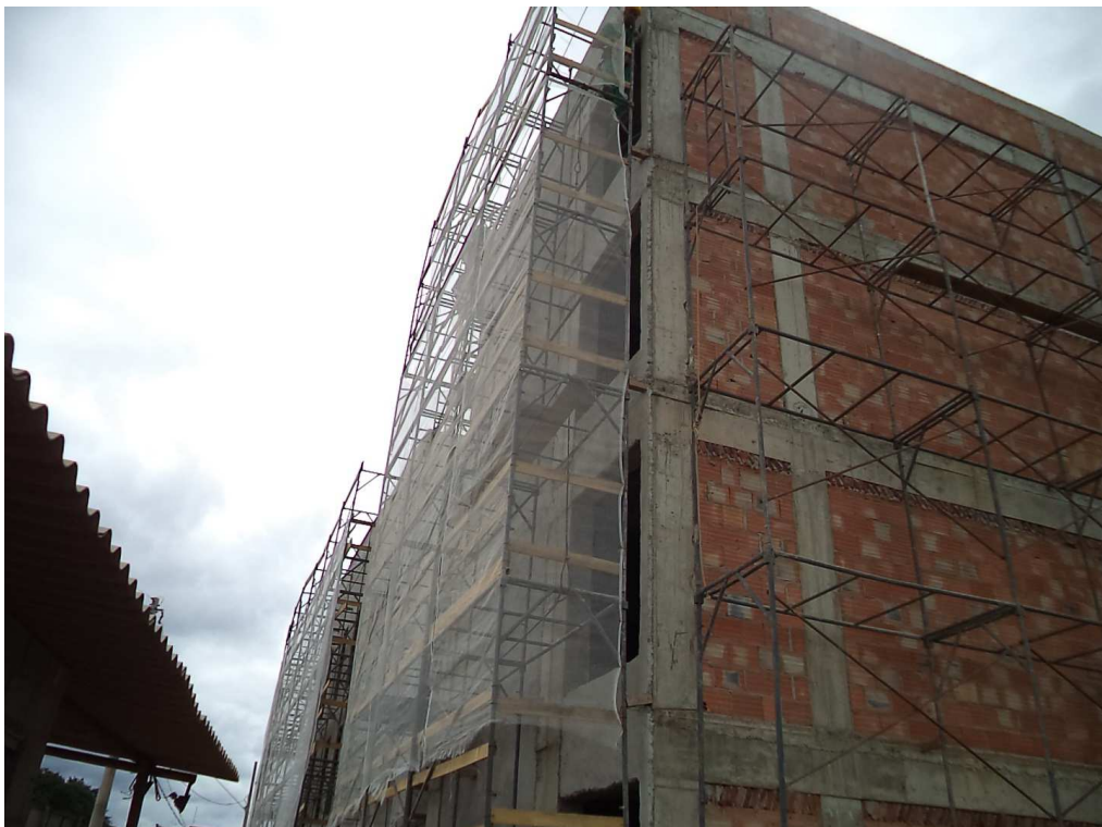
REVESTIMENTO EXTERNO FACHADA LATERAL, ANDAIMES, TELAS DATA: NOVEMBRO/2016
