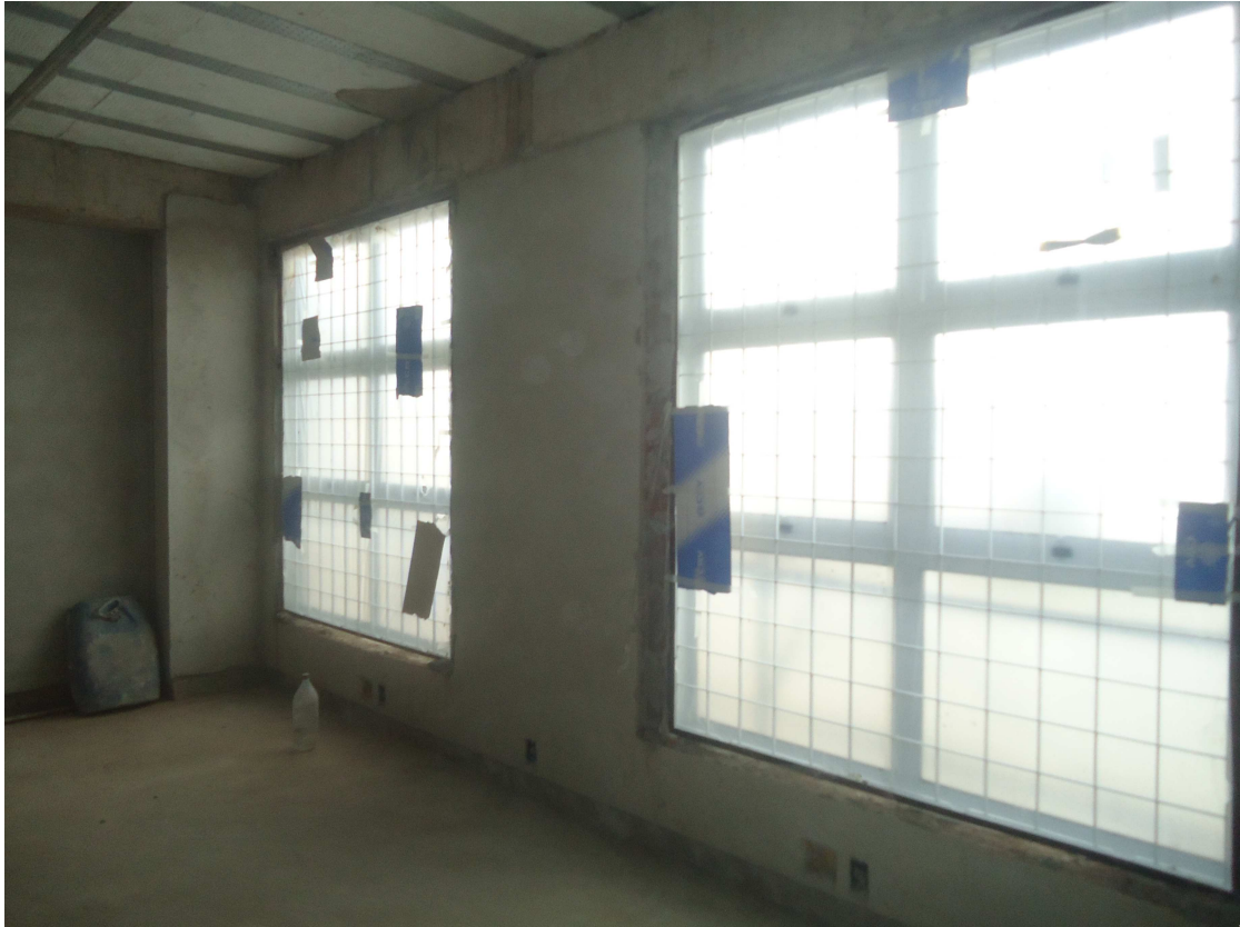
ESQUADRIAS, REVESTIMENTO INTERNO, CAIXAS DE PVC DATA: NOVEMBRO/2016
