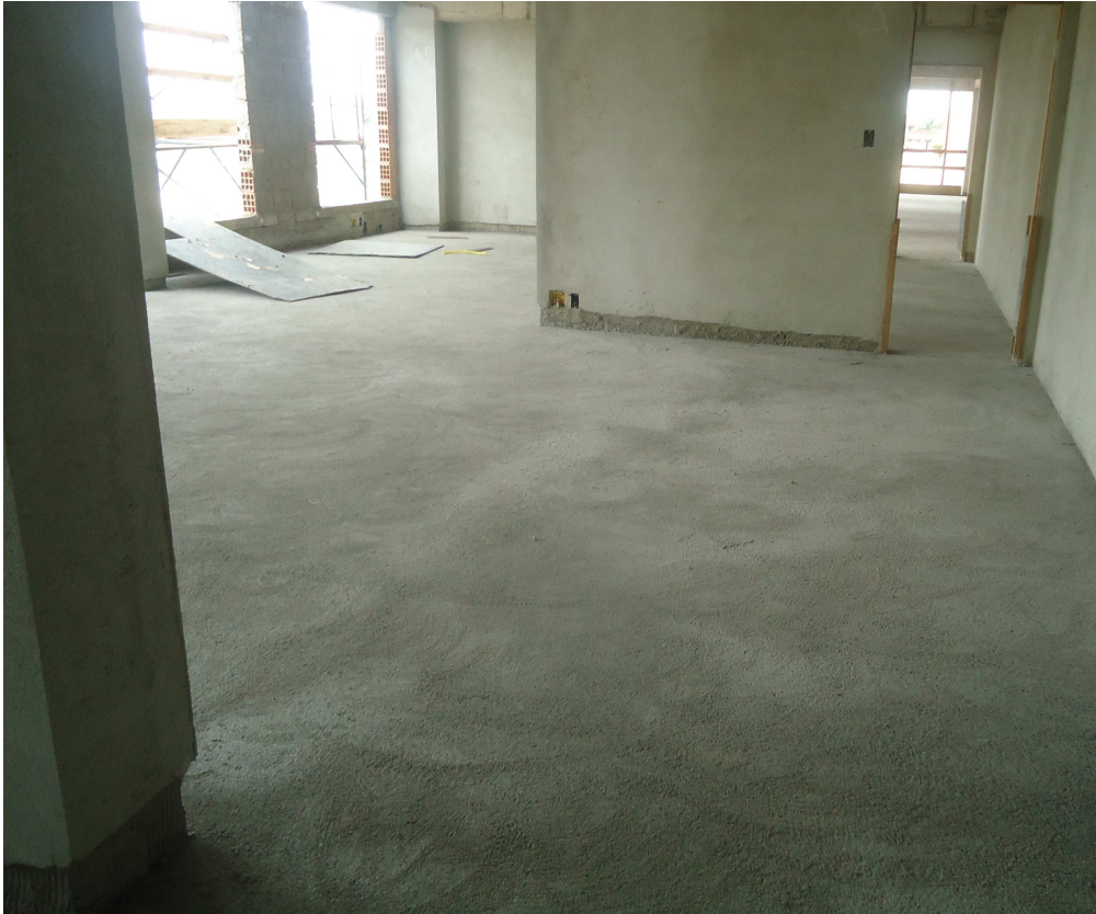
CONTRA-PISO 2º PAVIMENTO E REVESTIMENTO INTERNO DATA: NOVEMBRO/2016
