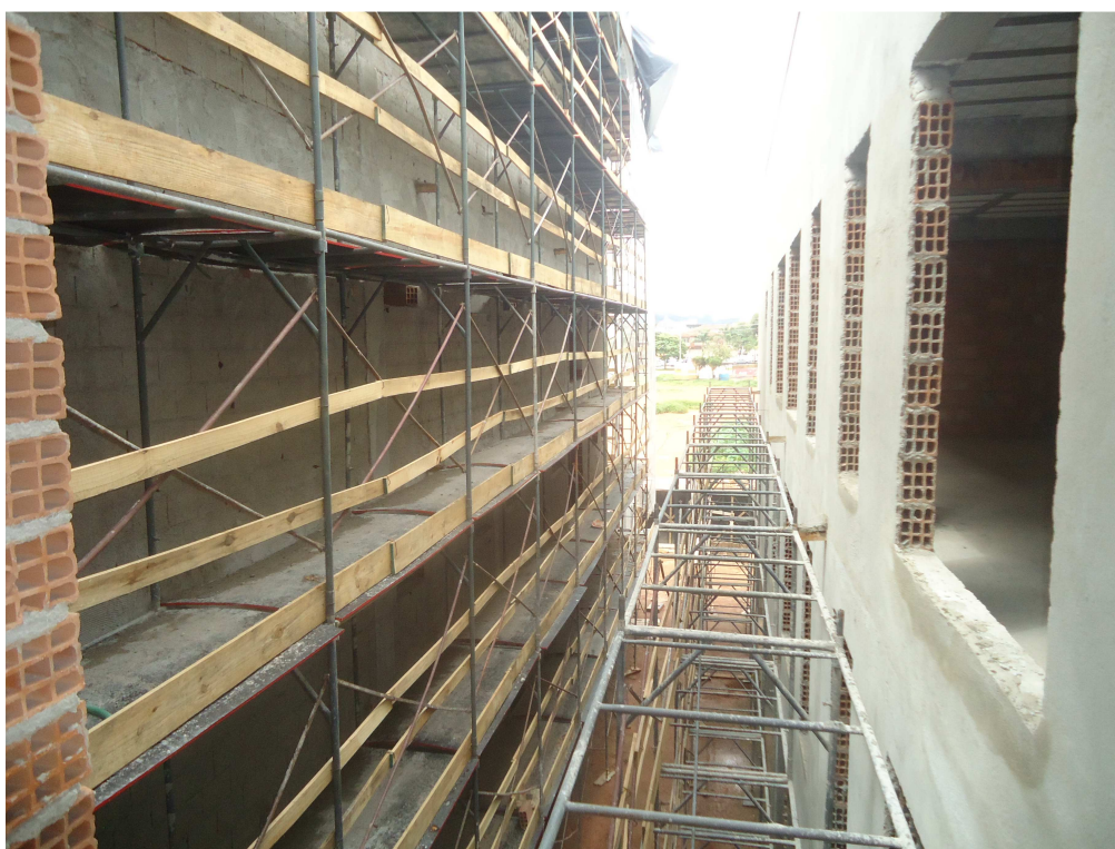
REVESTIMENTO EXTERNO E ANDAIMES DATA: NOVEMBRO/2016
