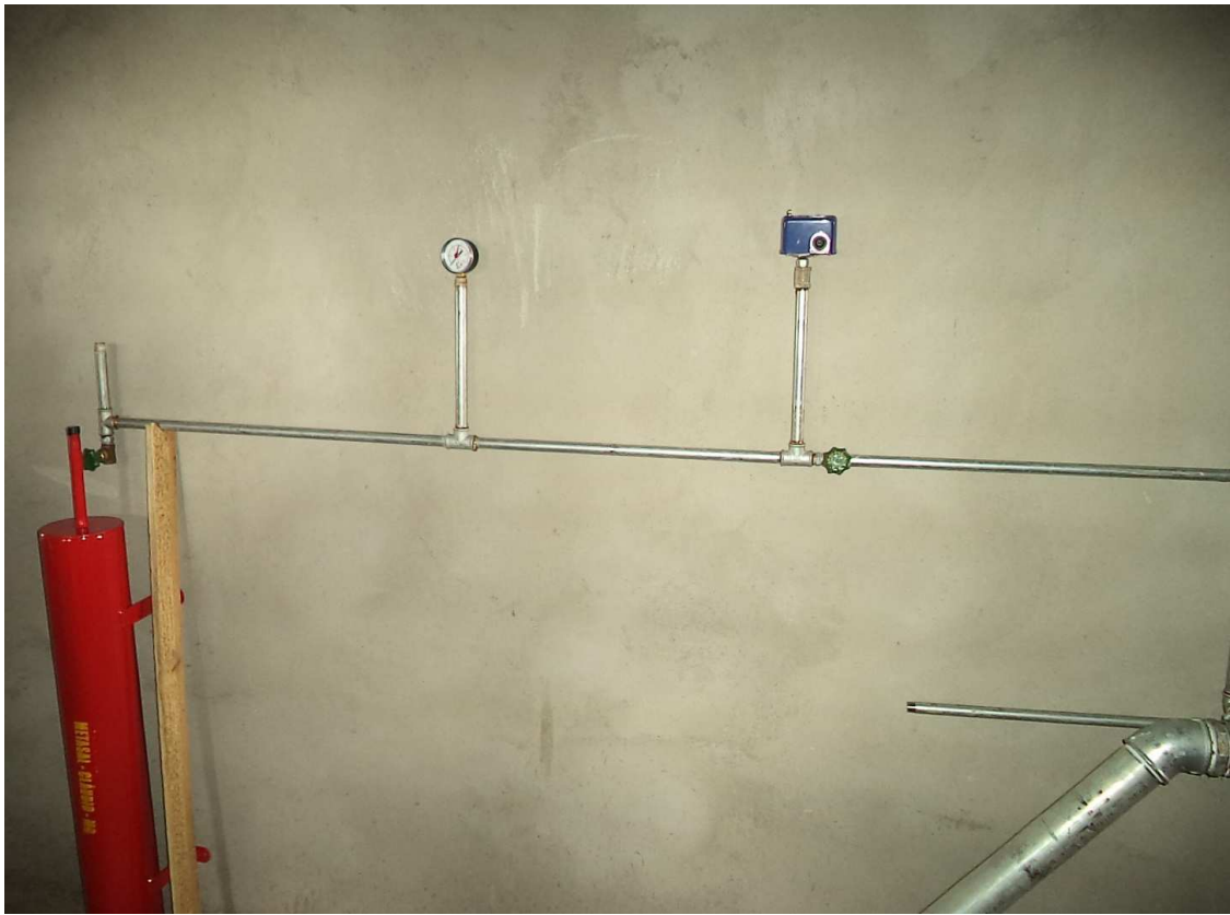
INSTALAÇÕES DE COMBATE A INCÊNDIO DATA: NOVEMBRO/2016
