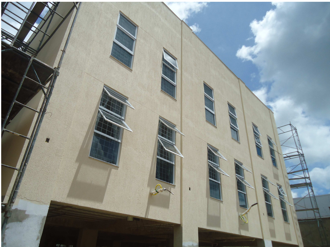
TEXTURA E PINTURA EXTERNA, PEITORIS DATA: MARÇO/2017
