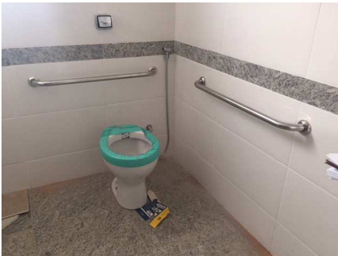
BARRAS AÇO INOX PARA SANITÁRIOS PNE DATA: JULHO/2017
