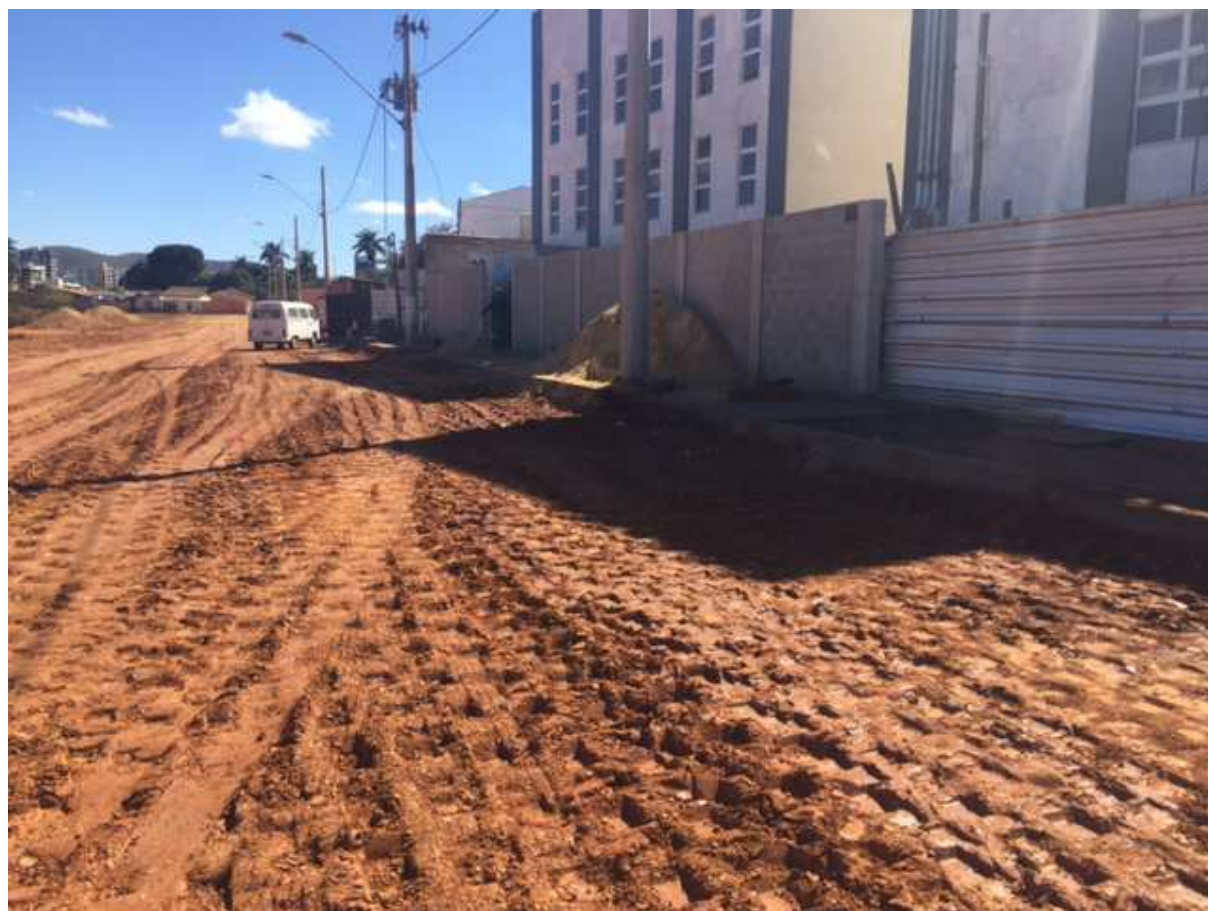
PASSEIO EXTERNO E COMPACTAÇÃO RUA LATERAL
