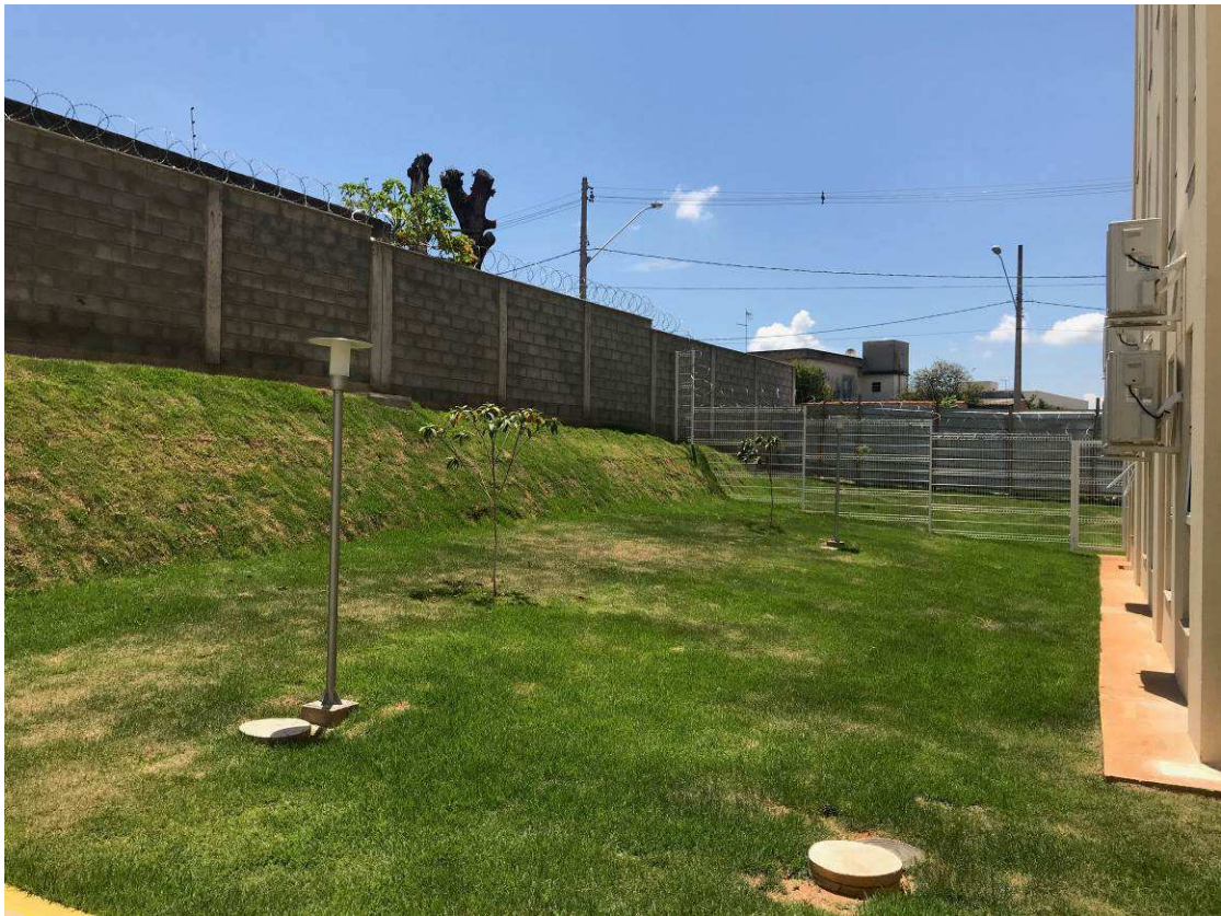
ILUMINAÇÃO EXTERNA, PAISAGISMO, MURO, GRADIL DATA: DEZEMBRO/2017
