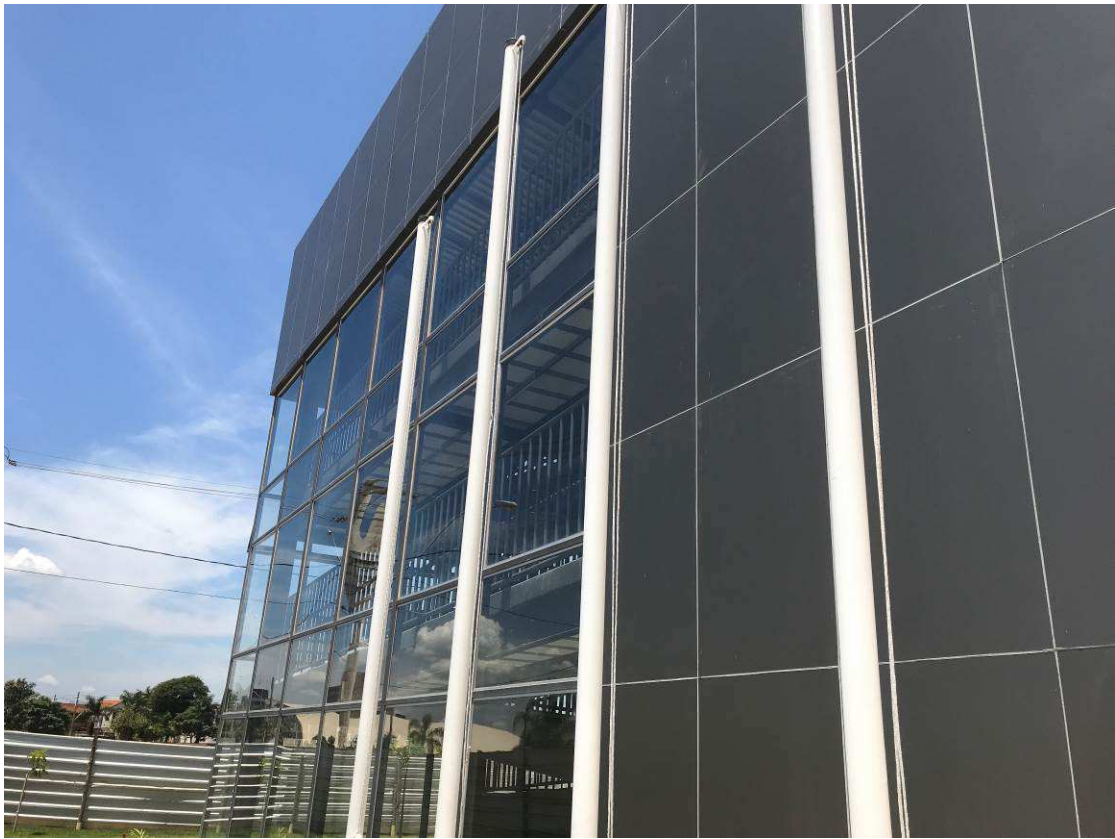
FACHADA FRONTAL EM VIDRO E ALUCOBOND DATA: DEZEMBRO/2017
