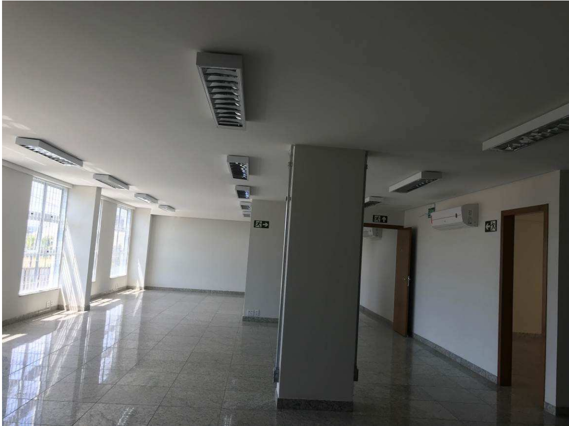
SECRETARIA DA VARA, LUMINÁRIAS E SINALIZAÇÃO DE PCI DATA: DEZEMBRO/2017
