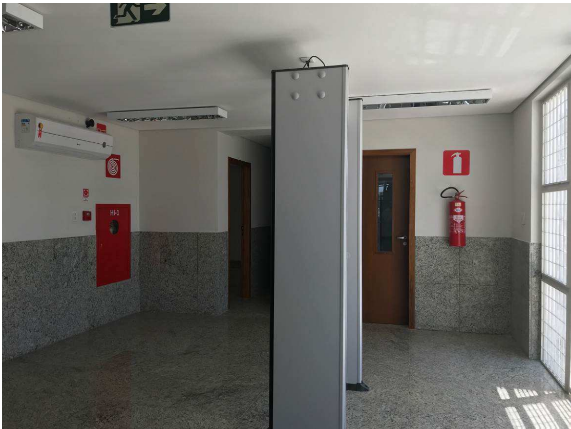
HALL DE ENTRADA, AR CONDICIONADO, PREVENÇÃO E COMBATE A INCÊNDIO DATA: DEZEMBRO/2017
