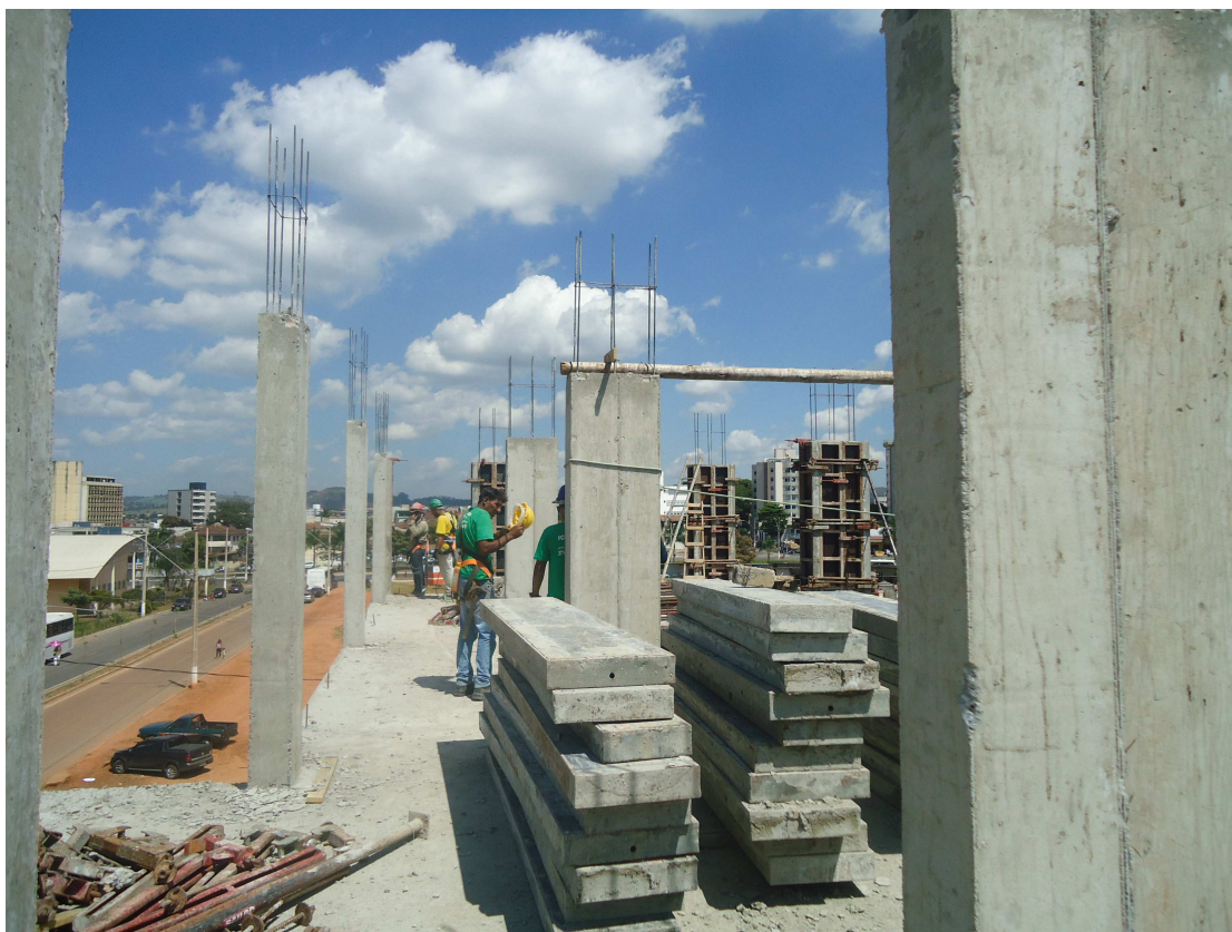
PILARES CAIXA D'ÁGUA DATA: ABRIL/2016
