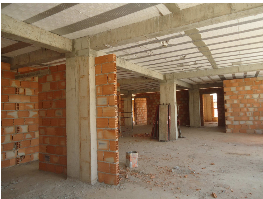
ESTRUTURA E ALVENARIA DATA: ABRIL/2016
