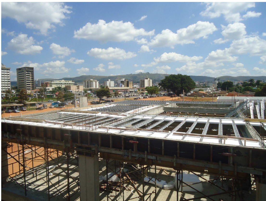
LAJE 3º PAVIMENTO A CONCRETAR E ANDAIMES DATA: ABRIL/2016
