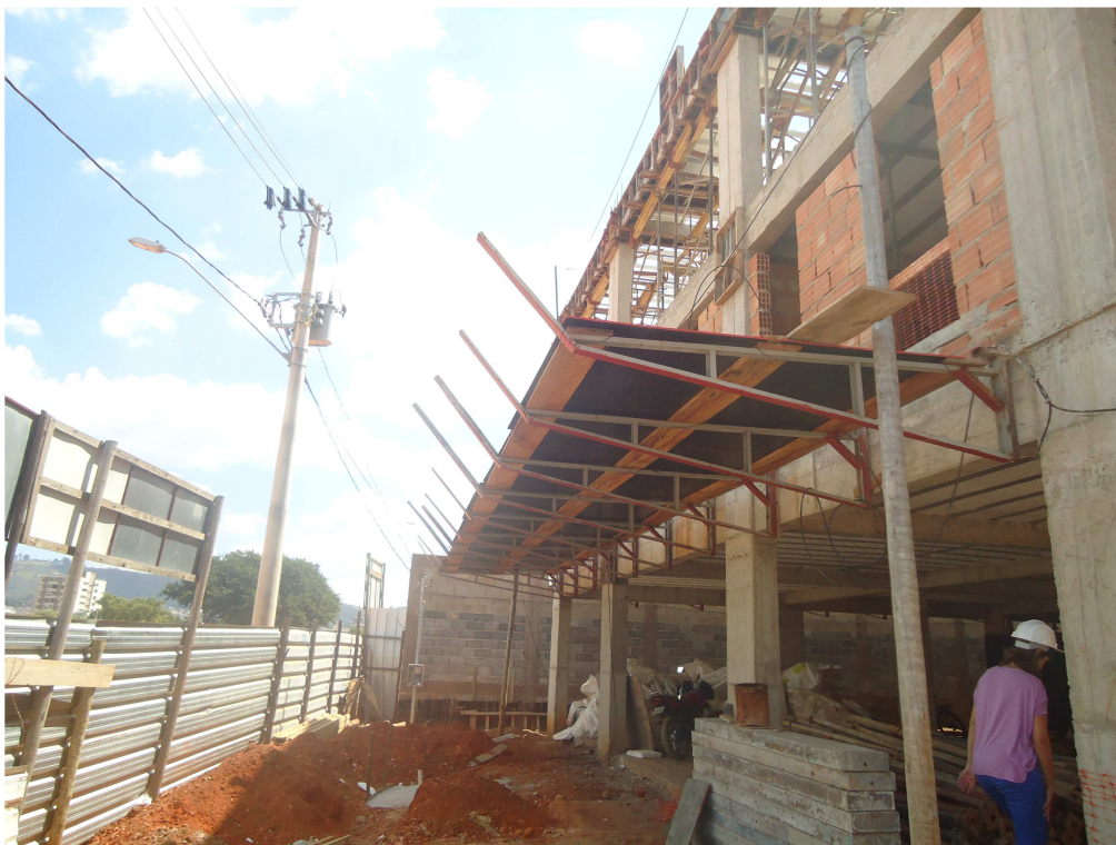
ESTRUTURA, ALVENARIA E BANDEJA DATA: ABRIL/2016
