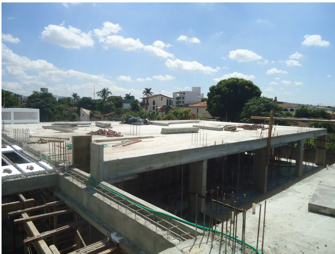
LAJE 3º PAVIMENTO DATA: ABRIL/2016
