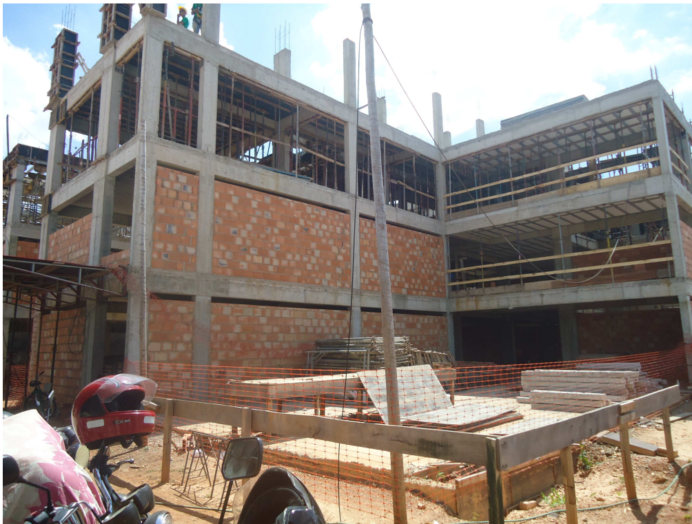
ESTRUTURA E ALVENARIA DATA: ABRIL/2016
