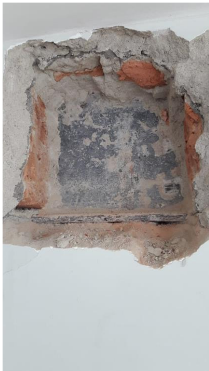
perfil metálico embutido em parede
