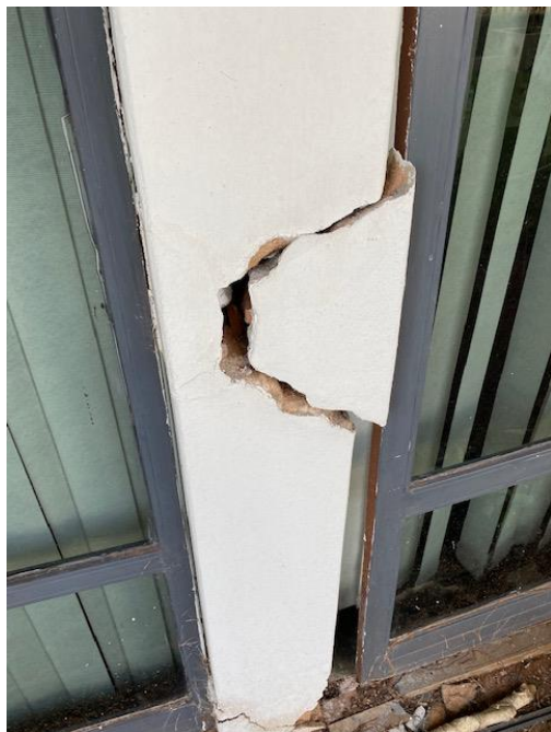
deslocamento de esquadria e alvenaria
