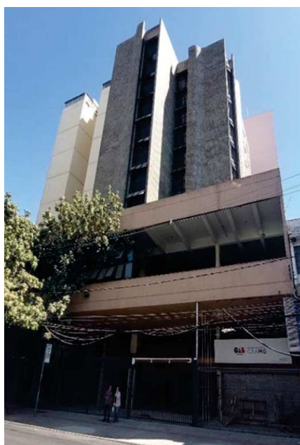
Imagem 02: Fachada do imóvel ofertado
