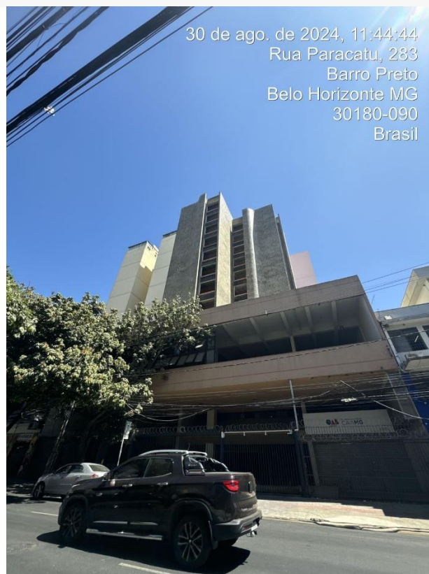
Imagem 4: Vista frontal do imóvel
