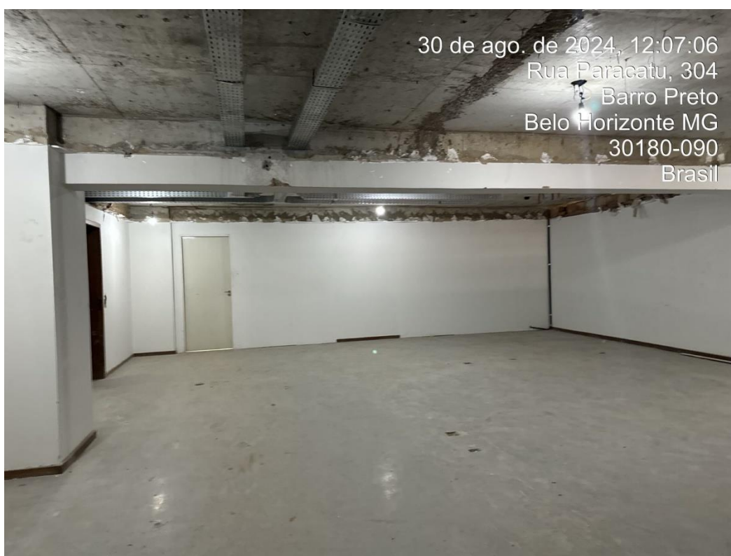
Imagem 15: Terceira vista do primeiro pavimento
