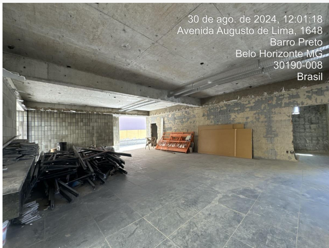
Imagem 22: Segunda vista do quarto pavimento
