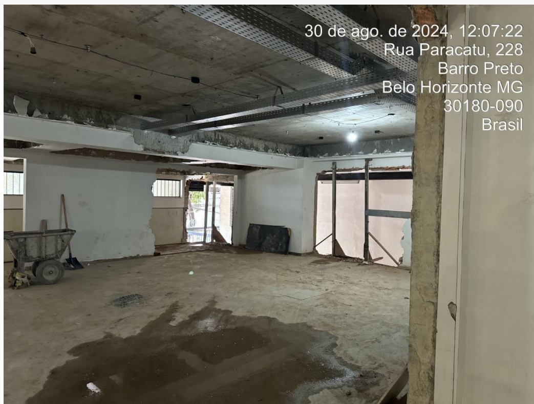
Imagem 14: Segunda vista do primeiro pavimento
