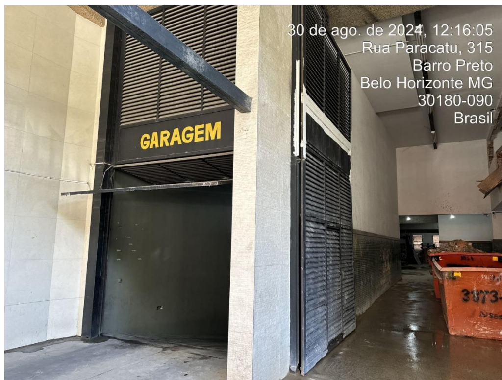
Imagem 5: Vista do acesso da garagem do imóvel
