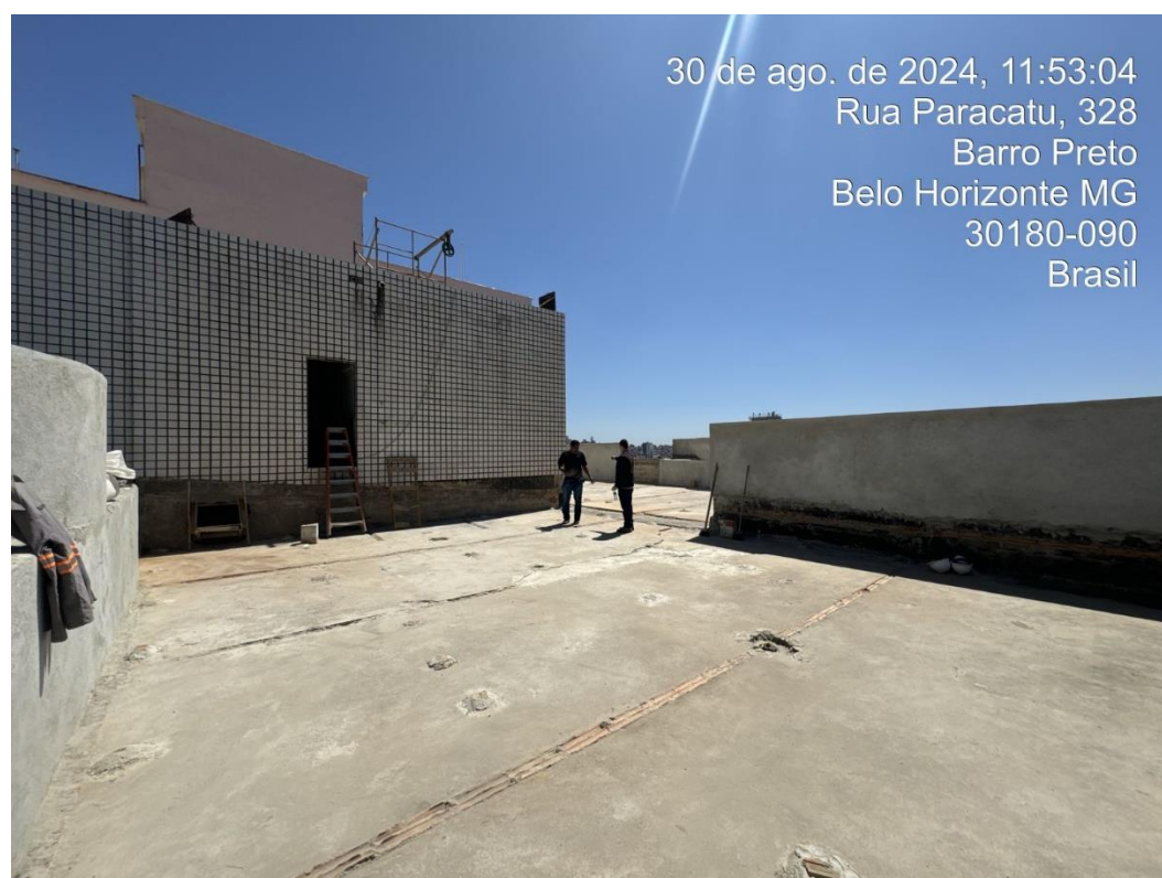
Imagem 45: Segunda vista da cobertura do imóvel
