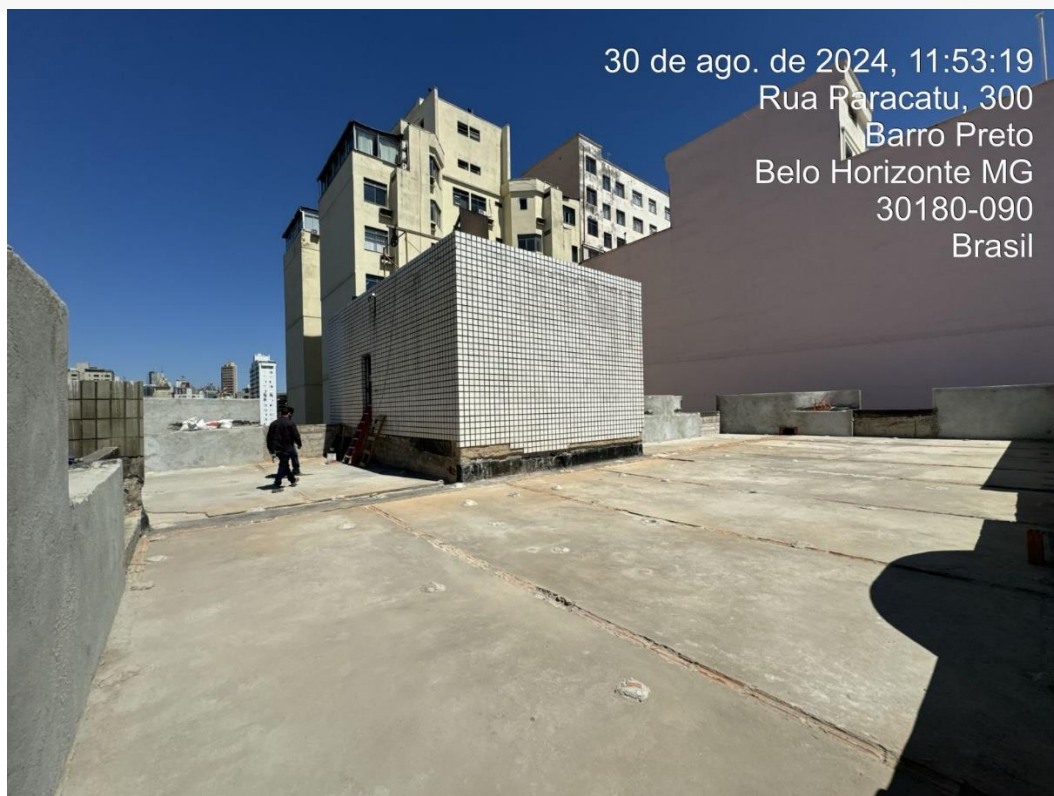
Imagem 44: Primeira vista da cobertura do imóvel
