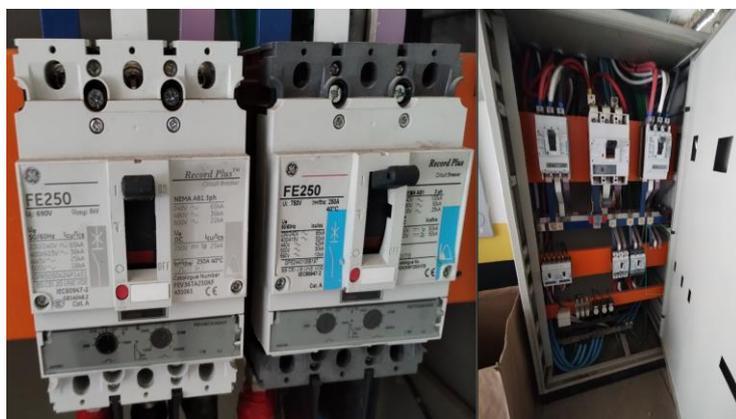
Figura 7: Disjuntor de caixa moldada.
