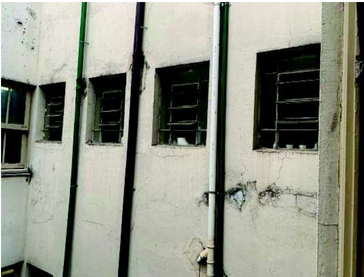
Fachada interna nº3 – lado banheiros/elevador (janelas tipo basculantes das ISS)
