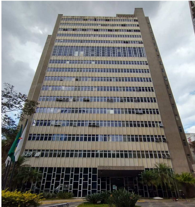
Vista da fachada Edifício-sede
