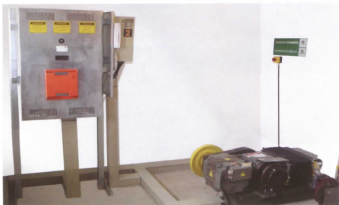
Casa de máquina com a nova máquina de tração SGB 142 e comando BX.
