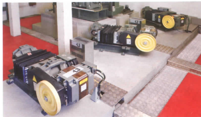
Casa de máquina com a nova máquina de tração SGB 142
