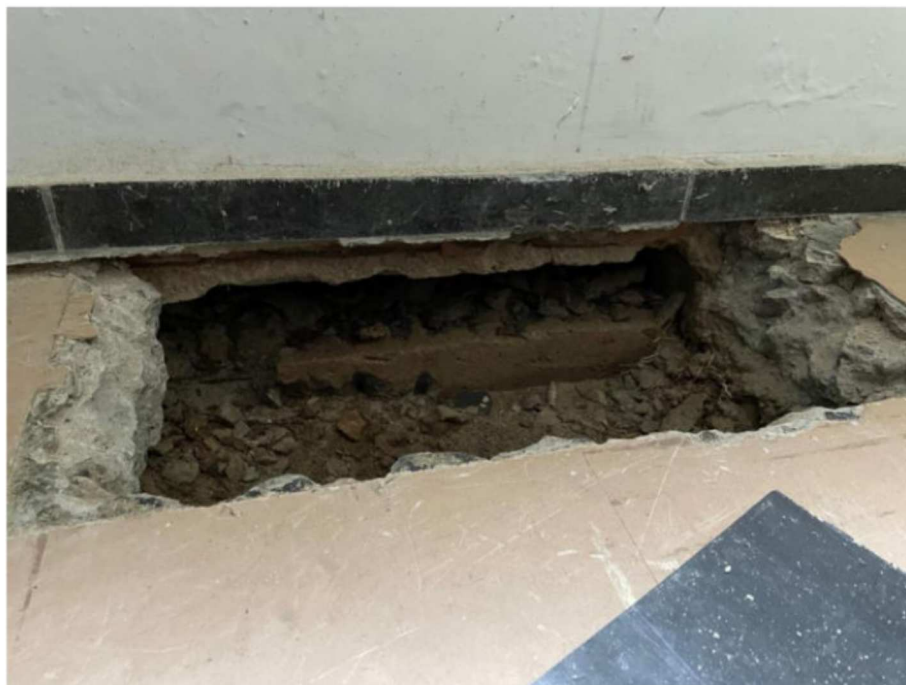
Foto 31: Inspeção do cinto executado, aparentemente não engastado nas fundações da edificação.
