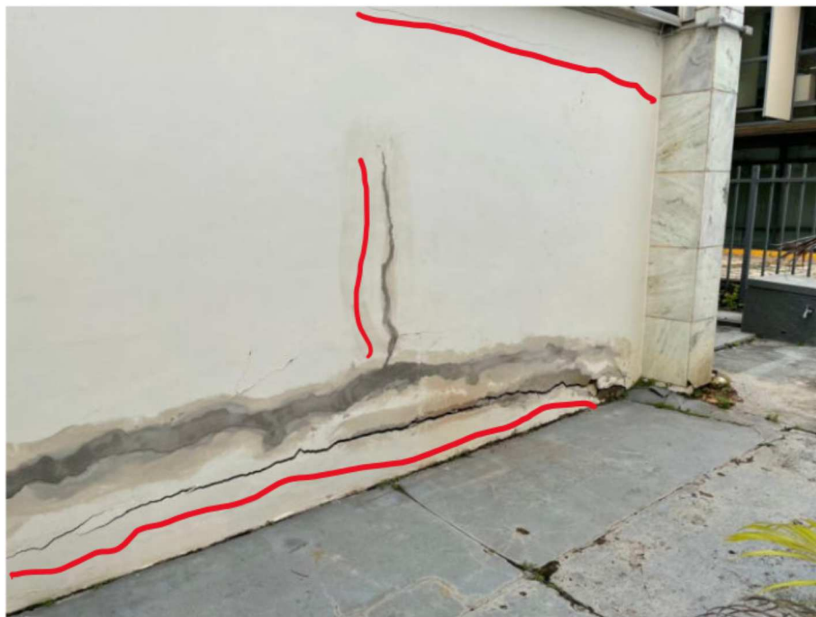
Foto 33: Fissura em alvenaria por recalque do piso térreo
