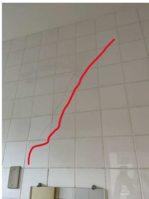
Foto 2: Fissura em alvenaria próxima à fachada possivelmente provocada por movimentação térmica e infiltração.
