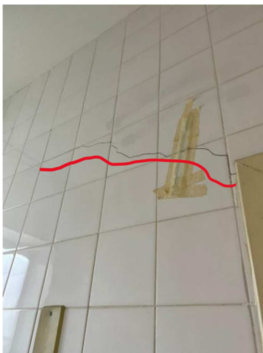
Foto 10: Fissura em alvenaria. Indício de inexistência de vergas.
