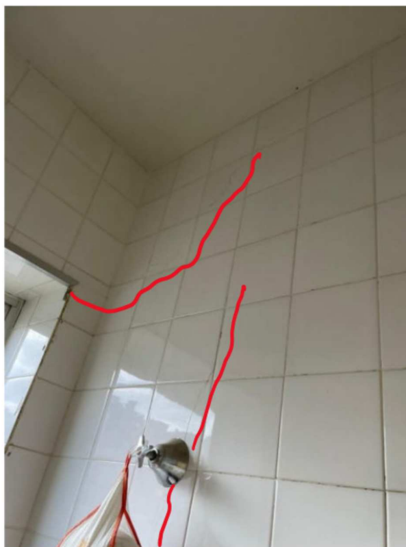
Foto 4: Fissura em alvenaria próxima à tubulação de água.
