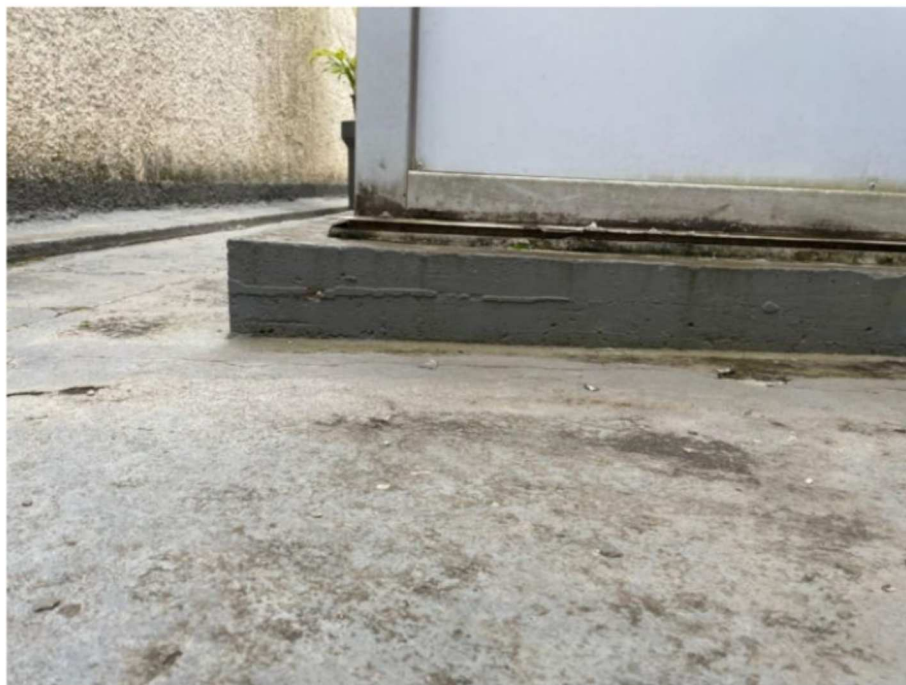
Foto 25: Base do elevador. Fissuras causadas pelo abatimento do piso externo.
