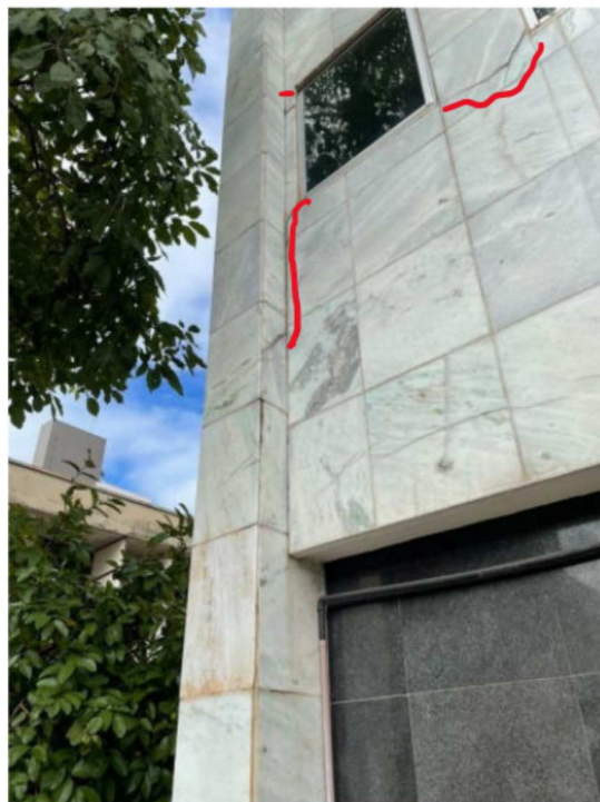
Foto 23: Fissura em alvenaria por recalque do piso térreo
