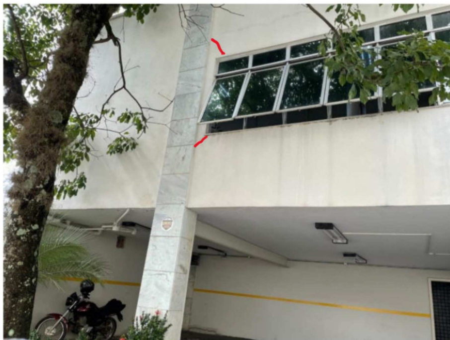
Foto 22: Vista lateral da estrutura, e reforço em viga metálica da laje do primeiro pavimento.
