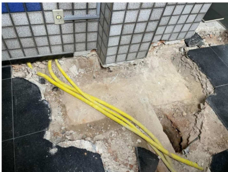
Foto 32: Inspeção da fundação existente.
