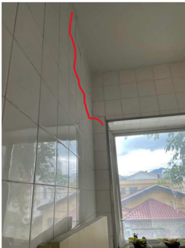
Foto 6: Fissura em alvenaria. Indício de inexistência de vergas e contravergas.
