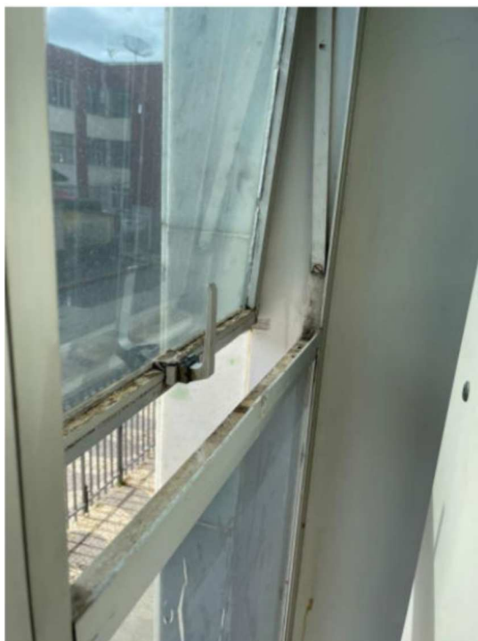
Foto 16: Vidro quebrado na fachada possivelmente provocado por movimentação térmica ou impacto mecânico.
