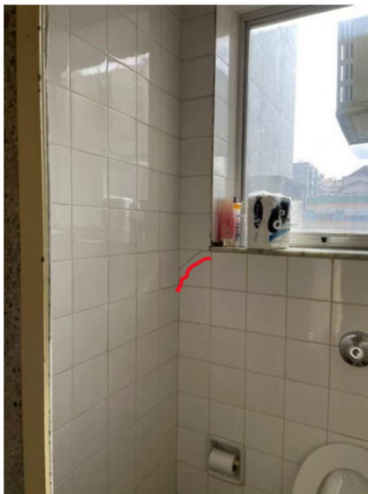
Foto 11: Fissura em alvenaria. Indício de inexistência de vergas.
