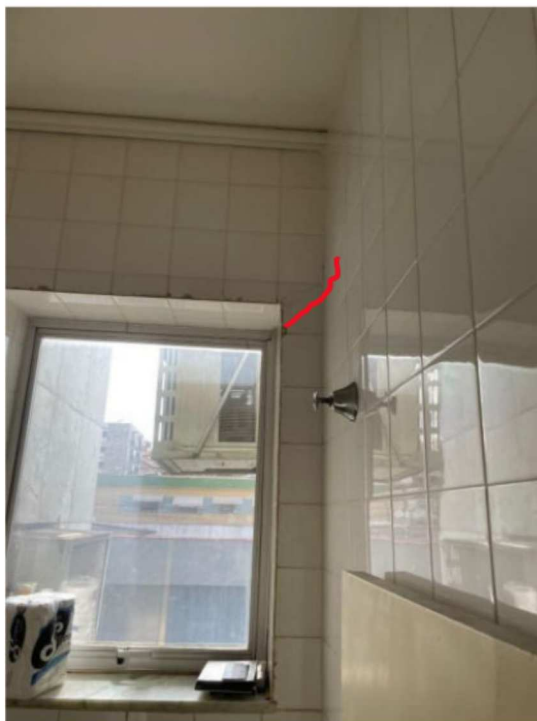
Foto 9: Fissura em alvenaria. Indício de inexistência de vergas.
