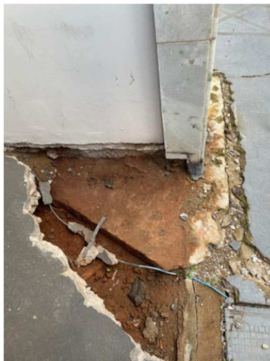
Foto 38: Inspeção da fundação existente.
