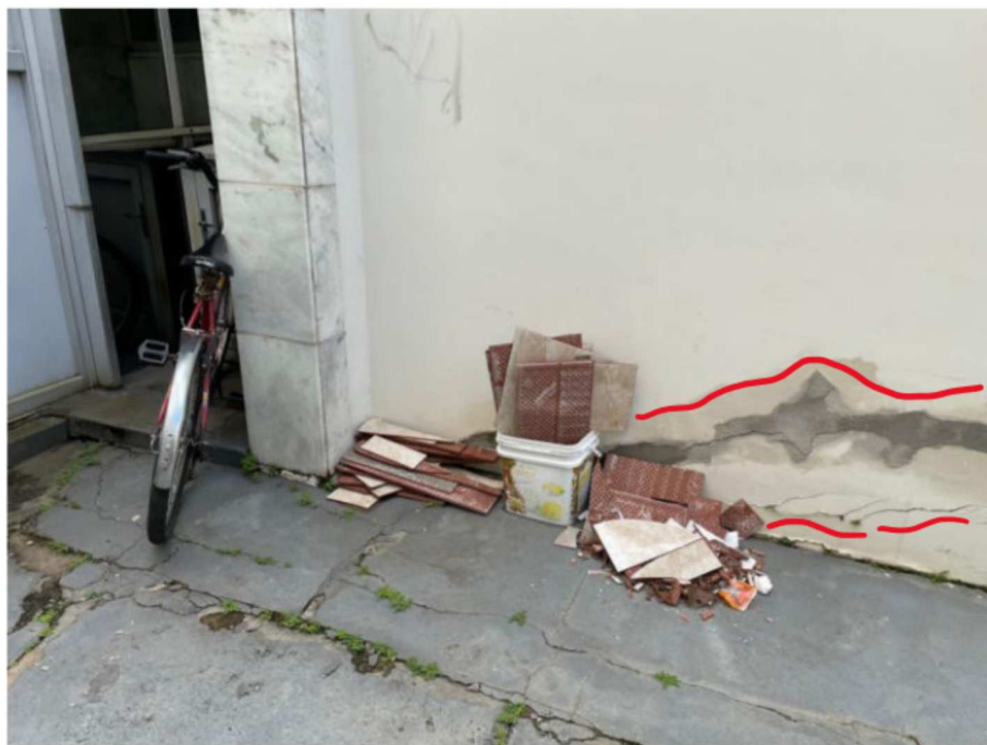
Foto 30: Fissura em alvenaria por recalque do piso térreo
