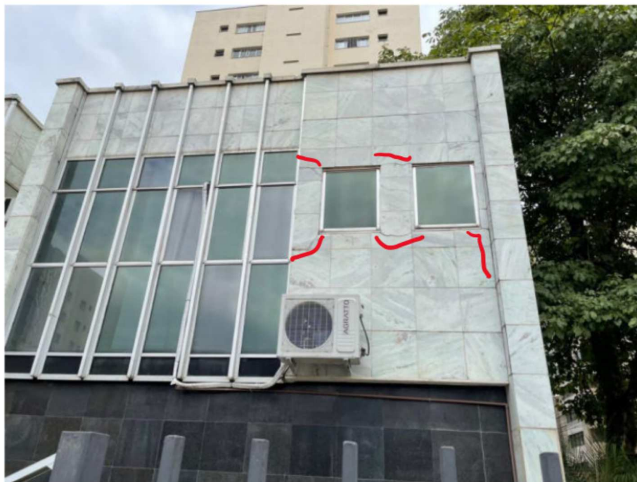
Foto 35: Fissura em alvenaria. Indício de inexistência de vergas.
