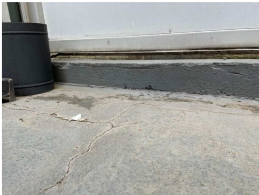
Foto 26: Base do elevador. Fissuras causadas pelo abatimento do piso externo.
