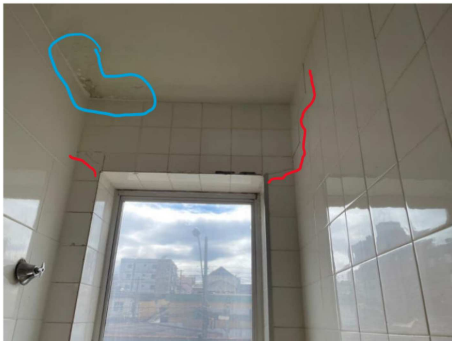
Foto 13: Fissura em alvenaria. Indício de inexistência de vergas.
