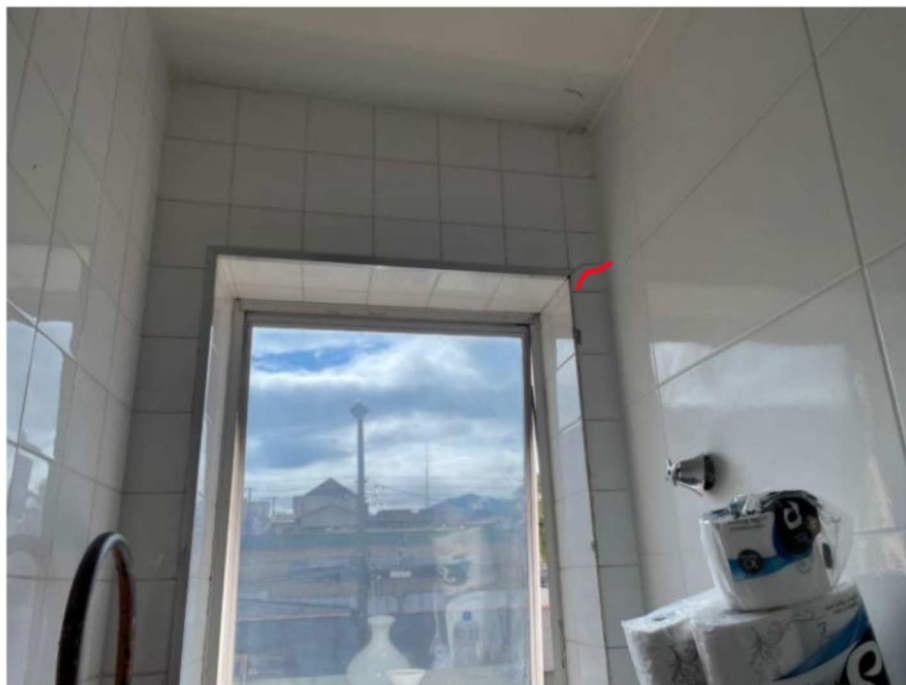
Foto 15: Fissura em alvenaria. Indício de inexistência de vergas.
