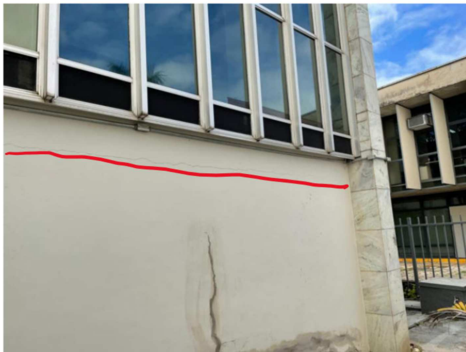
Foto 29: Fissura em alvenaria por recalque do piso térreo
