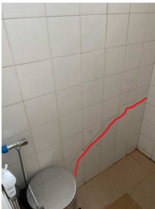
Foto 12: Fissura em alvenaria possivelmente provocada por deformação da laje.
