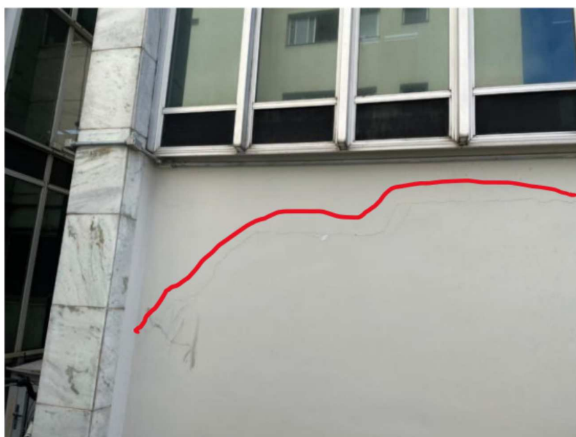
Foto 28: Fissura em alvenaria por recalque do piso térreo
