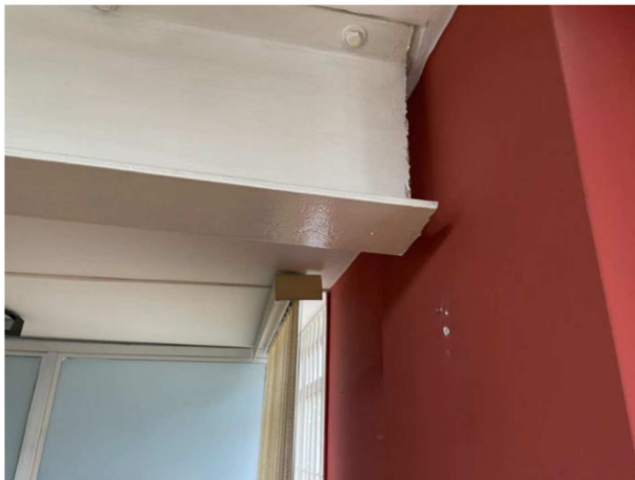
Foto 21: Reforço em viga metálica da laje do primeiro pavimento.
