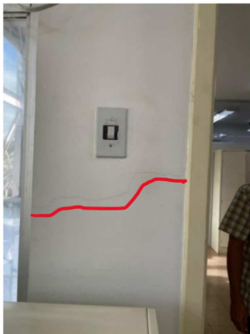
Foto 1: Fissura em alvenaria próxima à fachada possivelmente provocada por movimentação térmica.
