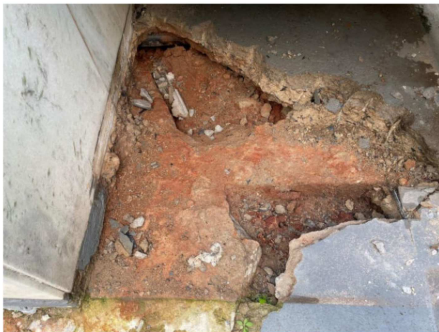
Foto 34: Inspeção da fundação existente.
