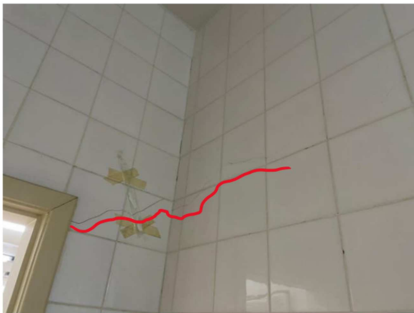
Foto 8: Fissura em alvenaria. Indício de inexistência de vergas.
