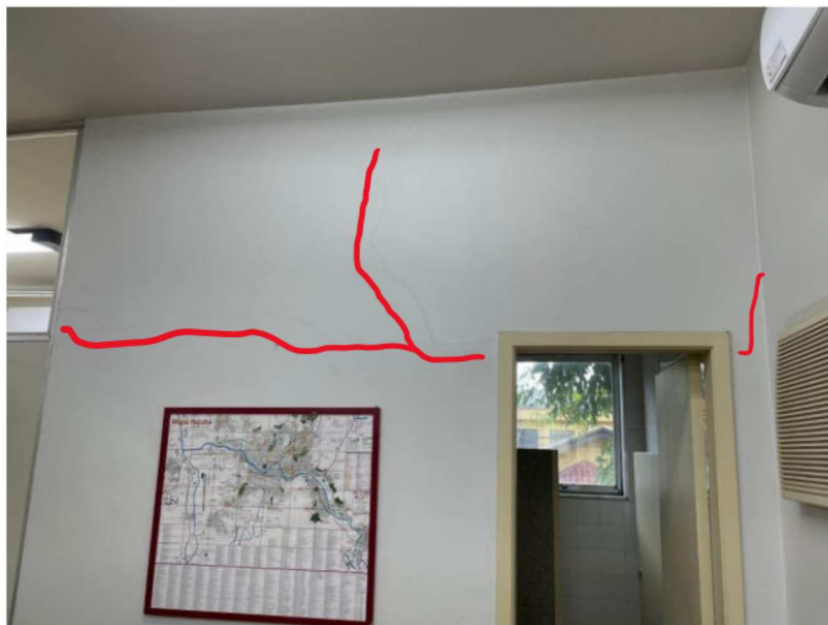
Foto 5: Fissura em alvenaria. Indício de inexistência de vergas.
