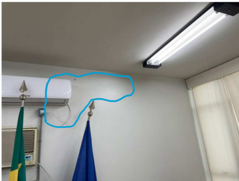
Foto 7: Indícios de infiltração proveniente da cobertura.
