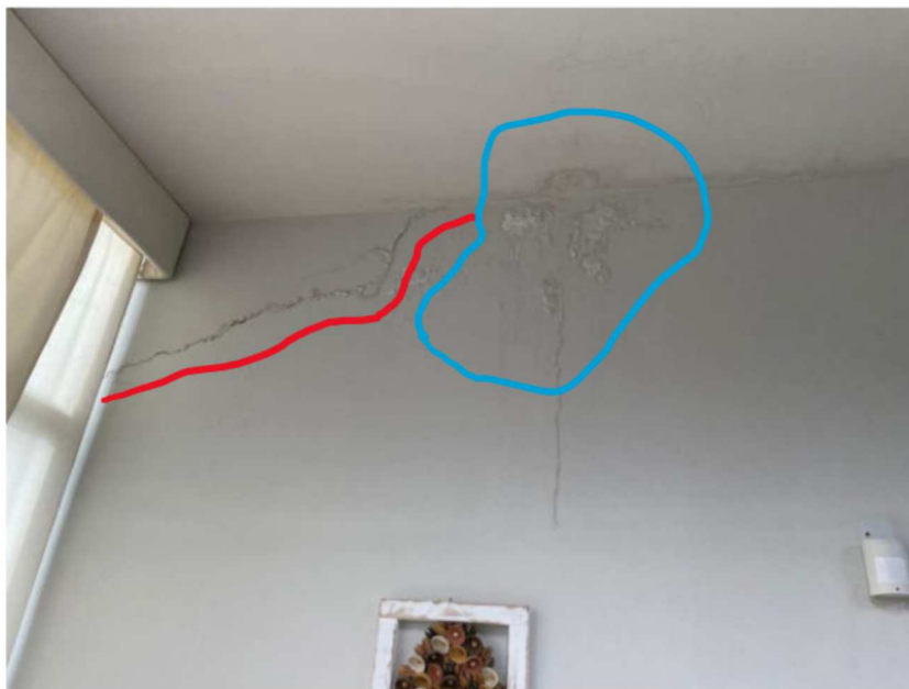
Foto 3: Fissura em alvenaria próxima à fachada possivelmente provocada por movimentação térmica e infiltração.
