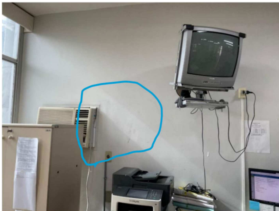
Foto 14: Infiltração proveniente da abertura para ar-condicionado.
