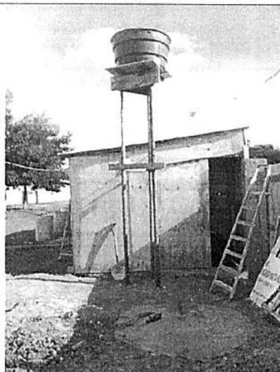
Instalações provisórias de água/esgoto inclusive reservatório
