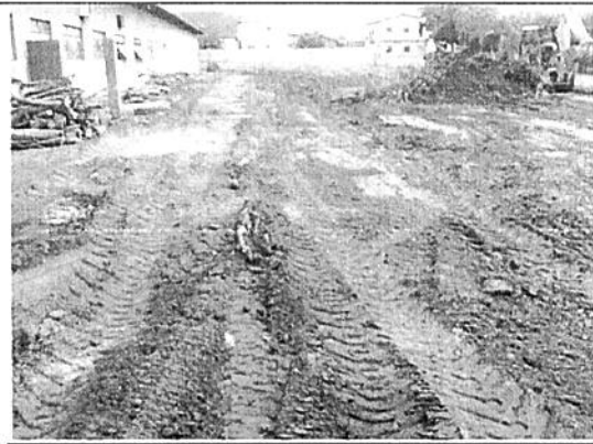
Limpeza do terreno
