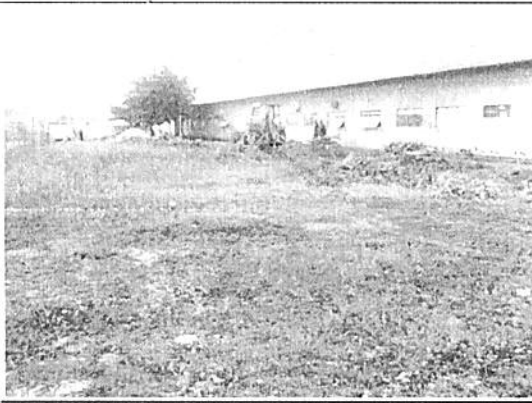
Limpeza do terreno - mobilização
