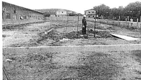
Locação da obra
