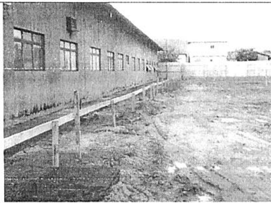
Locação da obra
