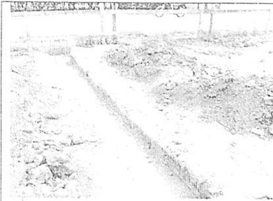
Infraestrutura e Obras Complementares – cintas e blocos de fundação - lastro de concreto
