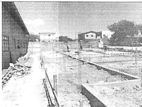
Infraestrutura e Obras Complementares – cintas e blocos de fundação – finalização do concreto das vigas e blocos de fundação
