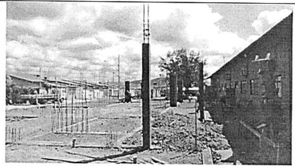
Estrutura – Pilares da Estrutura
