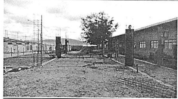
Estrutura – Pilares da Estrutura
