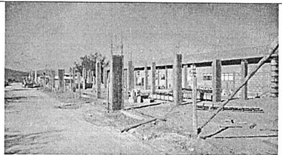
Estrutura – Pilares da Estrutura
