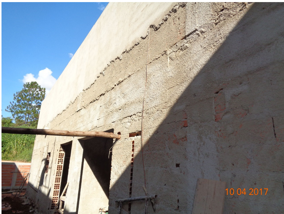
Chapisco e emboço - fachada frontal
