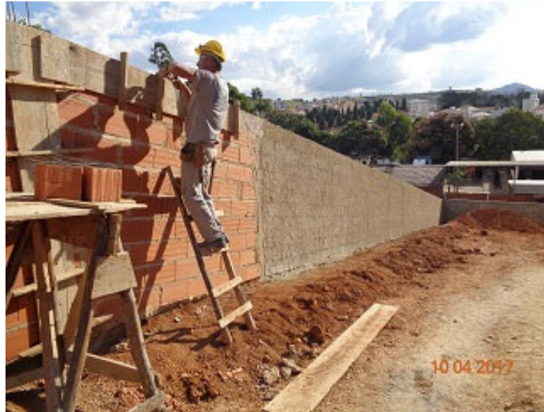
Muros dos fundos
