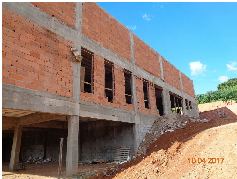
Vista da fachada dos fundos da obra
