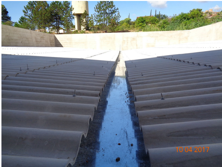
Vista parcial da cobertura
