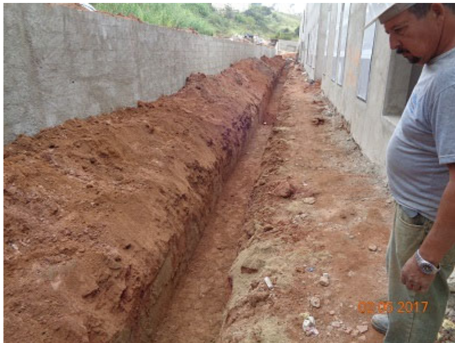
Execução da rede externa - pluvial/ esgoto
