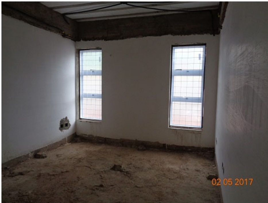
Colocação de janelas em gabinetes
