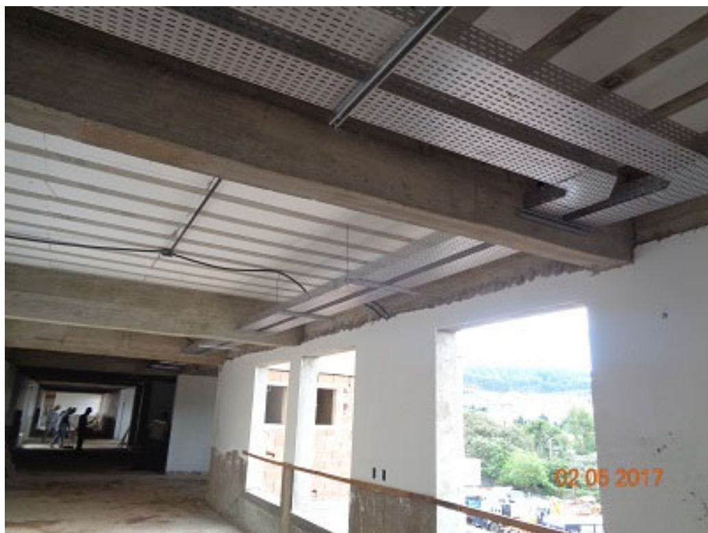
Instalação de eletro- calhas da rede elétrica
