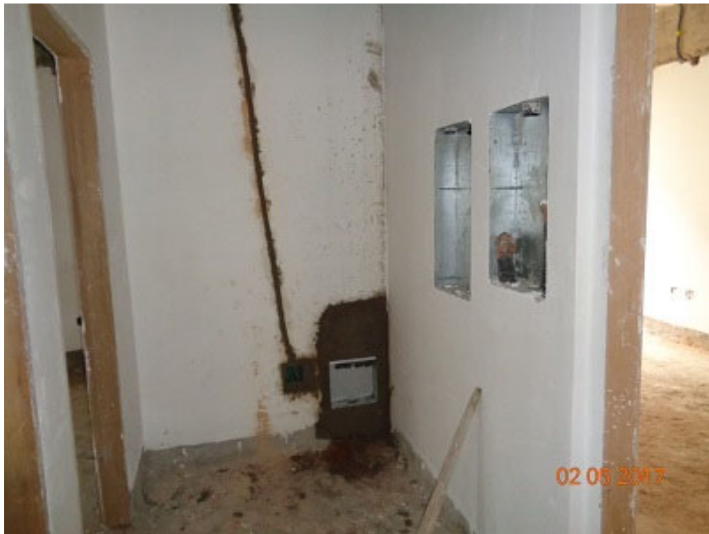
Instalação de caixas e quadros da rede elétrica
