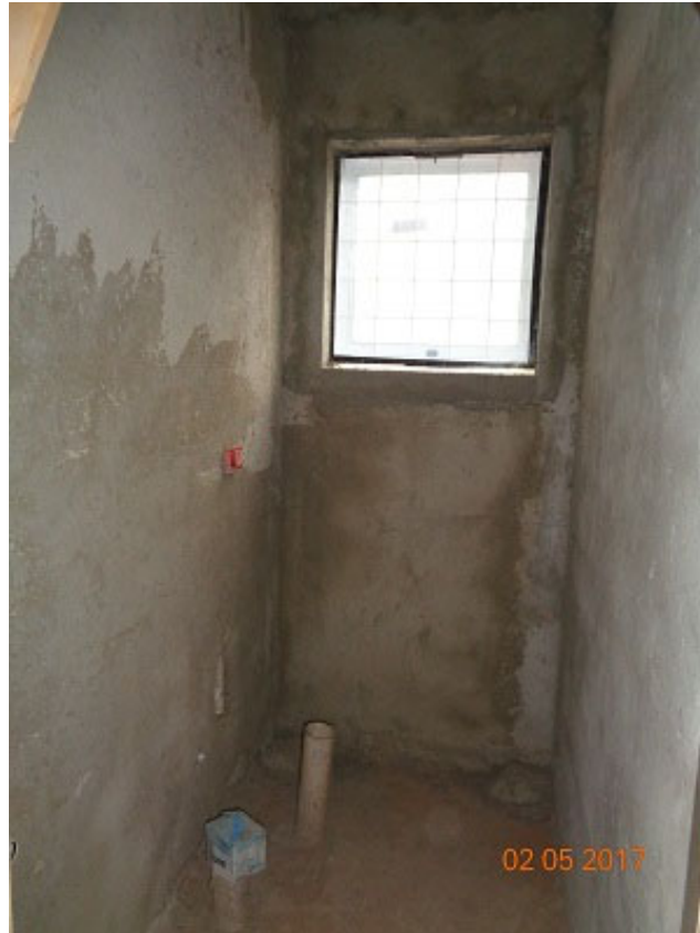
Colocação de janelas de banheiros
