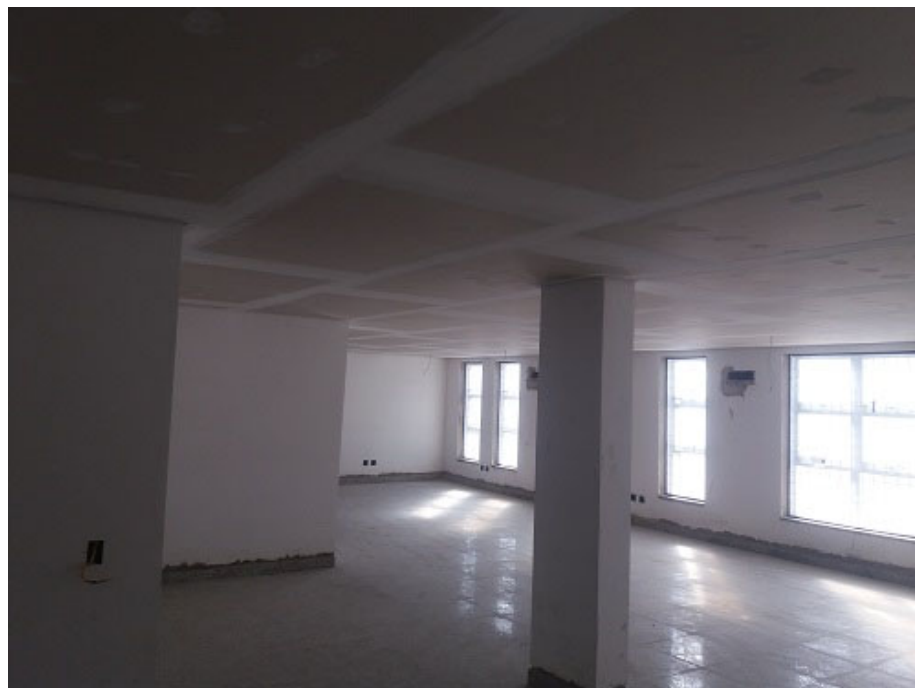
Forro de gesso, pavimentação, rodapés
