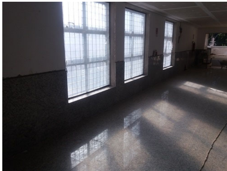
Pavimentação e instalação de esquadrias metálicas
