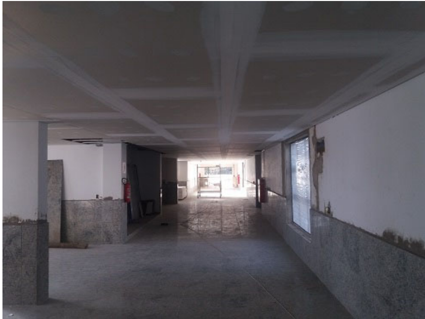
Forro de gesso e revestimento interno
