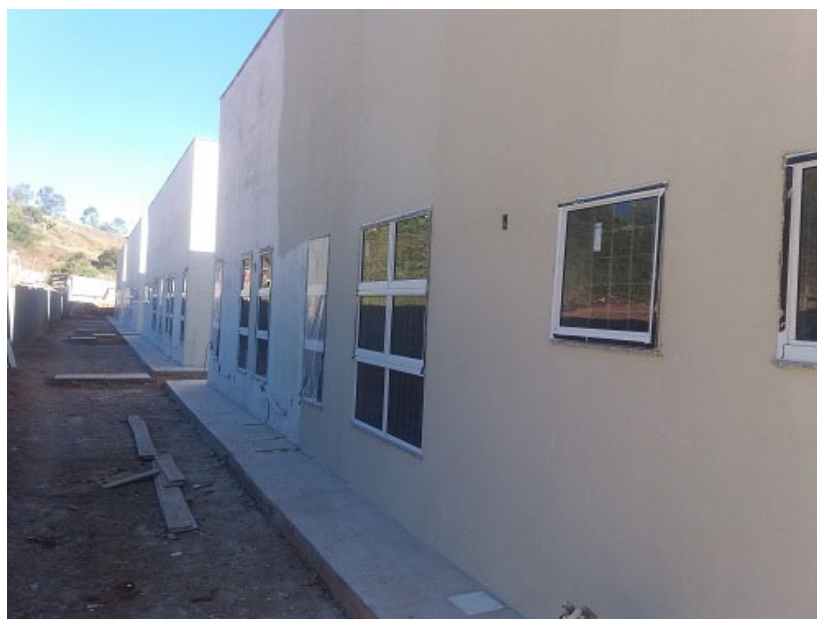
Revestimento externo e instalação de esquadrias metálicas
