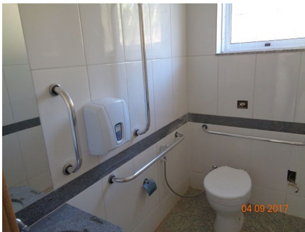
Limpeza da obra, instalações hidráulicas
