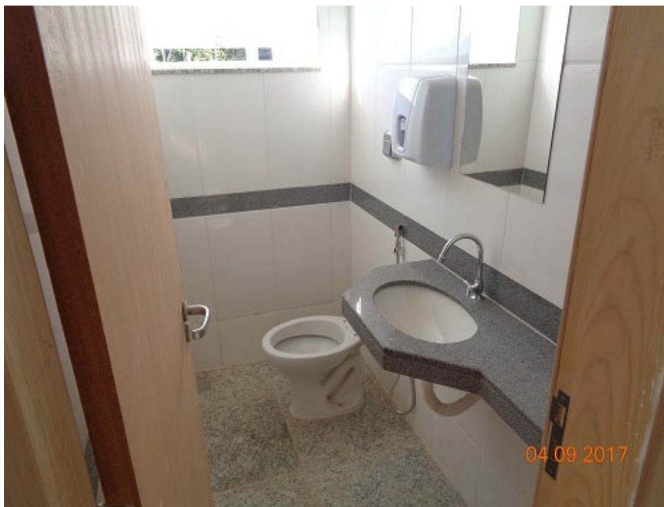
Instalações hidráulicas, esquadrias, limpeza de obra
