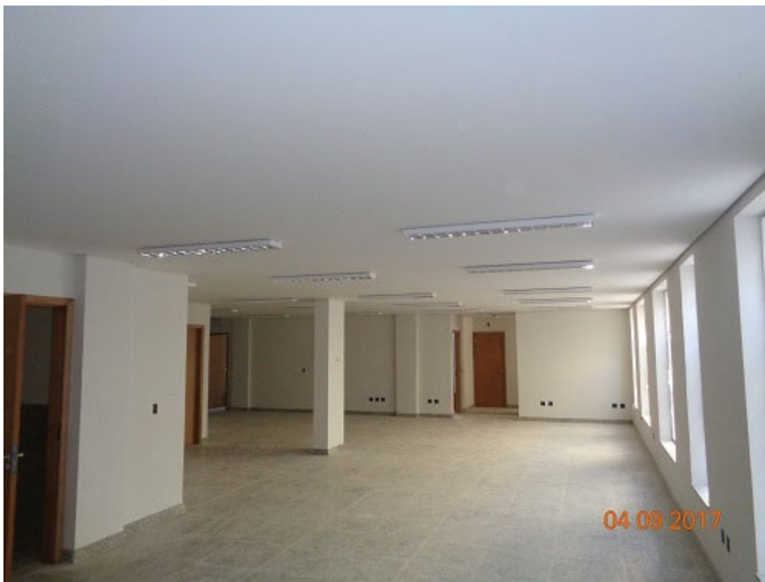
Pavimentação, forro de gesso, elétrica e SPDA
