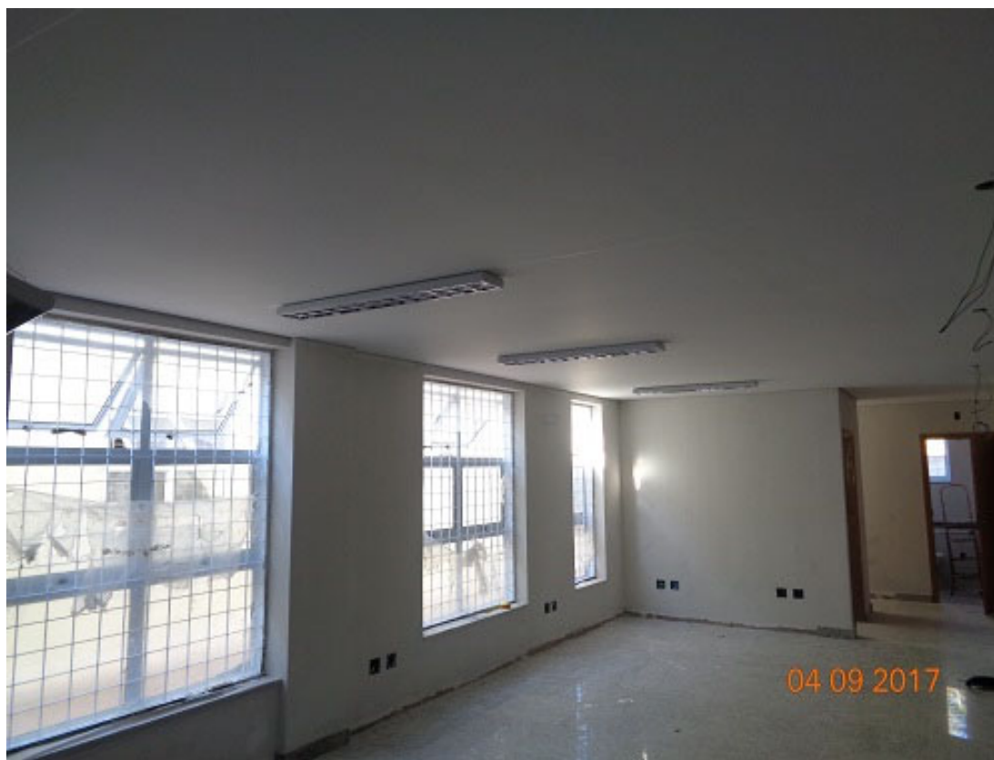
Forro de gesso, elétrica e SPDA, pavimentação
