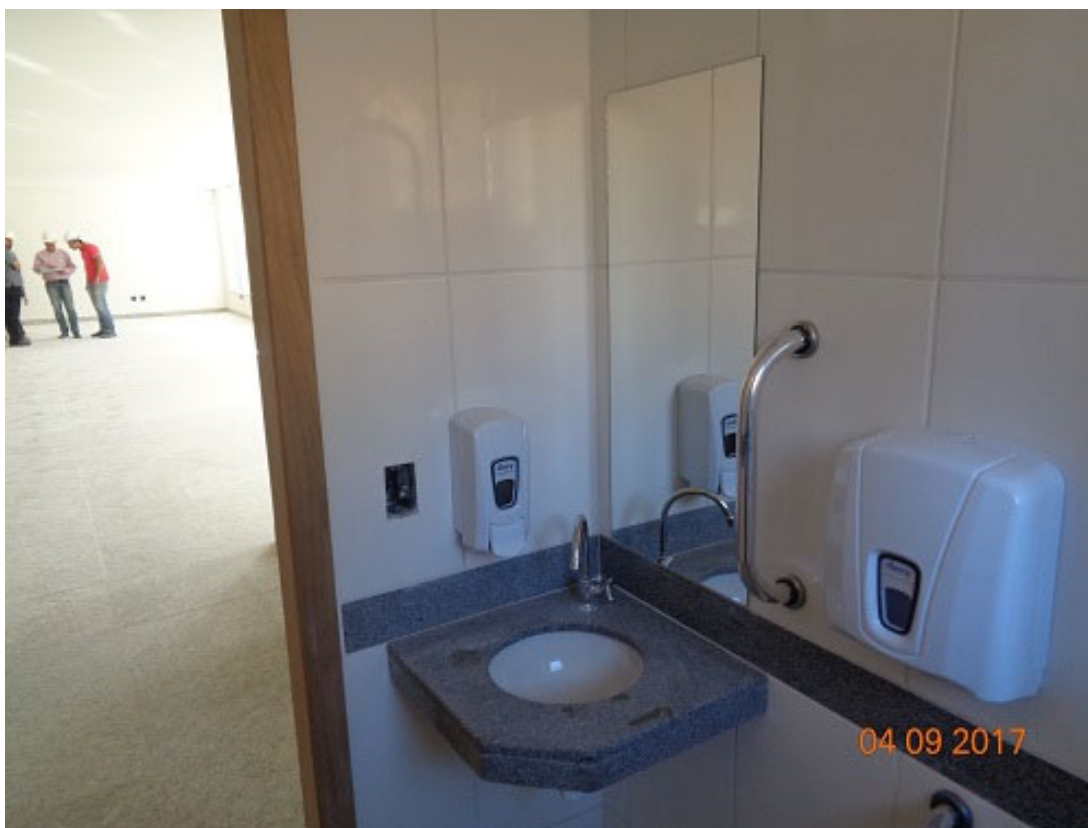
Espelhos, instalações hidráulicas
