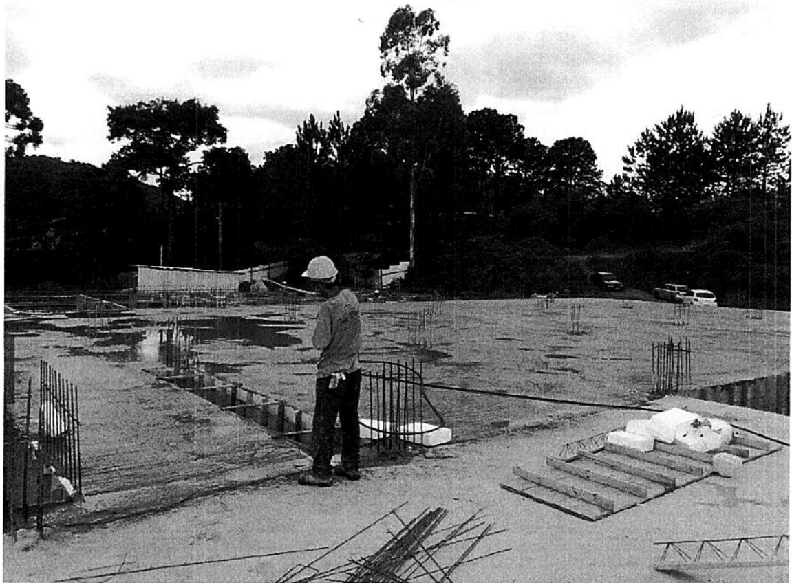
CONCRETAGEM LAJE 2º PAVO
