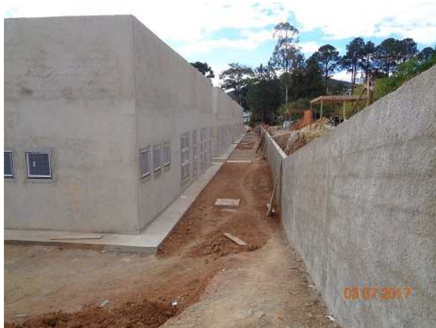
Vista da fachada lateral esquerda
