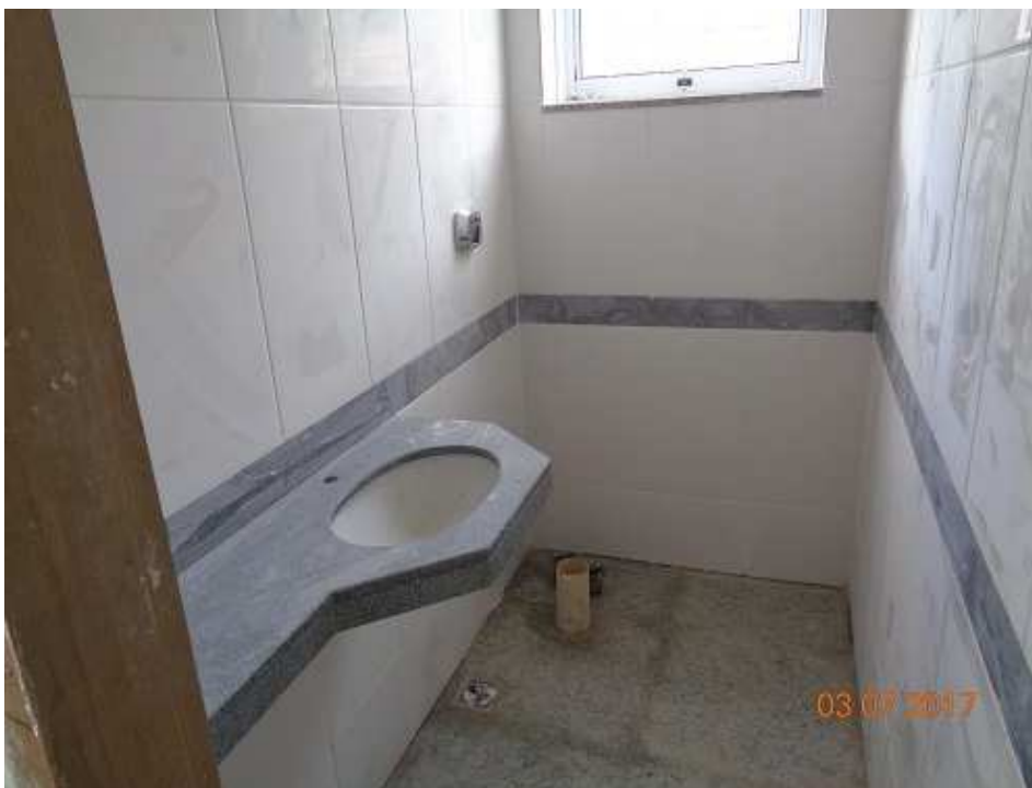
Instalação de bancadas, louças e metais
