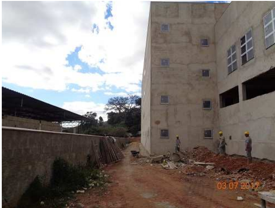
Vista da fachada lateral direita
