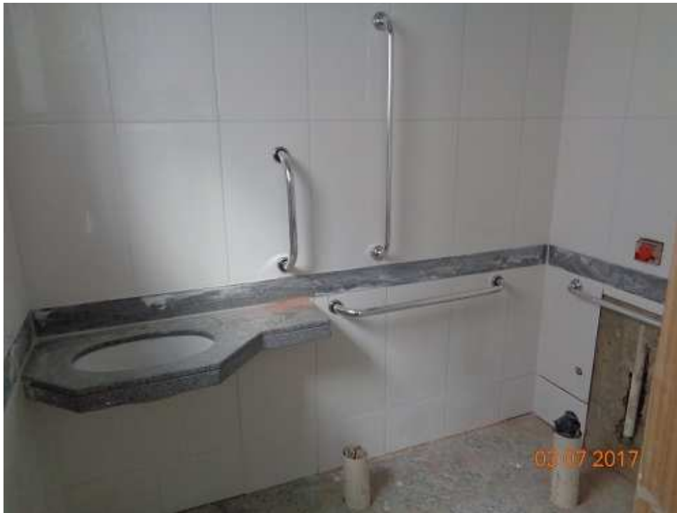
Instalação de bancadas, louças e metais
