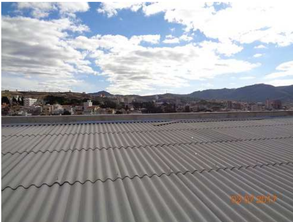
Vista do último nível da cobertura
