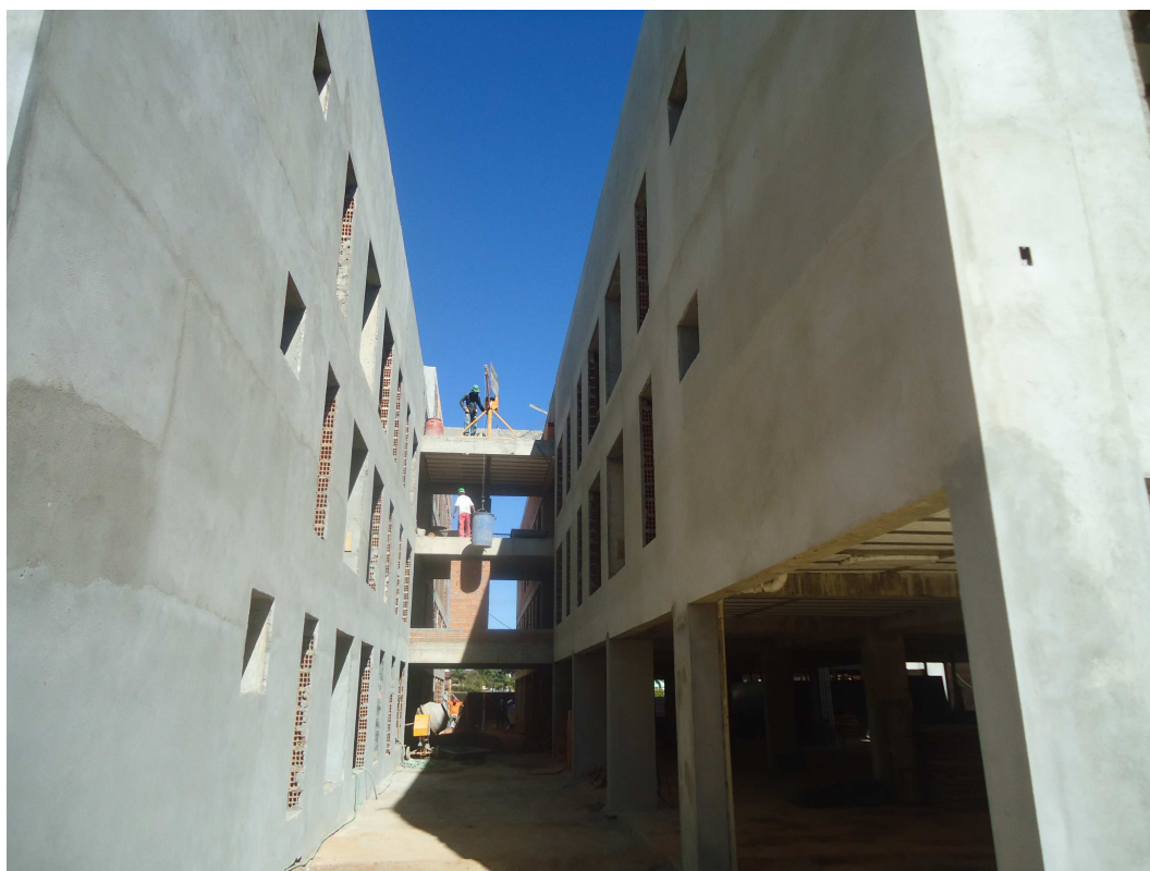
REVESTIMENTO EXTERNO DATA: JULHO/2016
