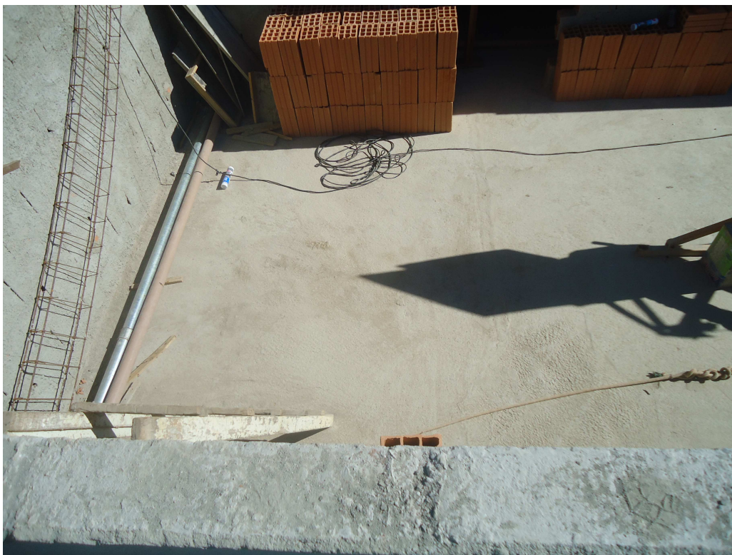
LAJE IMPERMEABILIZADA DATA: JULHO/2016
