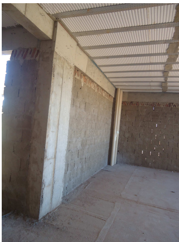
REVESTIMENTO INTERNO E INSTALAÇÕES HIDRÁULICAS DATA: JULHO/2016
