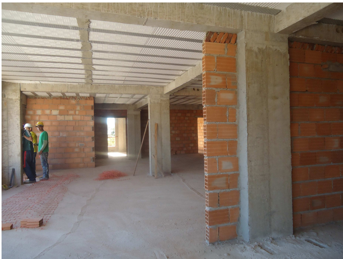
ALVENARIA INTERNA 3º PAVIMENTO DATA: JULHO/2016
