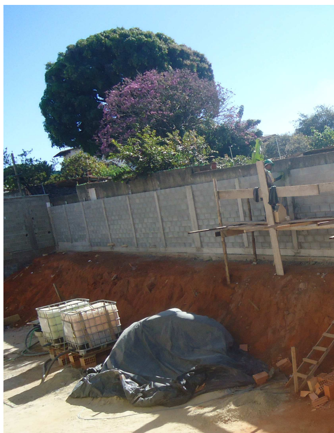
MURO DE DIVISA DATA: JULHO/2016
