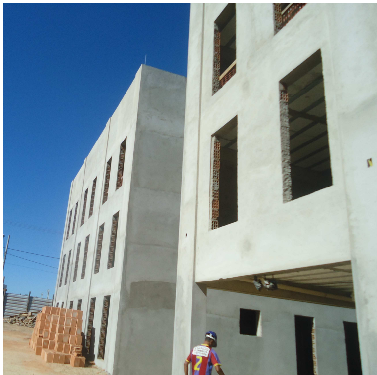
REVESTIMENTO EXTERNO DATA: JULHO/2016
