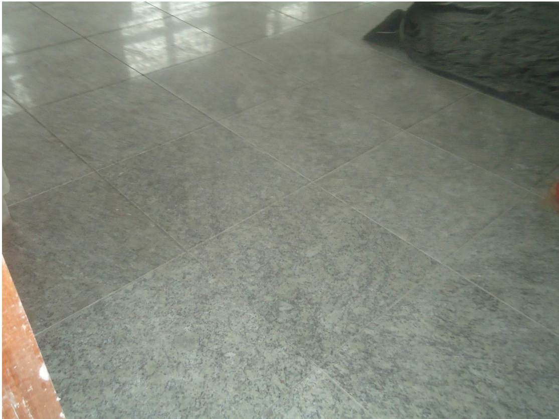
PISO EM GRANITO DATA: DEZEMBRO/2016
