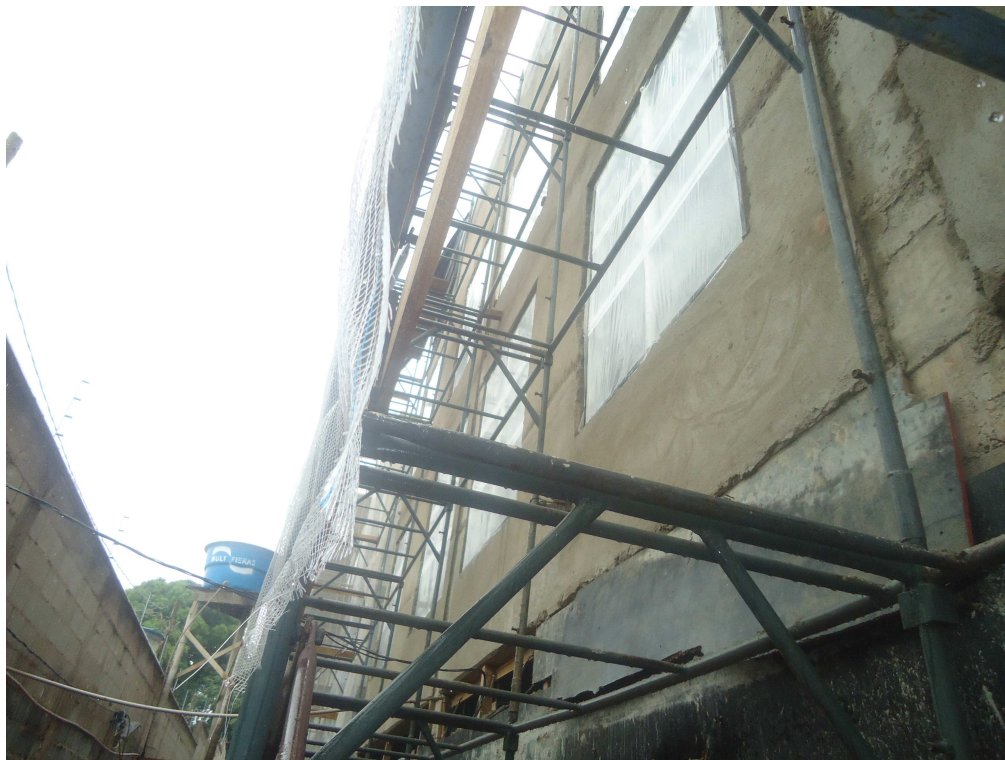
REVESTIMENTO EXTERNO, ANDAIMES, TELAS DATA: DEZEMBRO/2016
