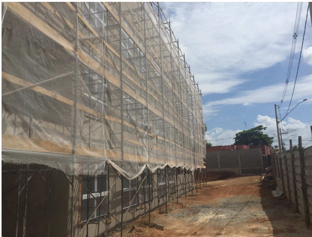
REVESTIMENTO EXTERNO, ANDAIMES, TELAS, ESQUADRIAS DATA: JANEIRO/2017
