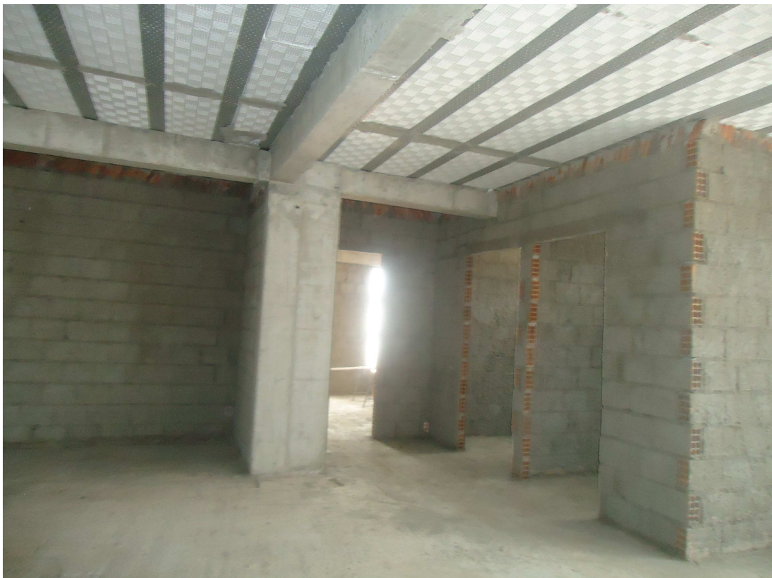
REVESTIMENTO INTERNO - 3º PAVIMENTO DATA: JANEIRO/2017
