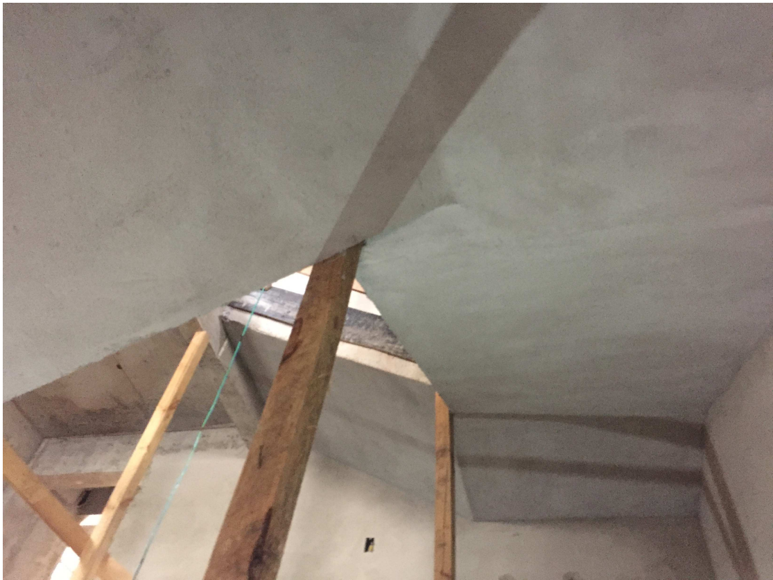
REVESTIMENTO INTERNO - TETO E HALL DA ESCADA DATA: JANEIRO/2017
