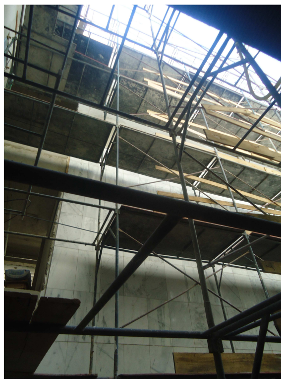
MÁRMORE, ANDAIMES DATA: JANEIRO/2017
