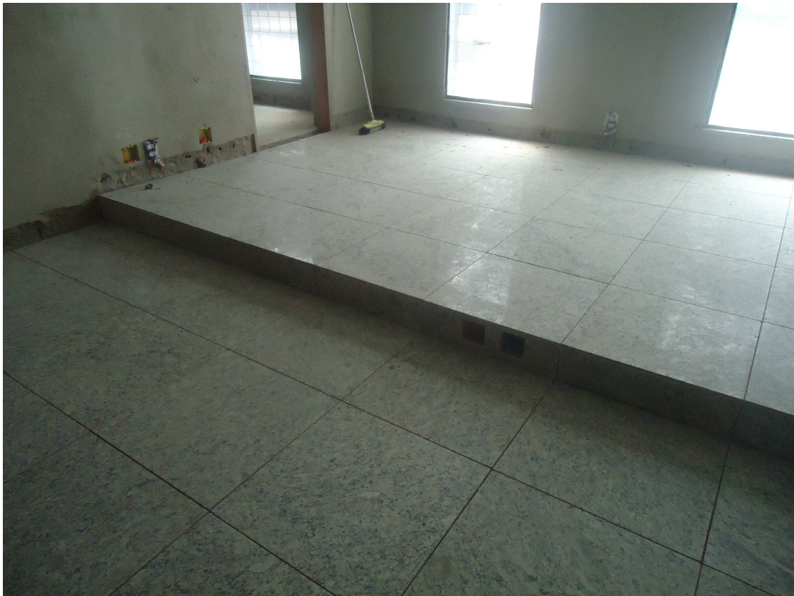
PISO GRANITO DATA: JANEIRO/2017
