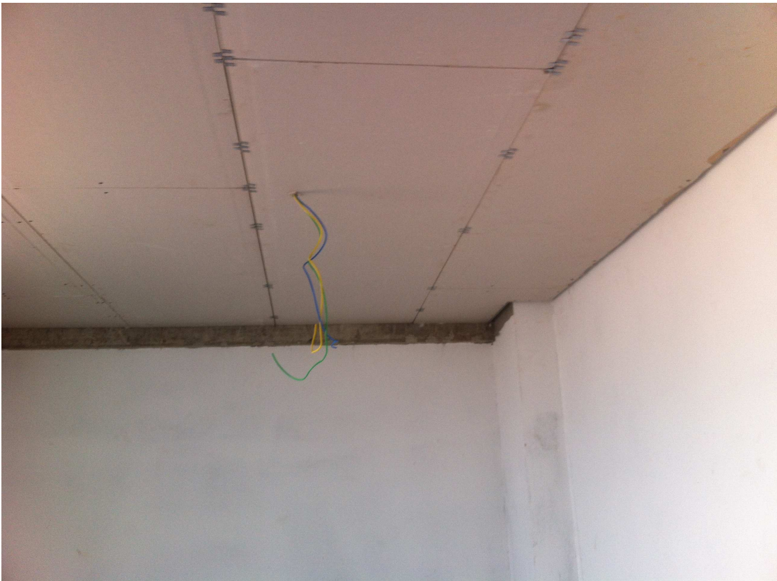
FORRO, EMASSAMENTO, CABOS DATA: FEVEREIRO/2017
