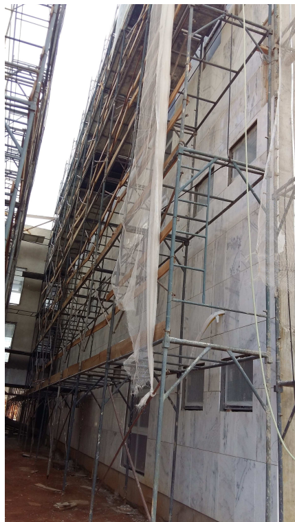
MÁRMORE, ANDAIMES, ESQUADRIAS DATA: FEVEREIRO/2017
