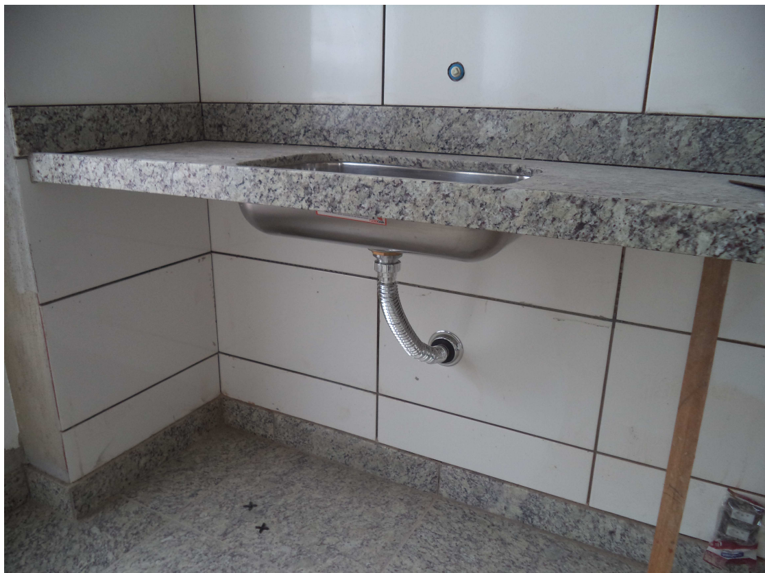
BANCADA COPA, CUBA, SIFÃO, CERÂMICA (AZULEJO), FAIXA, RODAPÉ DATA: FEVEREIRO/2017
