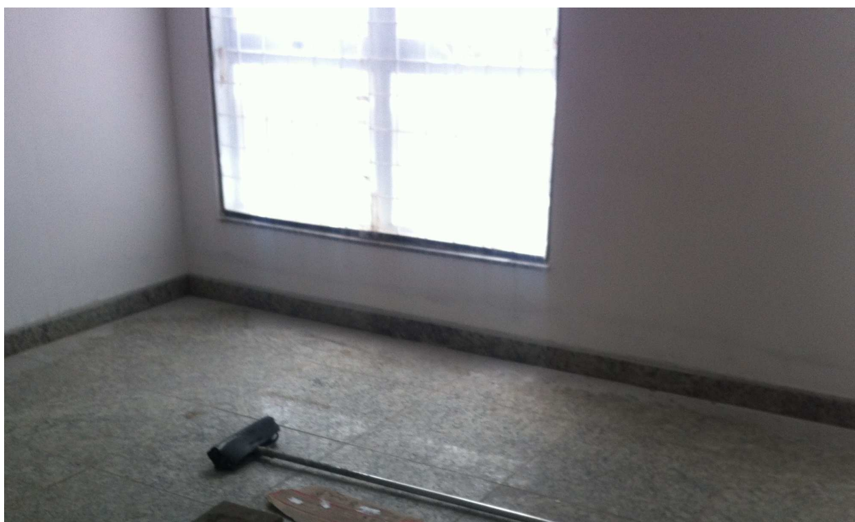
ESQUADRIAS, PEITORIL, IMPERMEABILIZAÇÃO ESQUADRIAS, PISO GRANIRO, EMASSAMENTO PAREDES, RODAPÉ DATA: FEVEREIRO/2017
