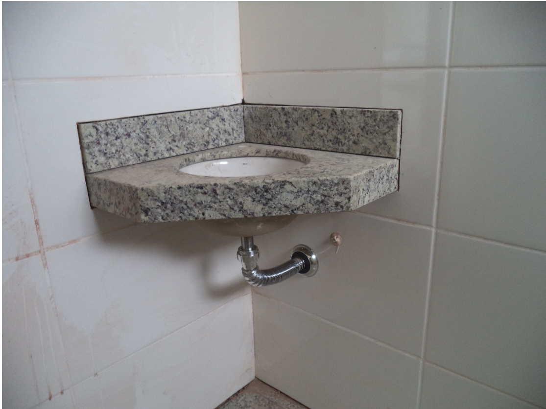
BANCADA BANHEIRO, CUBA, SIFÃO, CERÂMICA (AZULEJO) DATA: FEVEREIRO/2017
