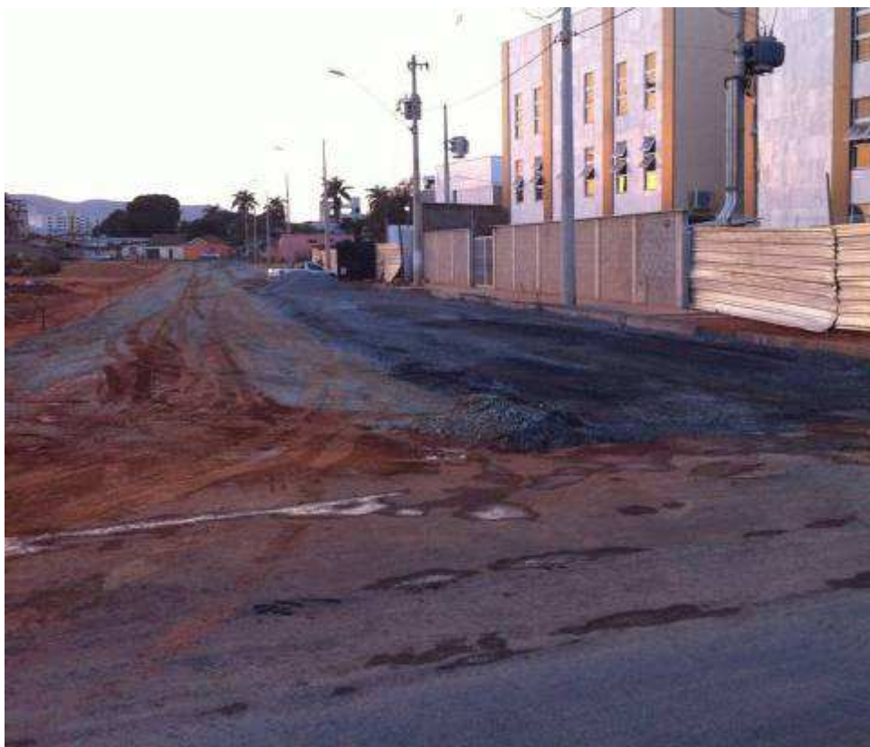
INÍCIO PAVIMENTAÇÃO DA RUA, PELA PREFEITURA DATA: AGOSTO/2017
