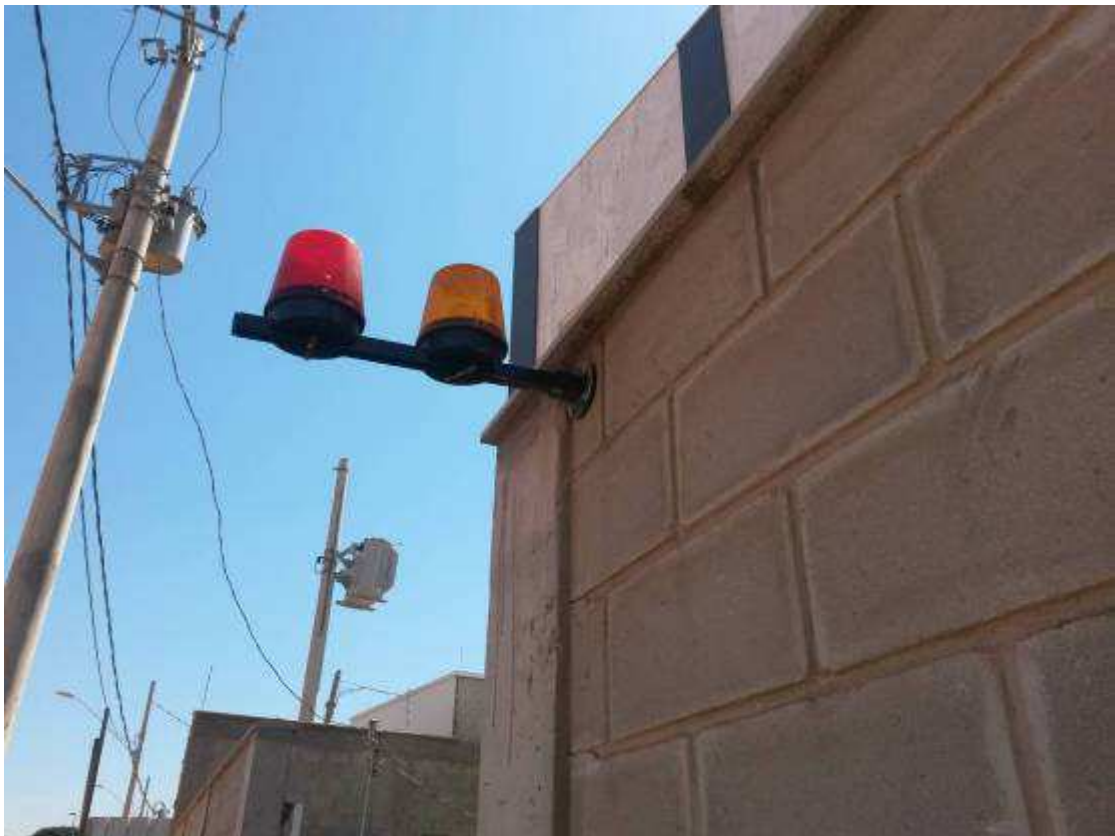
LUMINÁRIA SINALIZAÇÃO VEÍCULOS DATA: AGOSTO/2017
