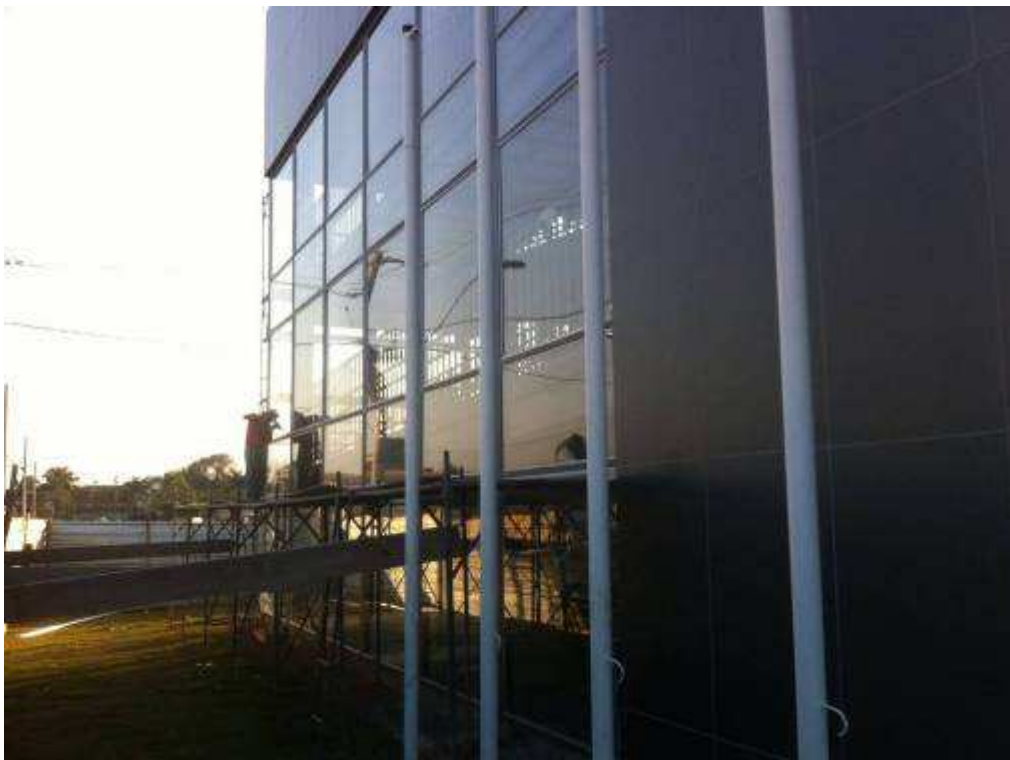
PAREDE DE VIDRO DATA: AGOSTO/2017
