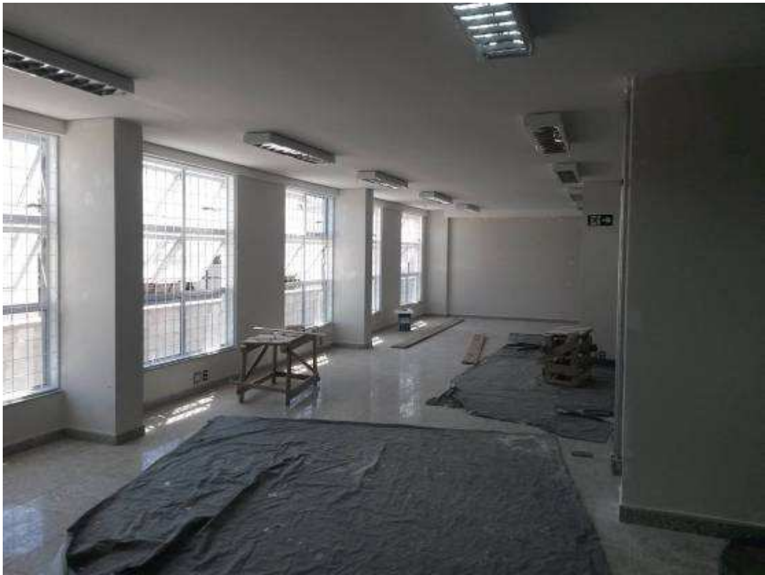
PINTURA, LUMINÁRIAS DATA: AGOSTO/2017
