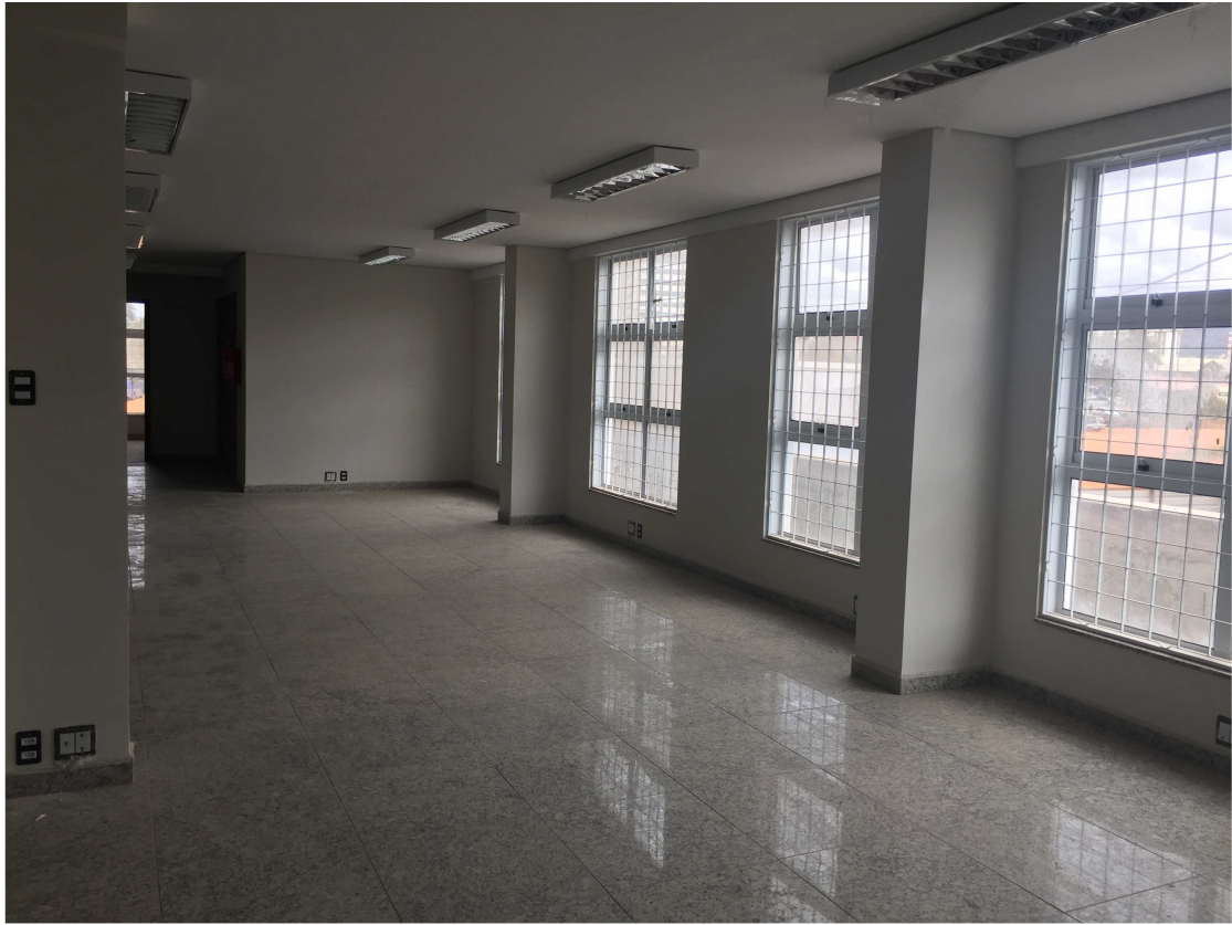
LUMINÁRIAS, VIDRO JANELAS, PINTURA PAREDES E FORRO, RODAPÉ DATA: JULHO/2017
