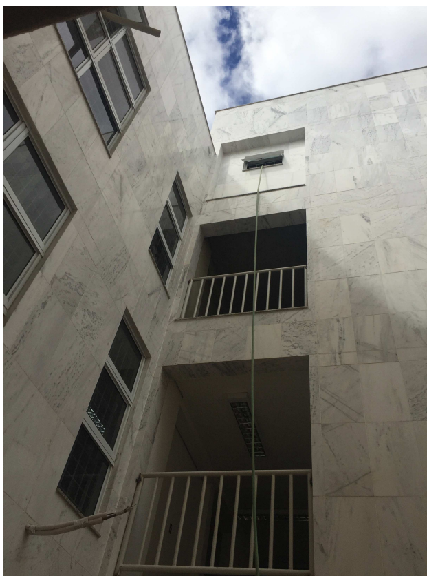
GUARDA-CORPO VARANDA DATA: JULHO/2017
