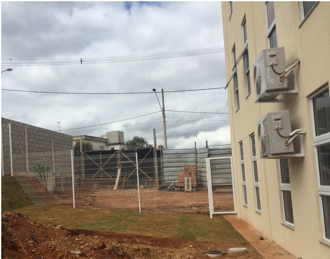
GRADIL, PASSEIO INTERNO DATA: JULHO/2017
