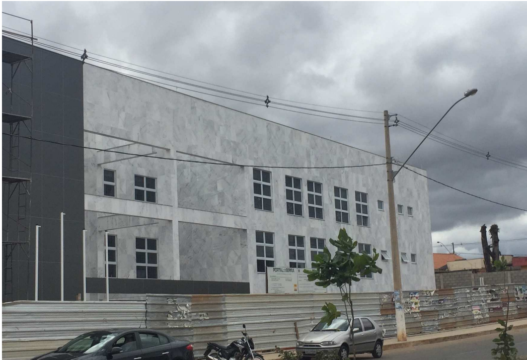
REVESTIMENTO EXTERNO (MÁMORE, GRAFIATO), MASTROS DATA: JULHO/2017
