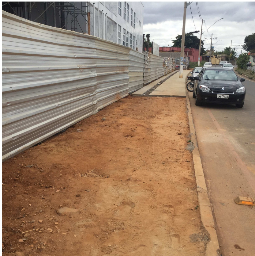
PASSEIO EXTERNO, MEIO-FIO DATA: JULHO/2017
