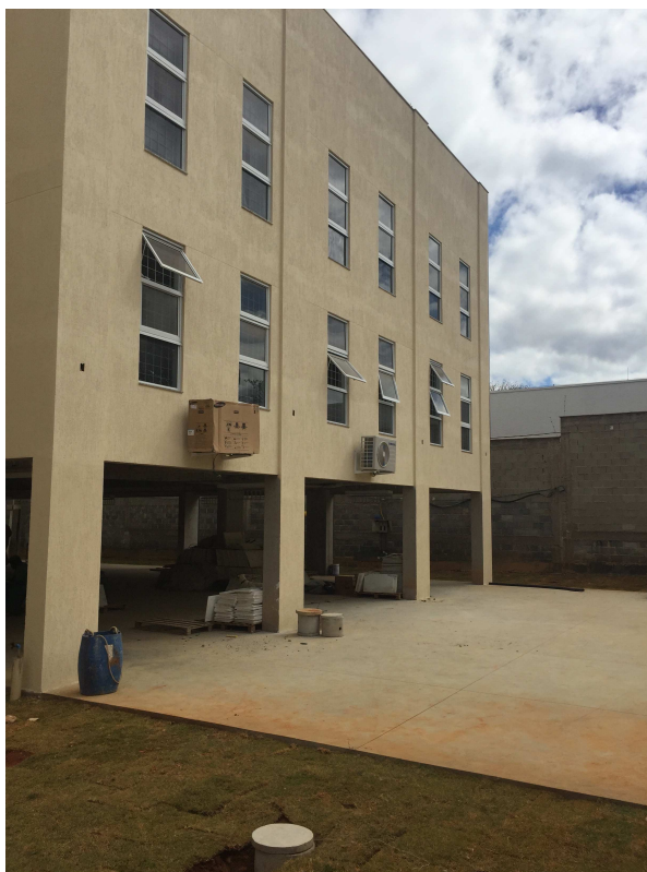
PISO ESTACIONAMENTO, REVESTIMENTO, VIDROS JANELAS, CONDENSADORAS DATA: JULHO/2017
