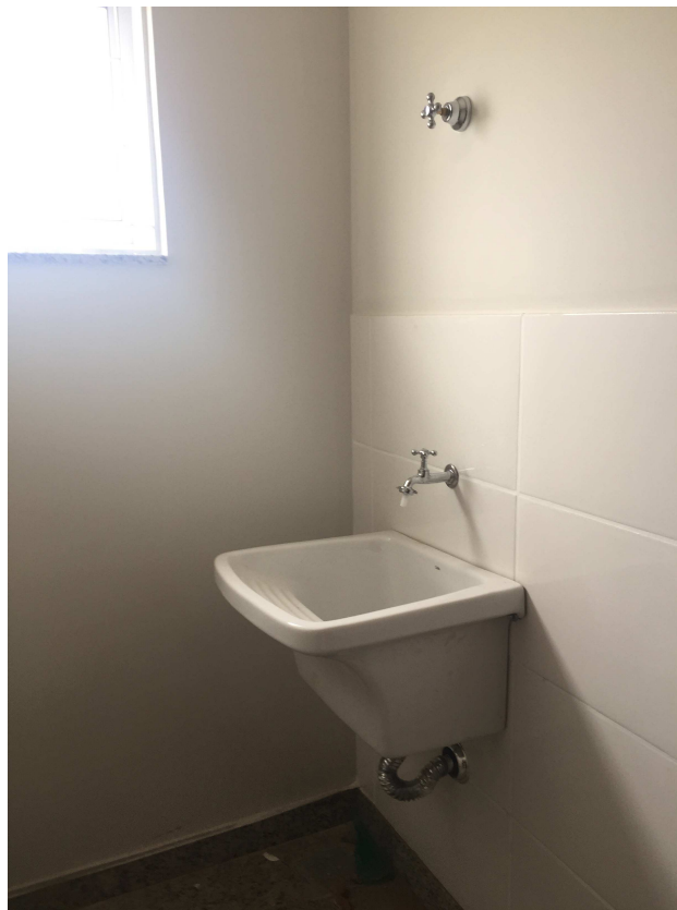
TANQUE, TORNEIRA TANQUE, REGISTRO, SIFÃO DATA: JULHO/2017
