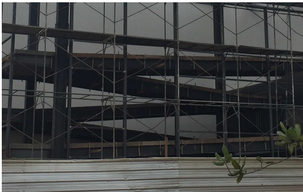
ESTRUTURA DA RAMPA E DA PELE DE VIDRO DATA: JULHO/2017
