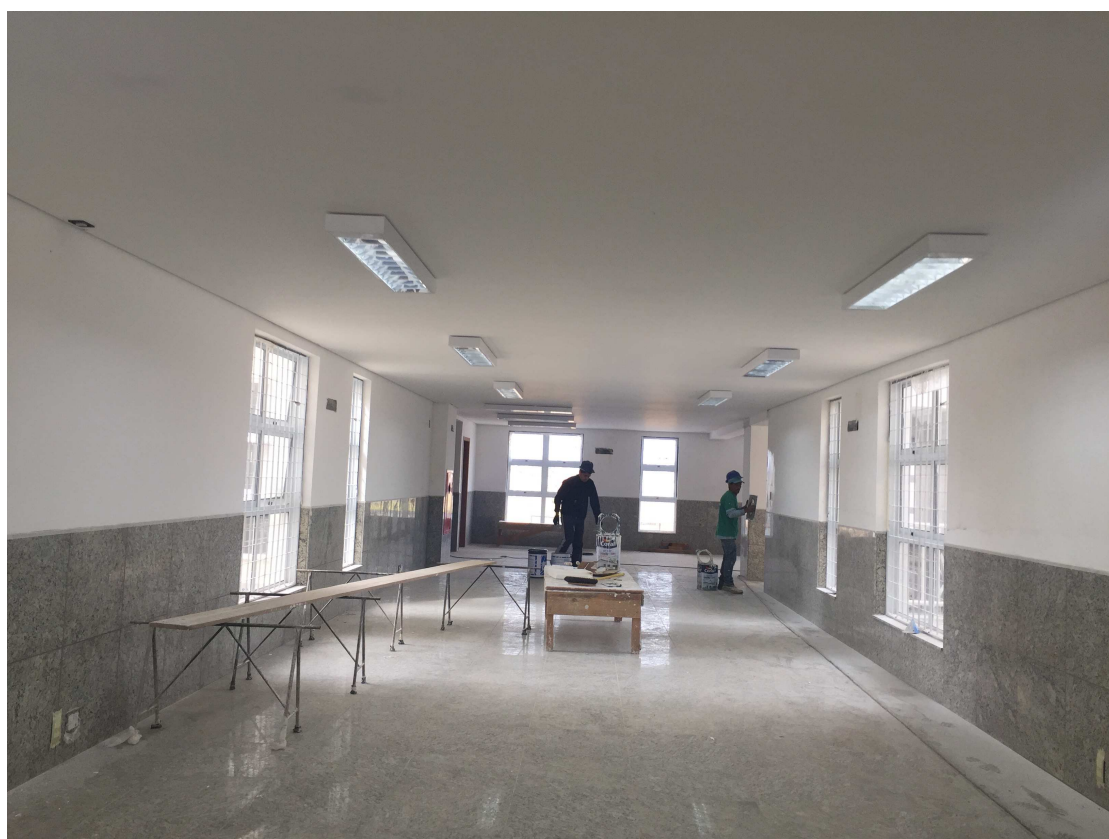
LUMINÁRIAS, GRANITO HALL, EMASSAMENTO DATA: JULHO/2017
