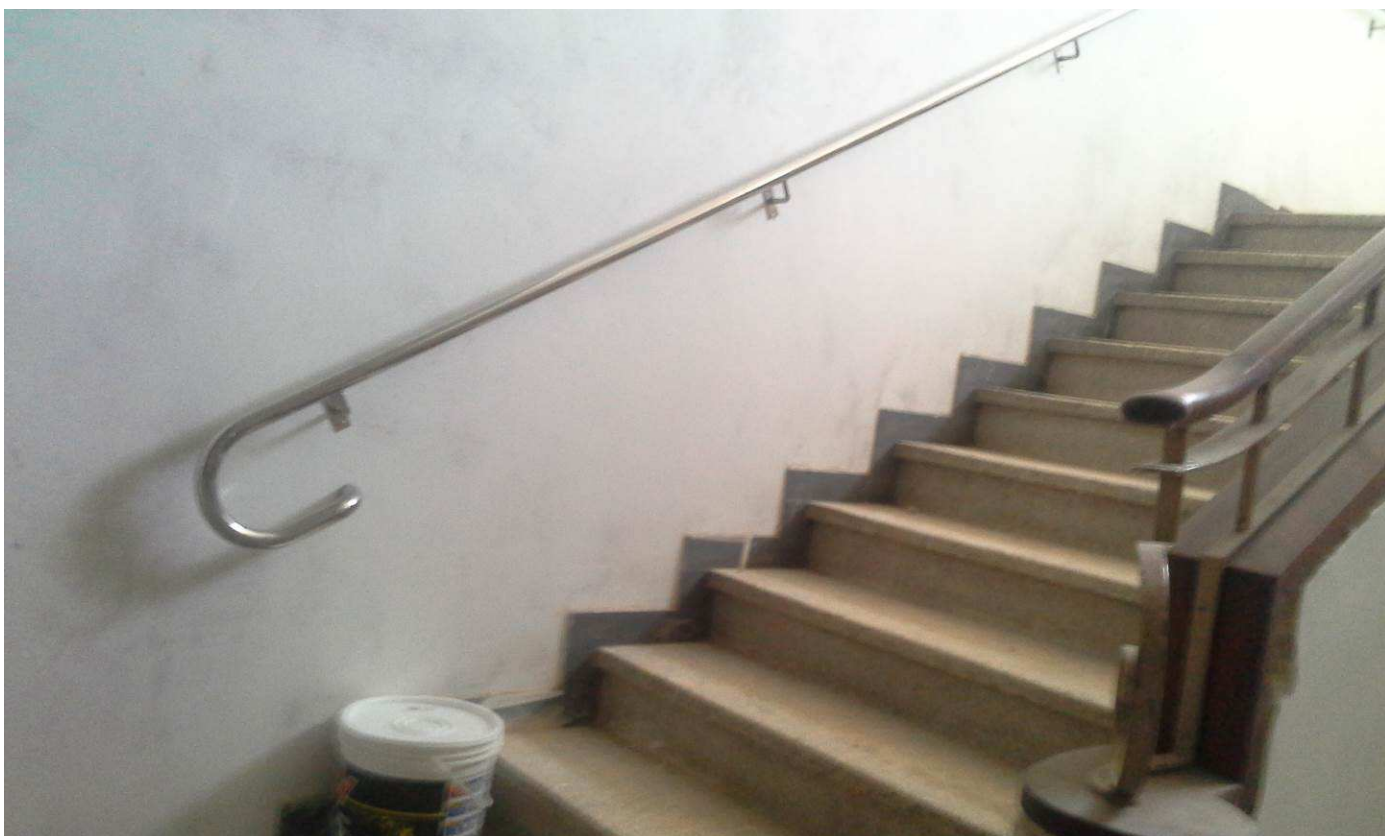
13. Serralheria - Corrimão de parede em inox - Mário Werneck
