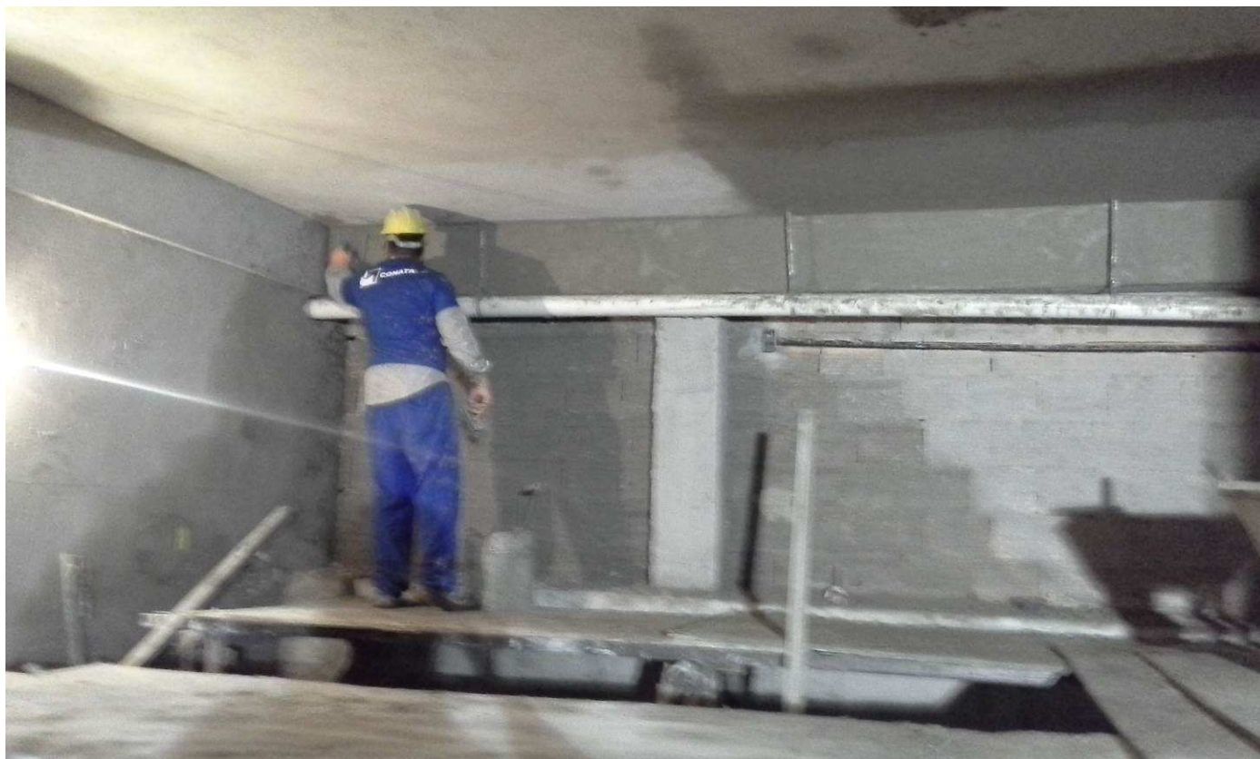
10. Revestimento - execução de chapisco e reboco interno paredes e teto
