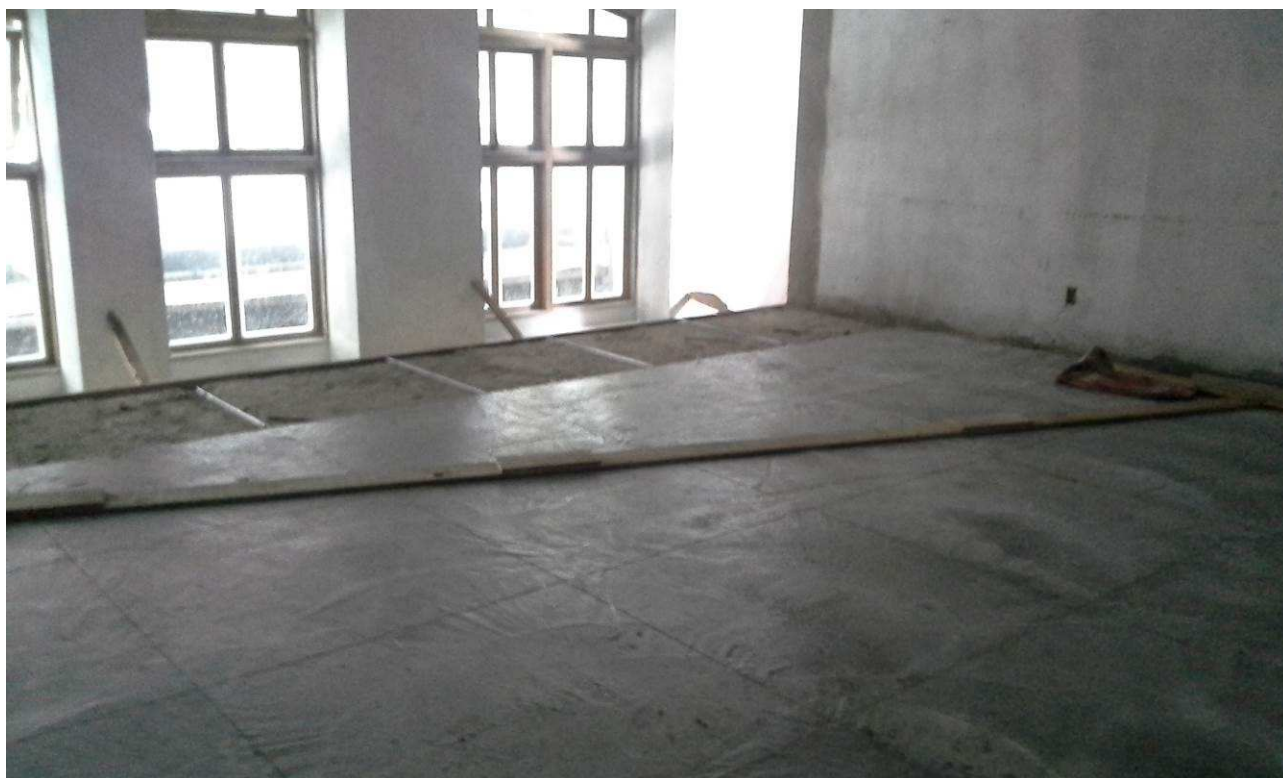
19. Pavimentação - Execução de granilite
