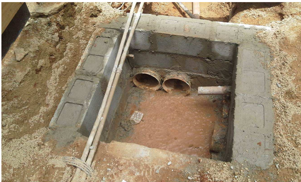
25. Instalações hidráulicas - caixa e tubos
