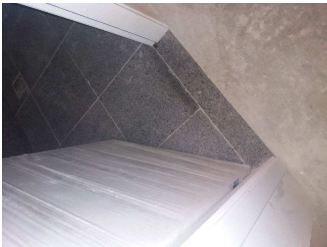
18. Pavimentação - Granito polido e soleira
