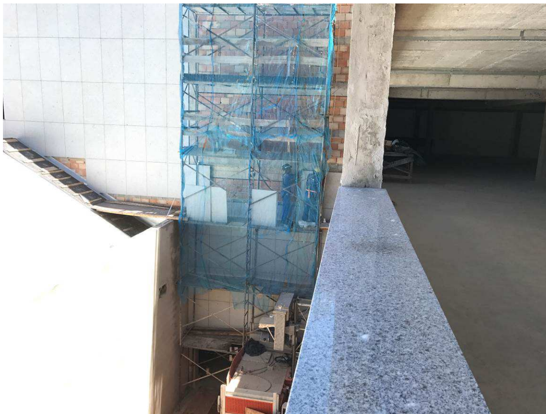
6. Andaime e tela, execução fachada granito aerado- Bloco 2 do estacionamento
