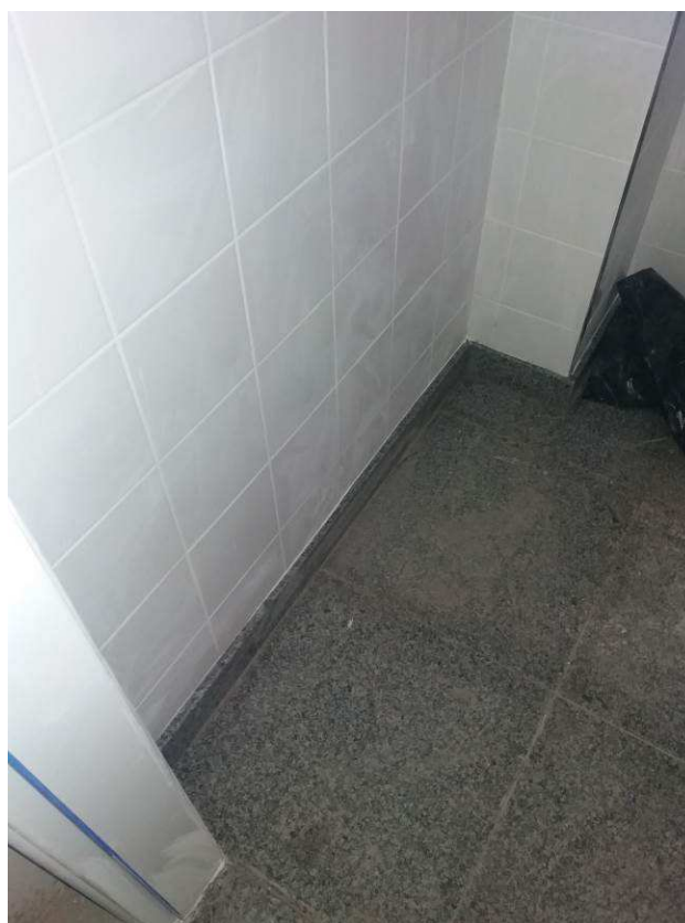
22. Pavimentação - Rodapé e granito polido
