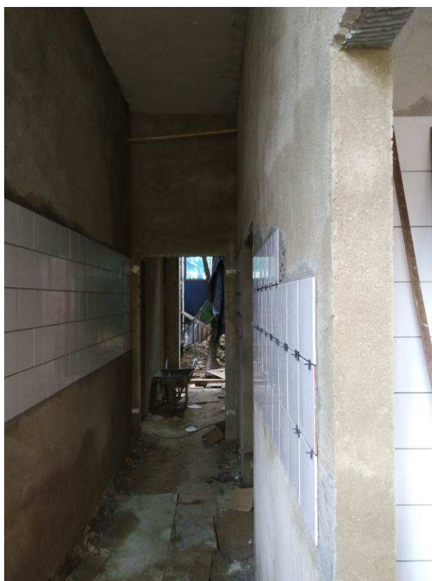
8. Revestimento - Emboço interno (sob a cerâmica)
