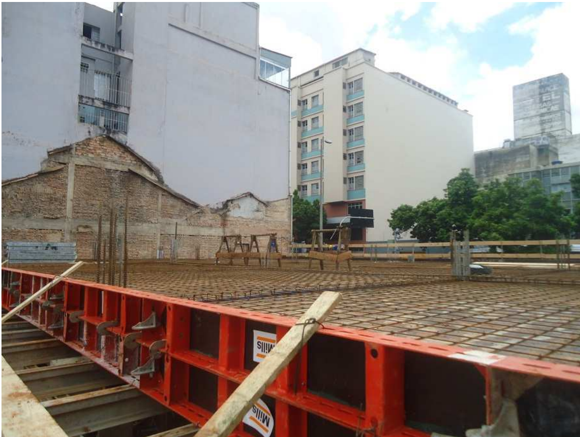
08 - Armação e formas de vigas e lajes do 1º pavimento - Bloco 1
