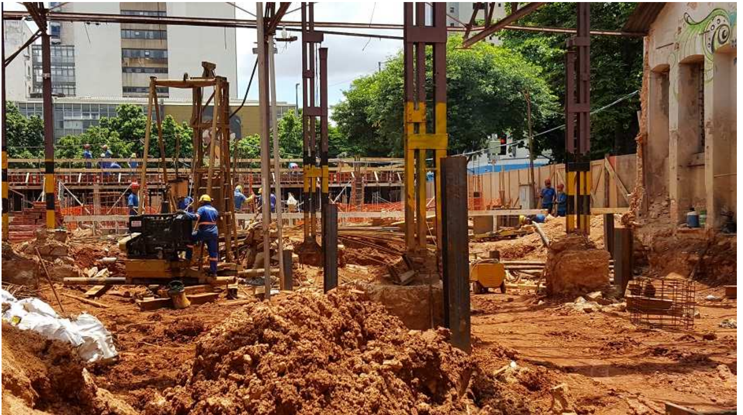
04- Cravação de estacas metálicas - Bloco 4
