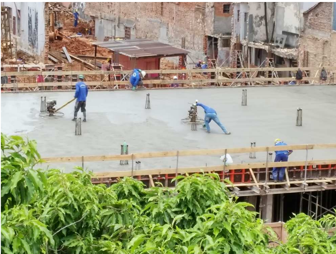
09 - Laje 1º pavimento - Bloco 1
