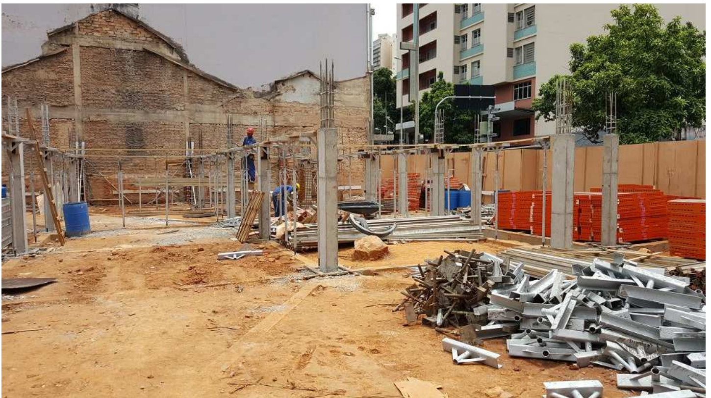
07 - Pilares e armação - Bloco 1
