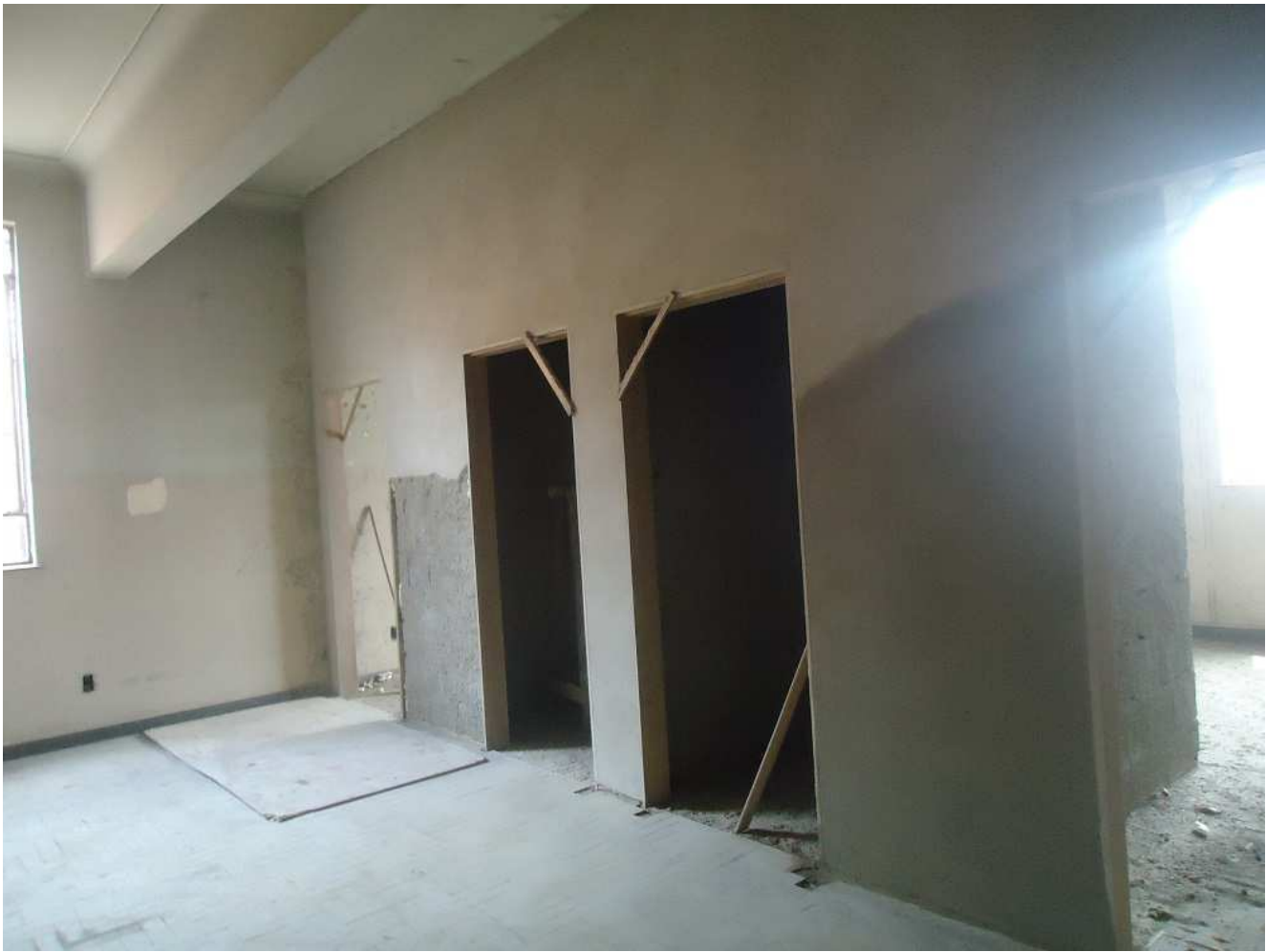
10 - Execução de alvenaria no Ed. Mário Werneck
