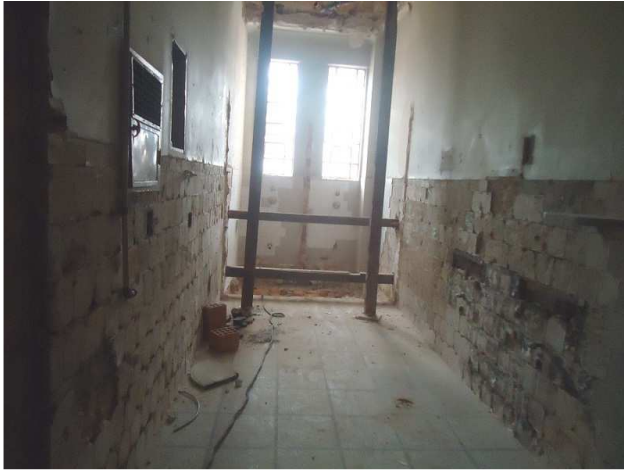
01 - Remoção de azulejos - Ed. Mário Werneck
