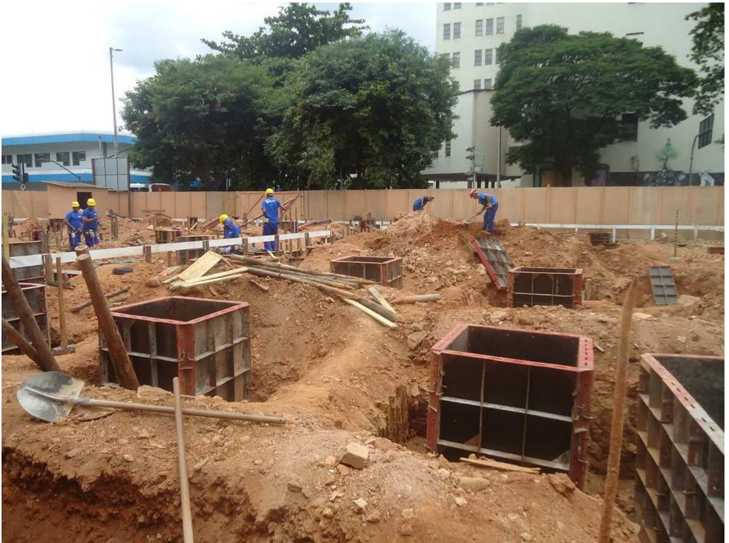
03 - Escavação manual de blocos para fundação - Bloco 2
