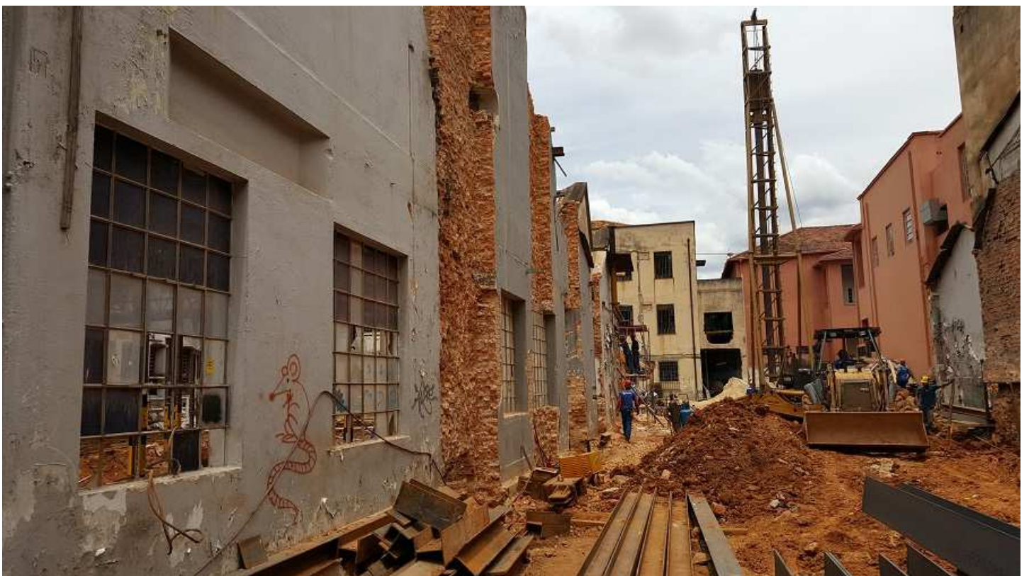
05 - Cravação de estacas metálicas - Bloco 3
