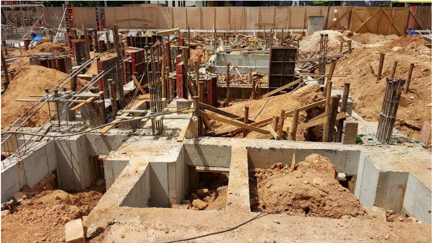
06 - Blocos de fundação e cintas concretados - Bloco 2
