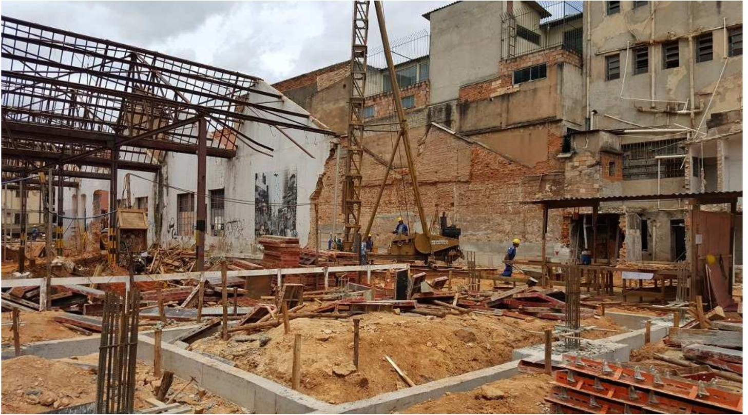
03- Cravação de estacas metálicas e blocos de fundação e cintas concretados - Bloco 2
