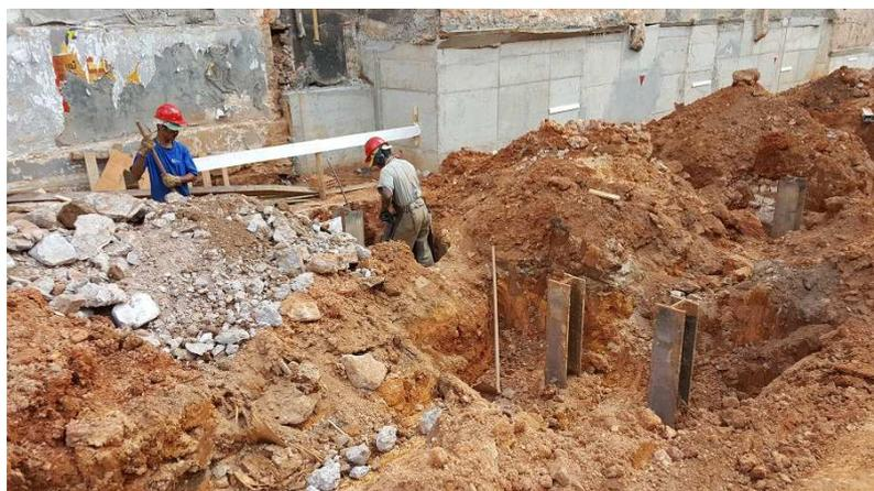
01 - Escavação manual de blocos para fundação nos Blocos 4 e 3, respectivamente.
