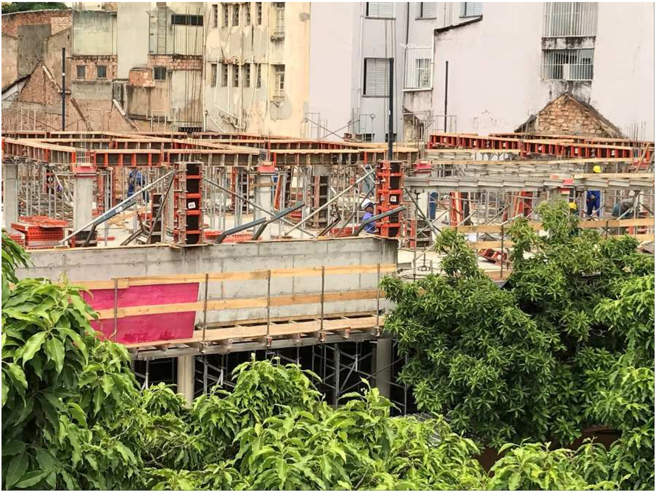
05 - Estrutura do piso 4 - Bloco 1
