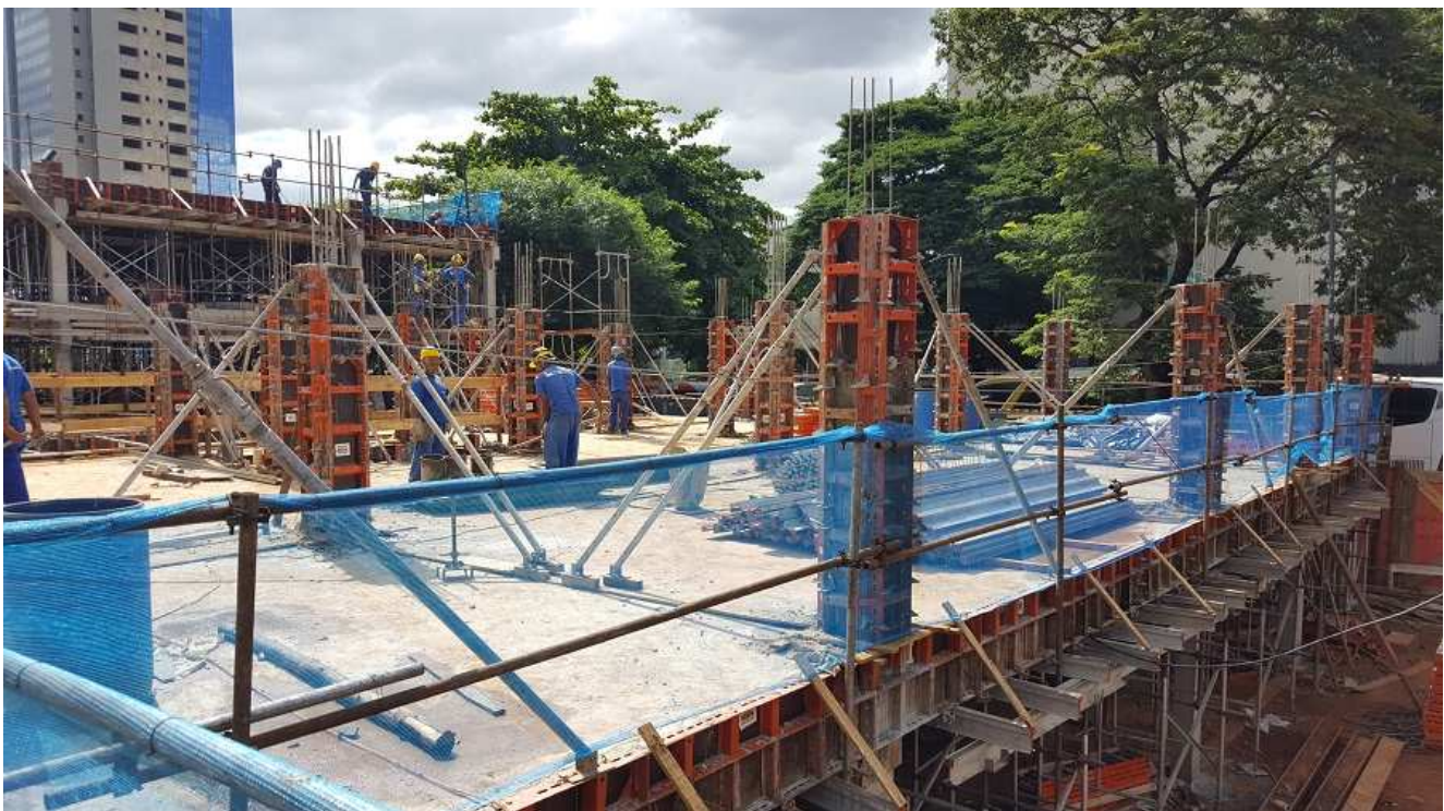
06 - Estrutura do piso 3 - Bloco 2
