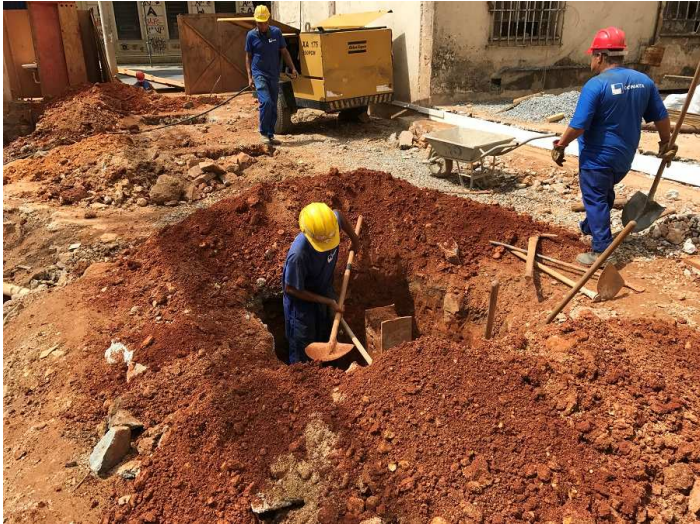
01 - Escavação manual de blocos para fundação no Bloco 4.
