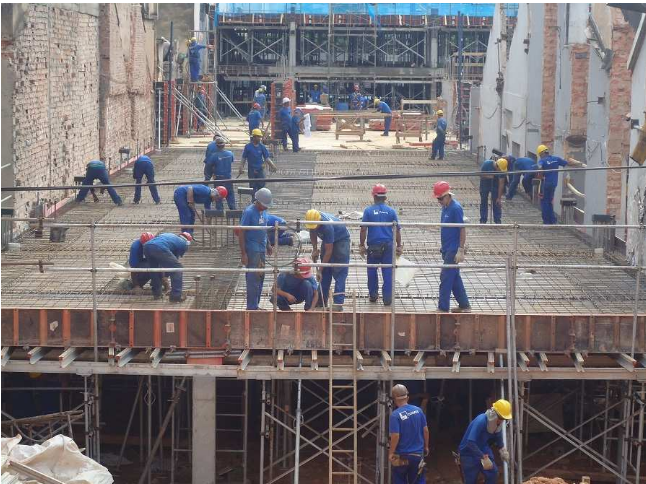
08 - Armação piso 2 - Bloco 3
