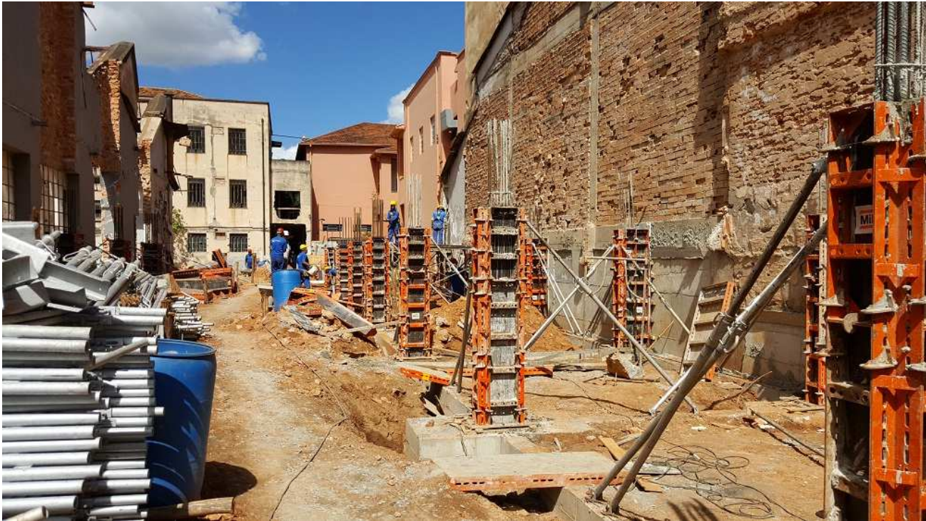
07 - Estrutura do piso 2 - Bloco 3
