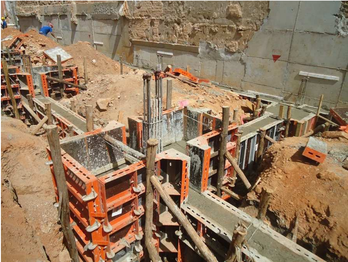
03- Blocos de fundação e cintas concretados - Bloco 3
