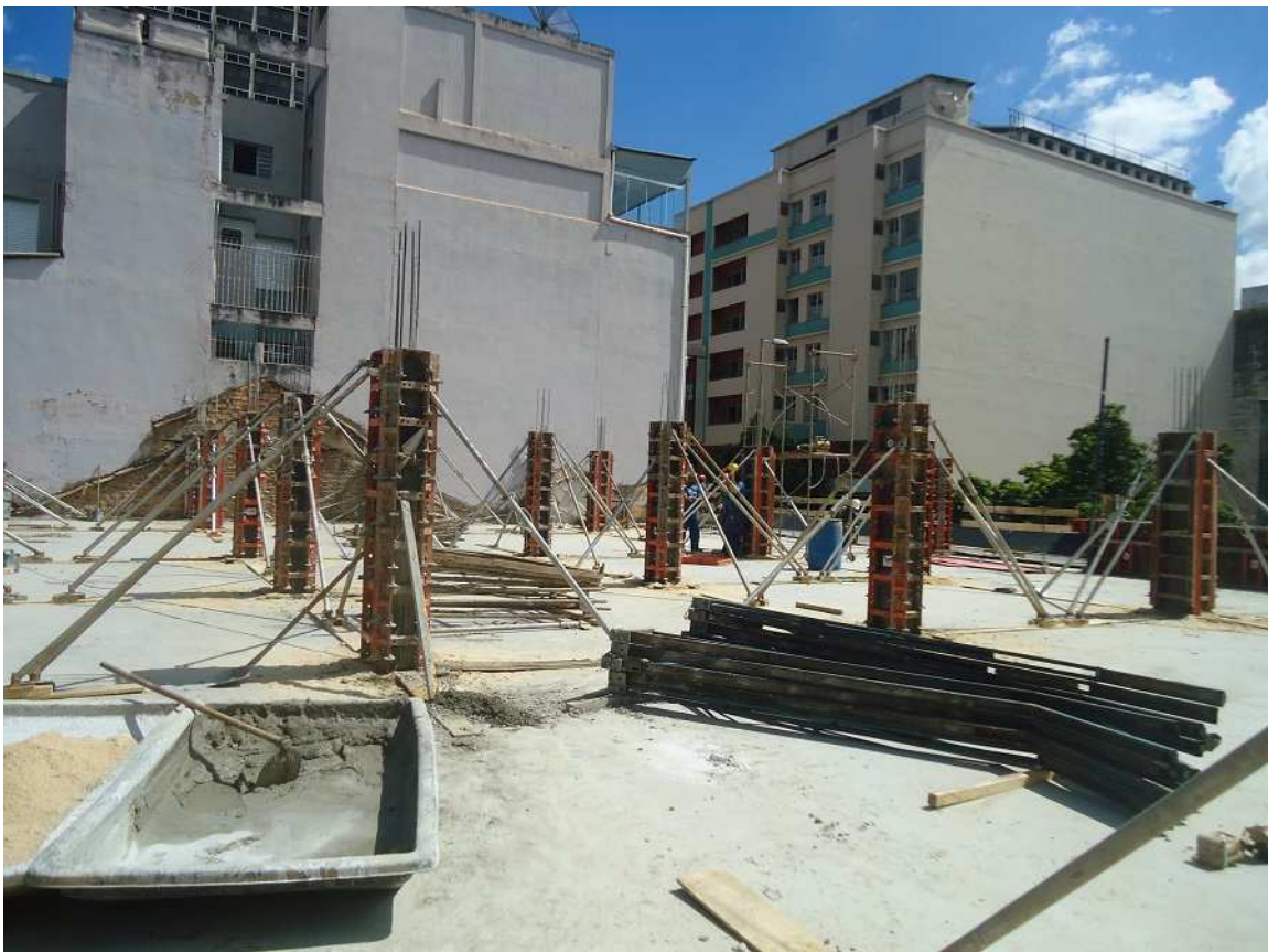
04 - Estrutura do piso 4 - Bloco 1
