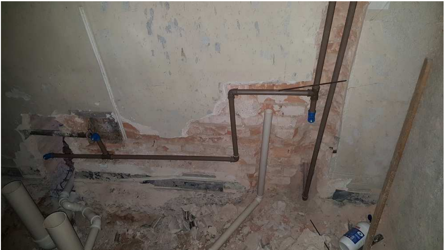
15 - Edifício Mário Werneck - I.S. Diretor (instalações hidrossanitárias).
