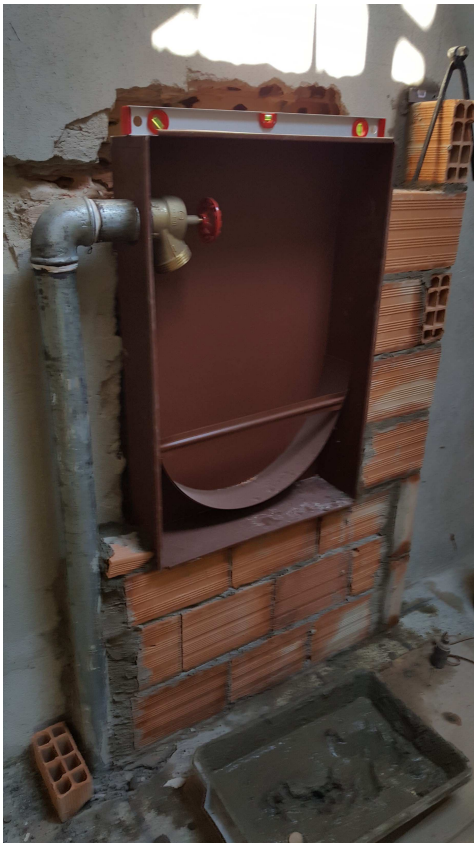
17 - Edifício Mário Werneck - Instalações de combate à incêndio.
