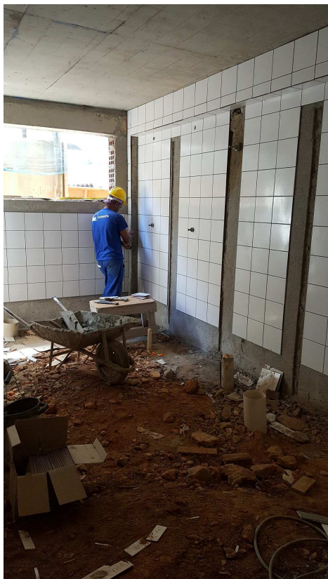
14. Revestimento cerâmico - Vestiário do bloco 2 e I.S do piso 2 no bloco 4
