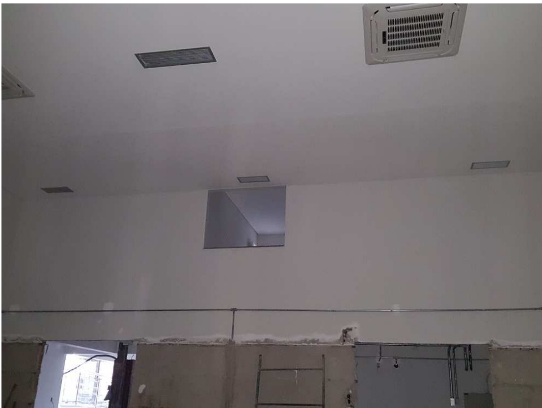
2. Instalação de ar condicionado – Grelhas auditório – Piso 1 da Oficina Christiano Ottoni
