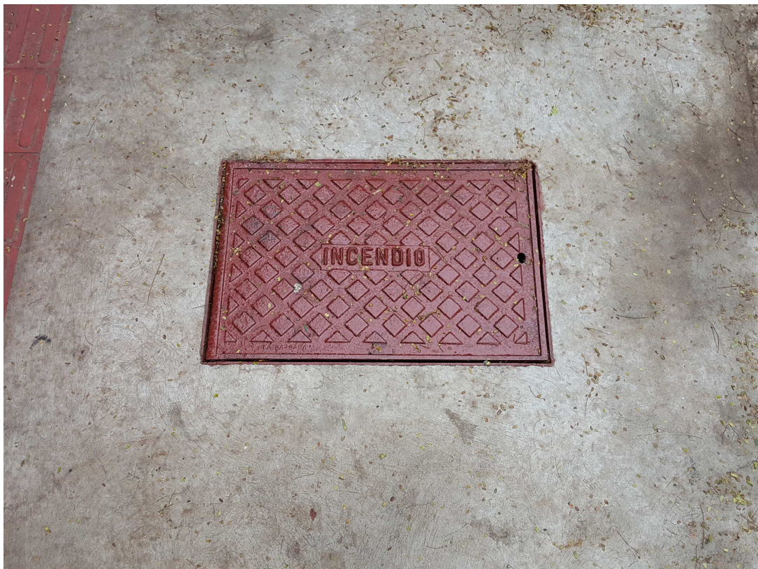
14. Instalações de combate a incêndio – Tampa para hidrante de recalque – Passeio rua Guaicurus
