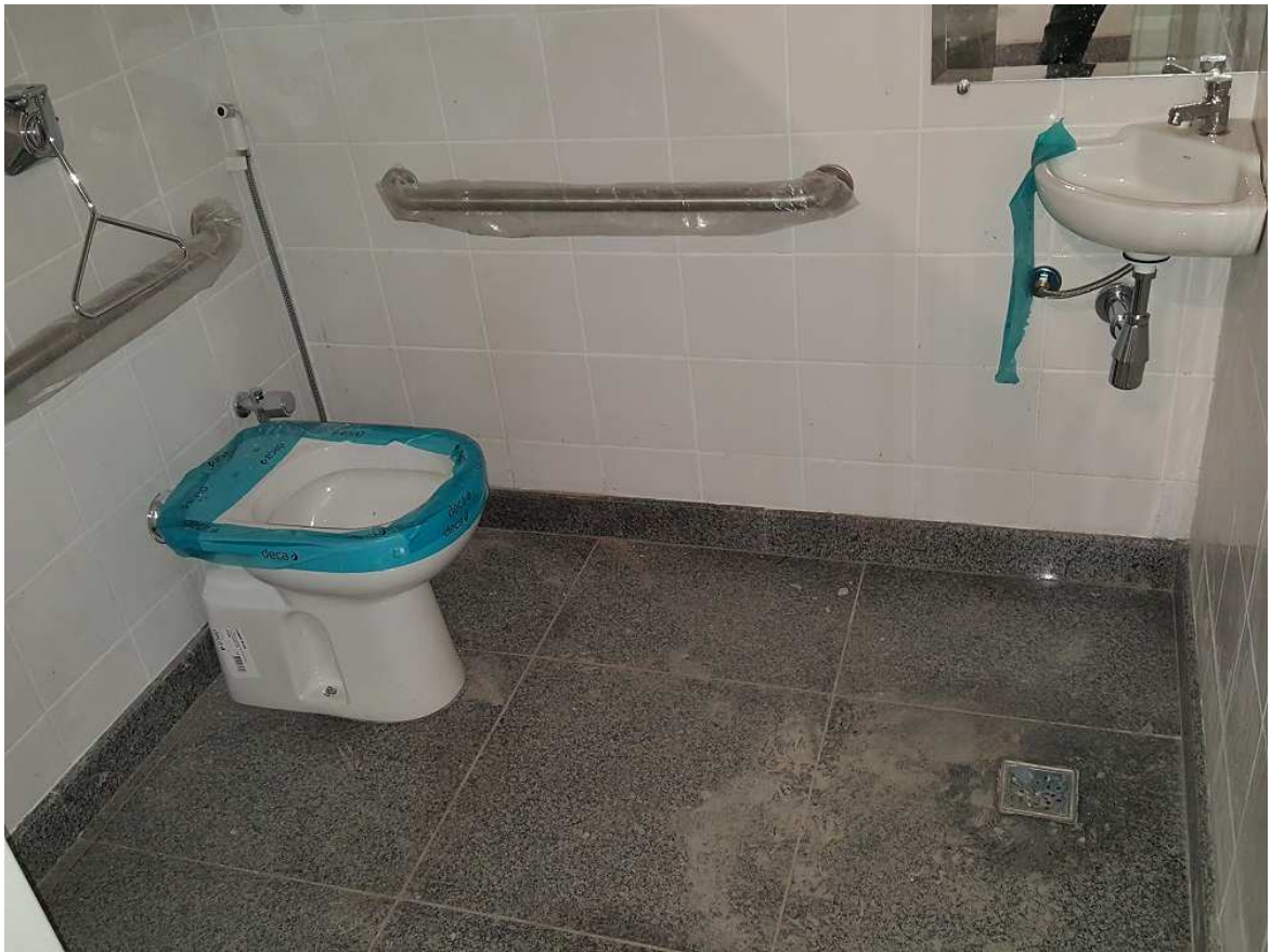
7. Instalações Hidráulicas e Sanitárias – I.S.A - Piso 2 da Oficina Christiano Ottoni
