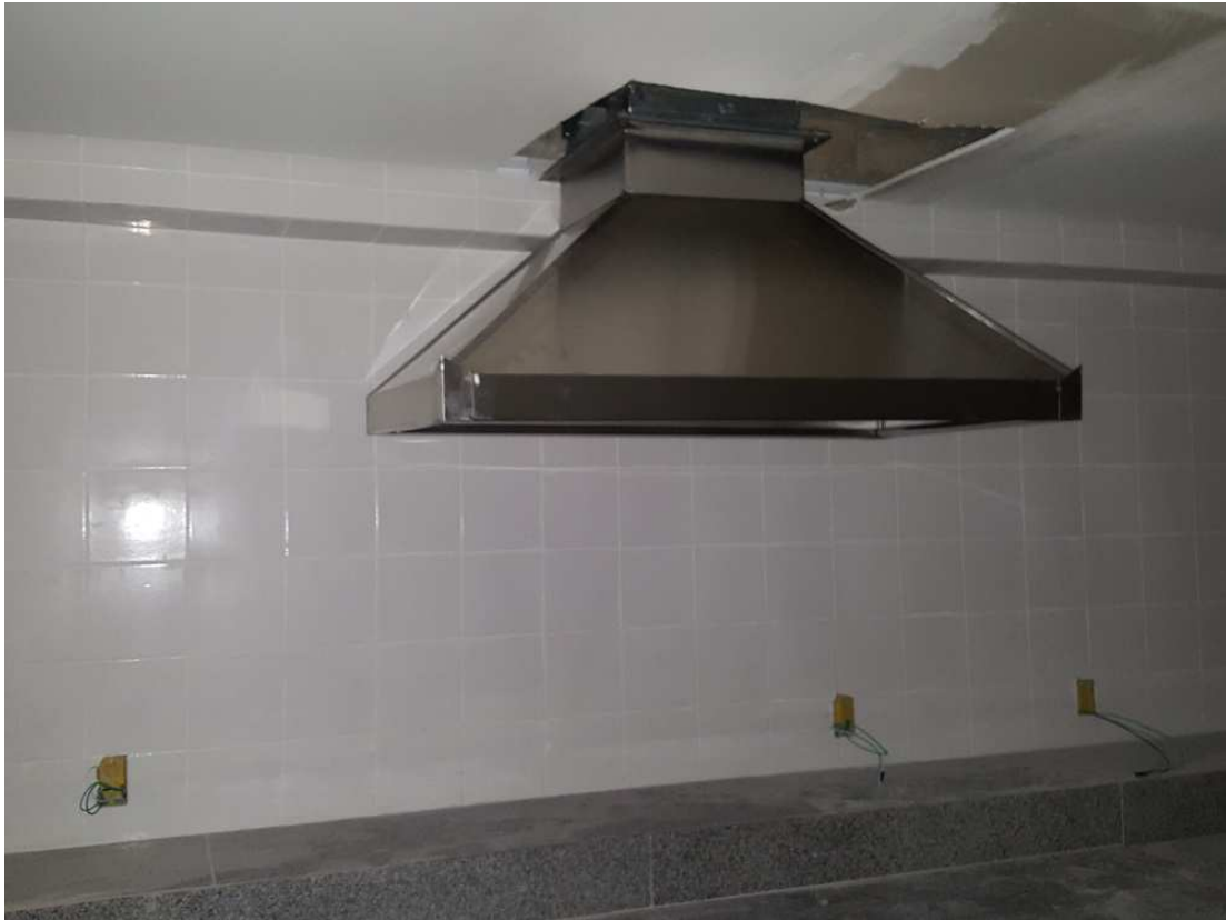
1. Instalação de ar condicionado – Coifa da cozinha – Piso 1 da Oficina Christiano Ottoni
