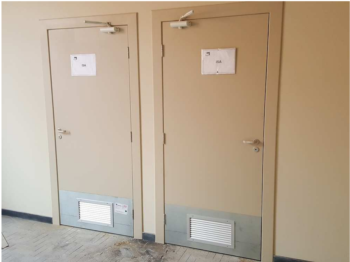
3. Instalação de ar condicionado – Grelhas das portas do I.S.A – 3º pvto. do Edifício Mário Werneck
