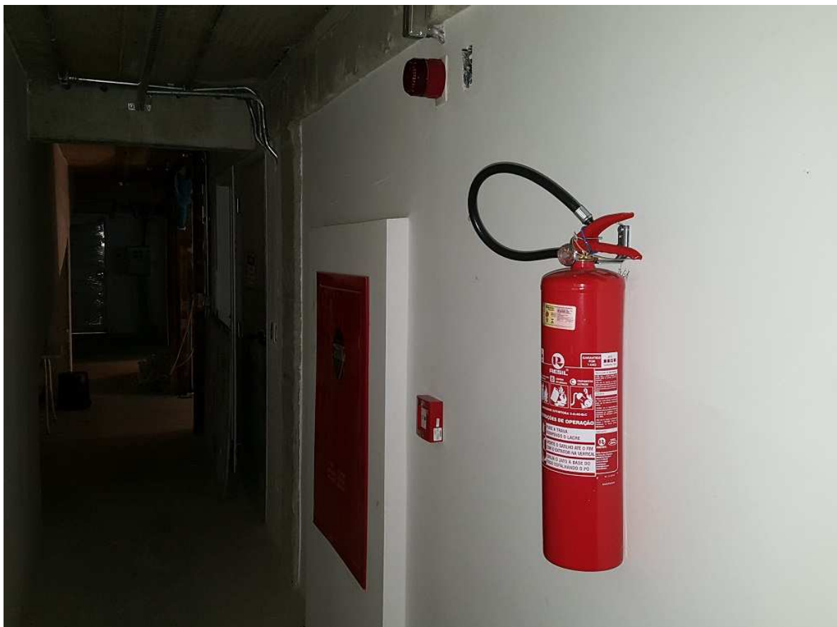
12. Instalações de combate a incêndio – Estacionamento
