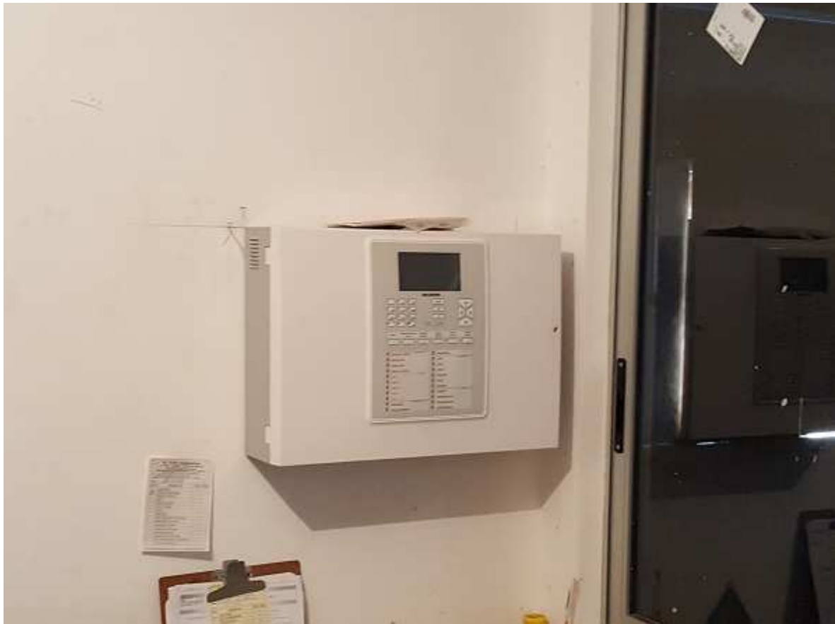
11. Instalações de combate a incêndio – Central de Alarme – 1º pvto. do estacionamento
