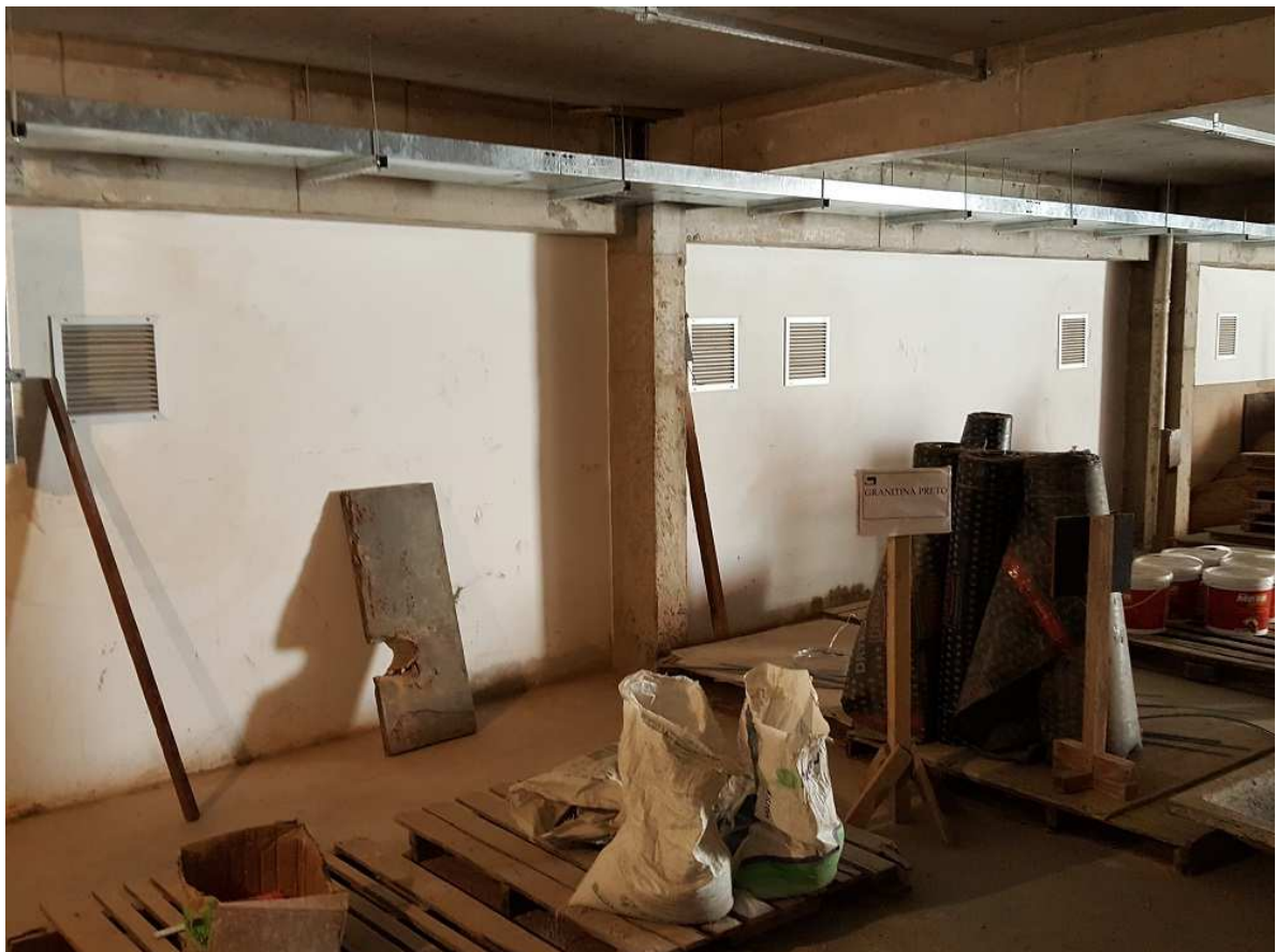
4. Instalação de ar condicionado – Venezianas – 1º pvto. do estacionamento
