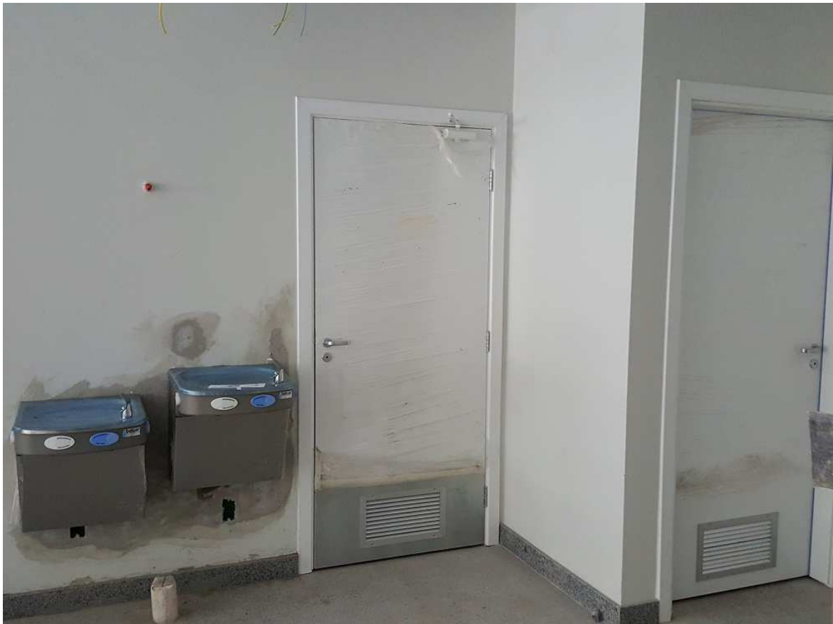
5. Instalações Hidráulicas e Sanitárias – Bebedouros – Piso 3 da Oficina Christiano Ottoni
