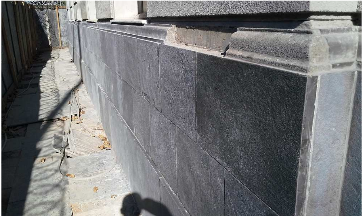
1. Revestimento – Limpeza do barrado em ardósia – Edifício Mário Werneck
