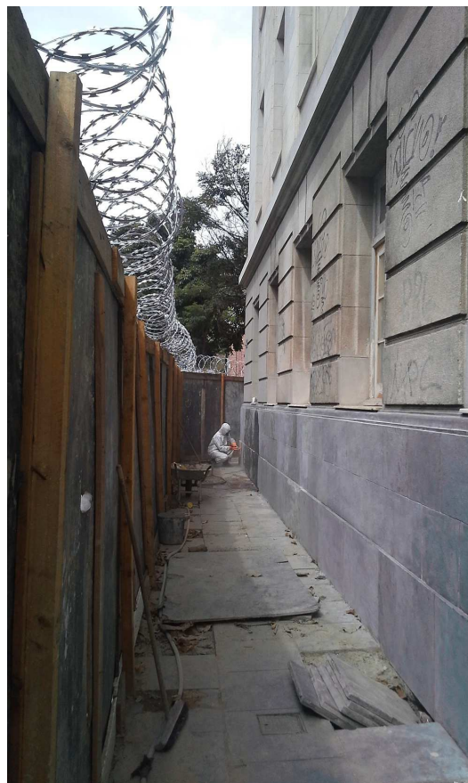
2. Revestimento – Limpeza do barrado em ardósia – Edifício Mário Werneck
