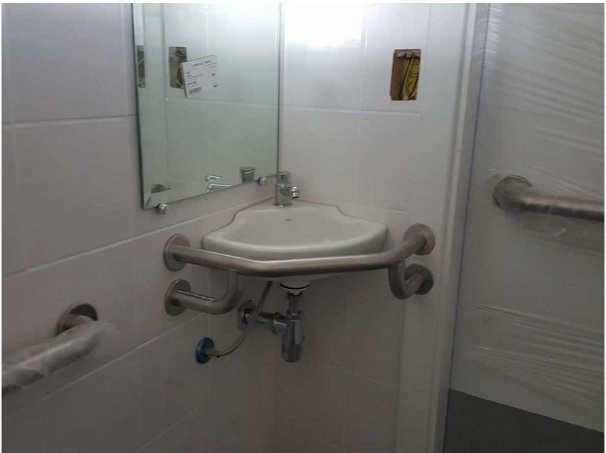
4. Hidráulica – Barra de apoio para lavatório – I.S.A do estacionamento
