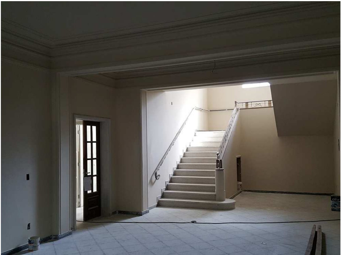
3. Pintura de paredes e teto – Edifício Mário Werneck
